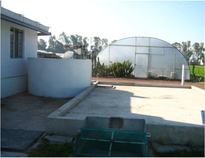
Foto 31. Captación de agua
