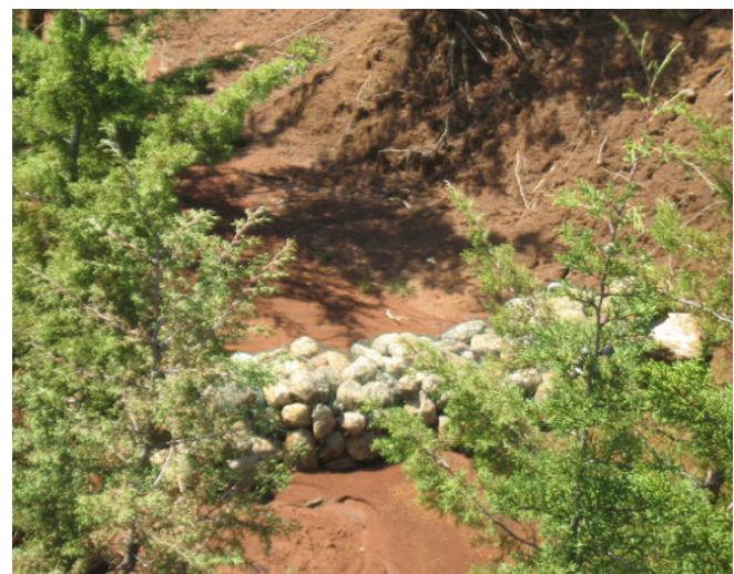
Foto 24. Muro de Gavión
