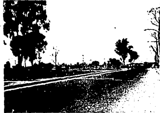
CAJAZGA DE LA VIGA
