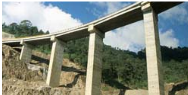
Fig 1.2 Foto del puente Maltrata, carretera Córdoba - Veracruz
