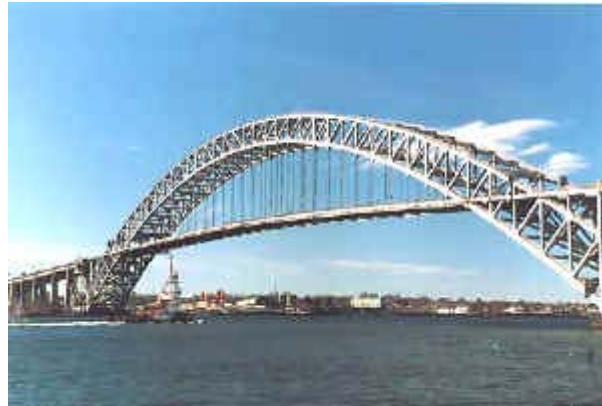
Fig 1.9 Foto del puente Arco de Acero Bayonne, Bayonne, New Jersey, EUA
