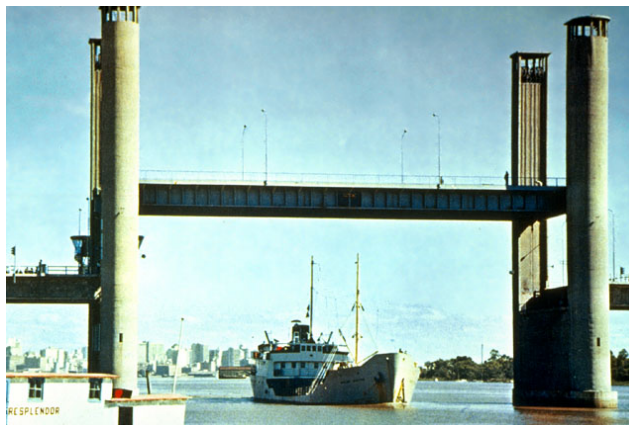
Fig 1.14 Foto del puente sobre el río Guiaba, Porto Alegre, Brasil
