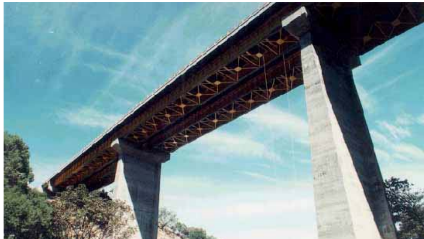
Fig 1.1 Foto del puente viaducto Los Gorriones, autopista Guadalajara – Tepic
