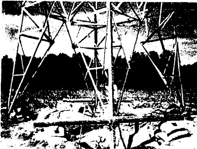
NIVELADO DE BOTTOM PANEL
