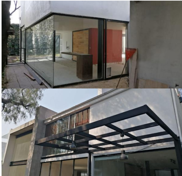
Imagen 68 (arriba). Demolición de pisos interiores finalizada. Fotografía tomada personalmente en sitio. Imagen 69 (abajo). Desmantelamiento de cubiertas de cristal. Fotografía tomada personalmente en sitio.
