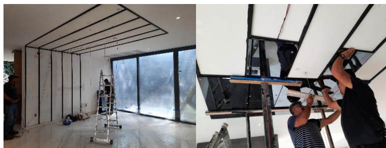
Imagen 76. Proceso de instalación de lambrín. Fotografía tomada personalmente en sitio
