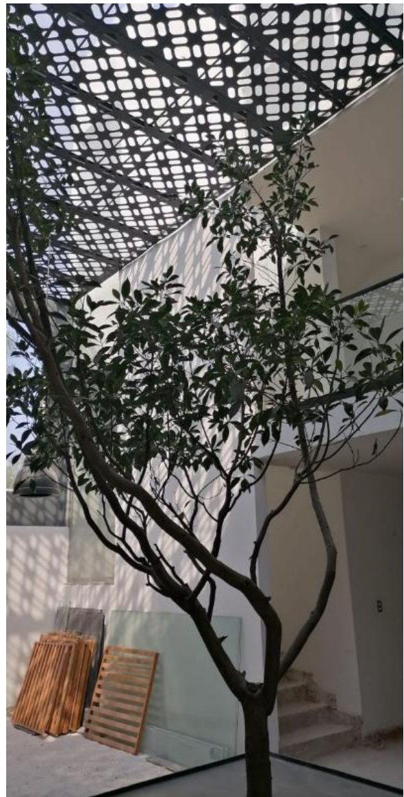
Imagen 66. Proceso del desmantelamiento y resguardo de elementos. Fotografía tomada personalmente.
