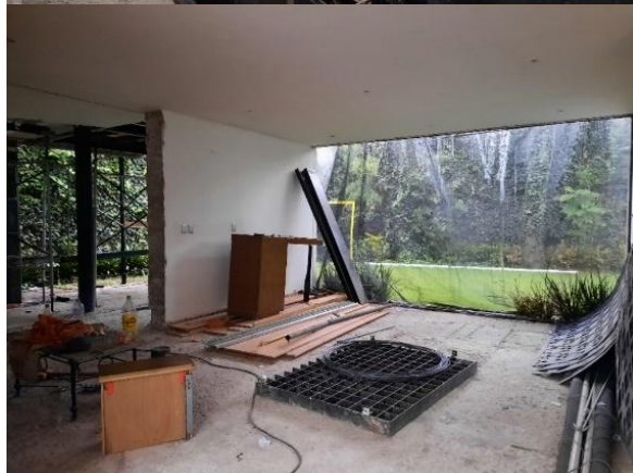
Imagen 64 (arriba). Trabajos realizados en el área del comedor. Fotografía tomada personalmente.
