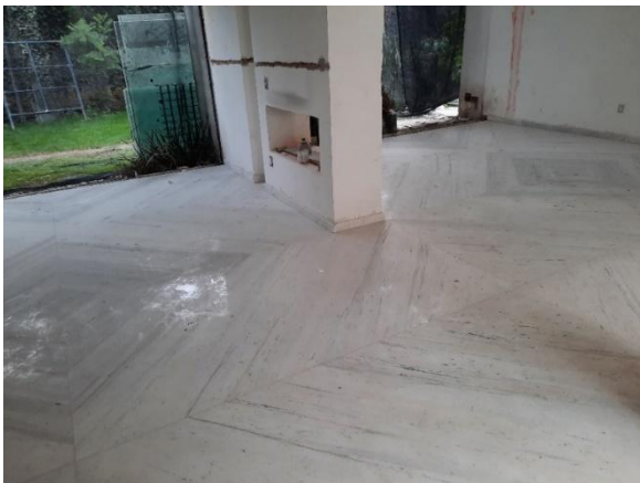
Imagen 70. Piso de mármol nuevo colocado según planos. Fotografía tomada personalmente en sitio.
