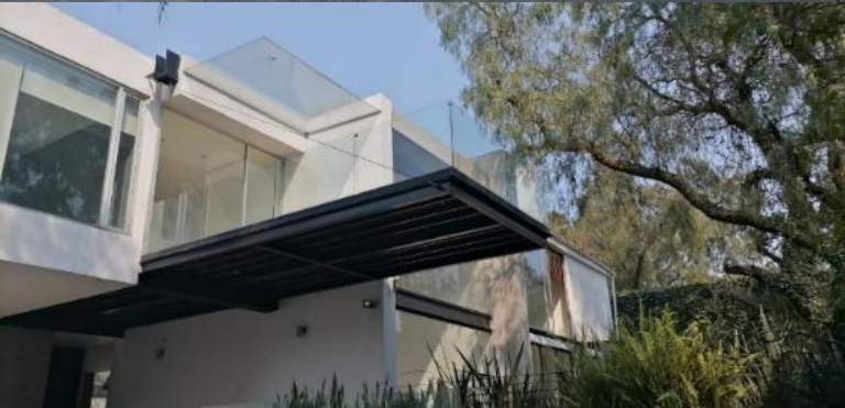
Imagen 08 (arriba). Escalera de acceso a la planta baja de la casa. Fotografía tomada personalmente en sitio. Imagen 09 (abajo). Terraza de planta alta vista desde el acceso. Fotografía tomada personalmente en sitio.
