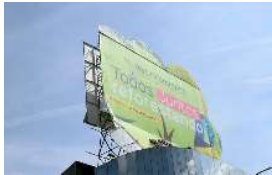
Figura 1.5 Lamina se desprende de espectacular, Aguascalientes ( http://www.lja.mx/2017/07/ )
