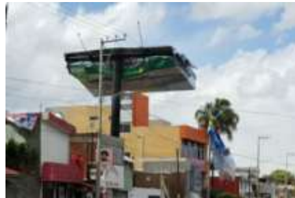
Figura 1.19 Falla espectacular en Puebla, 2016 ( https://intoleranciadiario.com/articles/2016/03/10/142134-caida-de-arboles-y-espectaculares-la-constante-de-la-jornada.html ).
