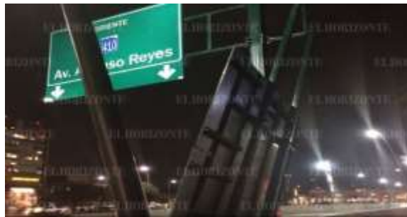
Figura 1.18 Espectacular caído en Nuevo León ( http://www.elhorizonte.mx/local/tormenta-electrica-y-fuertes-vientos-sorprenden-a-regios/1676414 ).
