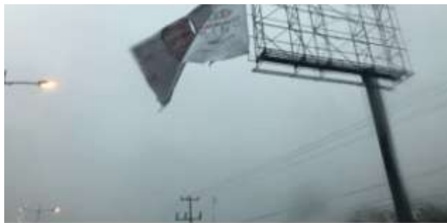
Figura 1.21 Lona se desprende de espectacular debido al frente frío 44, abril de 2016 ( https://www.yucatanalamano.com/destacado/fuerte-lluvia-desquicia-cancun-se-caen-espectaculares-y-arboles/ )
