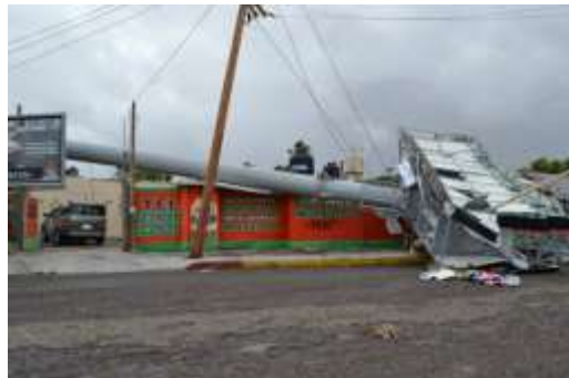
Figura 1.7 Espectacular derribado por las ráfagas ocasionadas por el huracán Odile ( http://www.bcsnoticias.mx/el-85-de-las-estructuras-derribadas-por-odile-en-la-paz-eran-anuncios-y-espectaculares/ )
