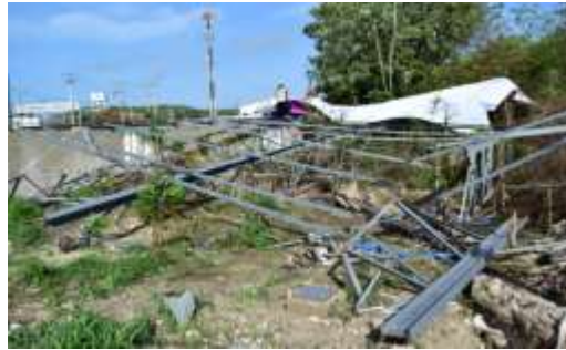
Figura 1.8 Campeche 2017, se revisan espectaculares para evitar riesgo a los ciudadanos ( http://tribunacampeche.com/local/2017/06/03/supervisan-estructuras-anuncios-espectaculares/ )
