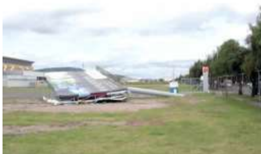
Figura 1.14 Espectacular derrumbado en centro de exposiciones en Irapuato ( http://notus.com.mx/clausuran-espectaculares-el-primero-que-se-cae-es-un-edificio-publico/ )
