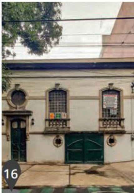
Casa-habitación Ubicación: Durango no. 134, Roma Norte, Cuauhtémoc, Ciudad de México Autor(a): No disponible Fecha de realización: Principios siglo XX Materiales: Cantera en exteriores, interiores en viga de madera, loseta de mármol bicolor Fecha de declaratoria: 13 de noviembre 2006
