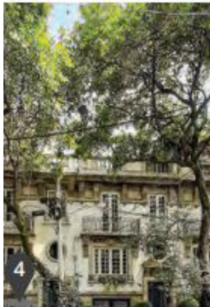
Casa-habitación Ubicación: Colima no. 232, Roma Norte, Cuauhtémoc, Ciudad de México Autor(a): No disponible Fecha de realización: Principios siglo XX Materiales: Cantera de rodapiés, pilastras con capitel y herrería. Fecha de declaratoria: 7 de febrero 2006
