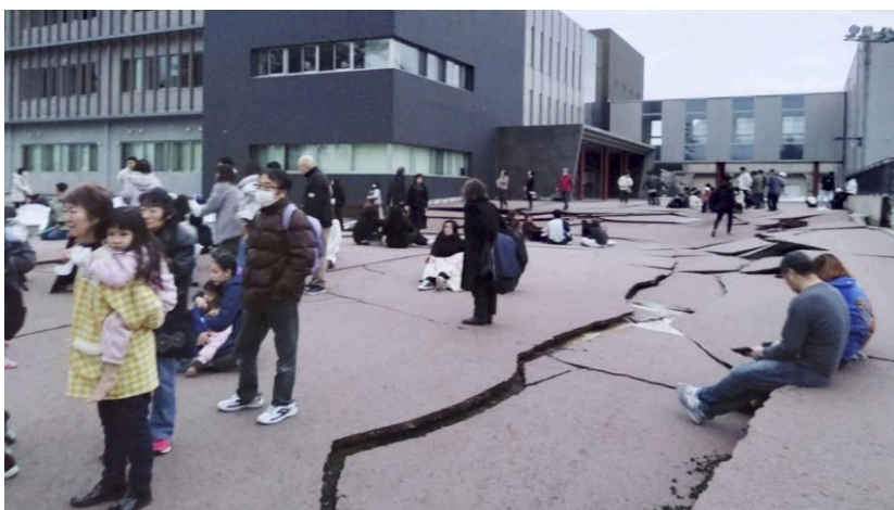
Imagen 2.1 Grietas en la localidad de Wajima, Ishikawa, Japón el 1 de enero de 2024, tomado de BBC News Mundo, el 24 de abril de 2024.
