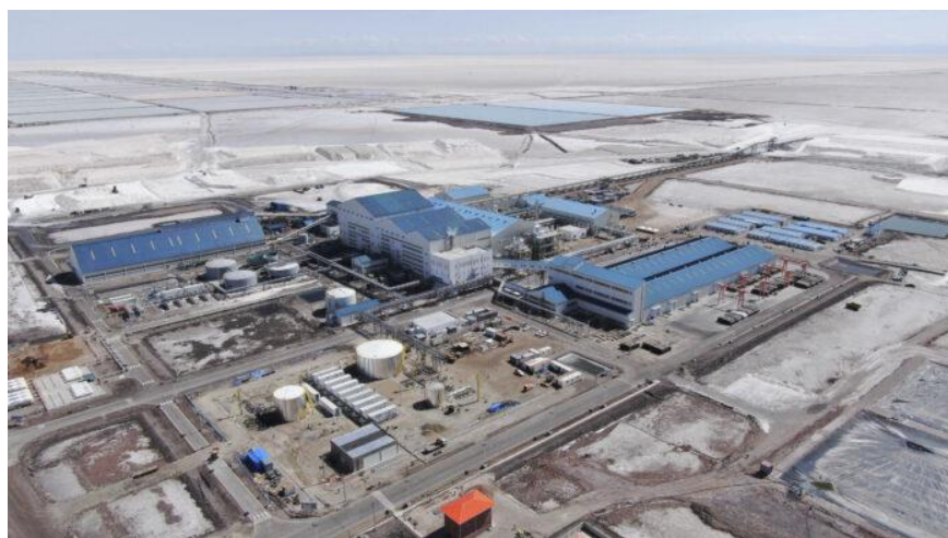
Ilustración 10 Planta de Producción de Carbonato de Litio en Llipi, Potosí. (AEP, 2023)
