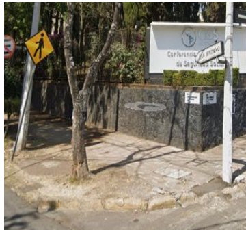
Imagen 2. Delimitación de las banquetas y en donde no se encuentran rampas.
