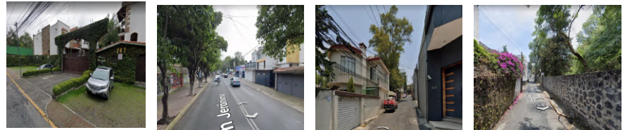
Imágenes 28, 29, 30 y 31. Condiciones en las que se encuentran las calles
