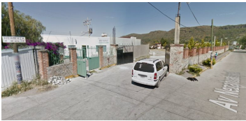
Figura 82. Predio donde se propone ubicar el centro de salud rural en San Nicolás Tlaminca. (GoogleEarth, 2023)
