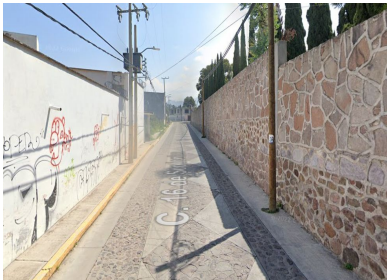
Fig. 29. Banqueta sobre calle 16 de Septiembre con dimensiones menores a las reglamentarias. Recuperado de Google Earth (2023).
