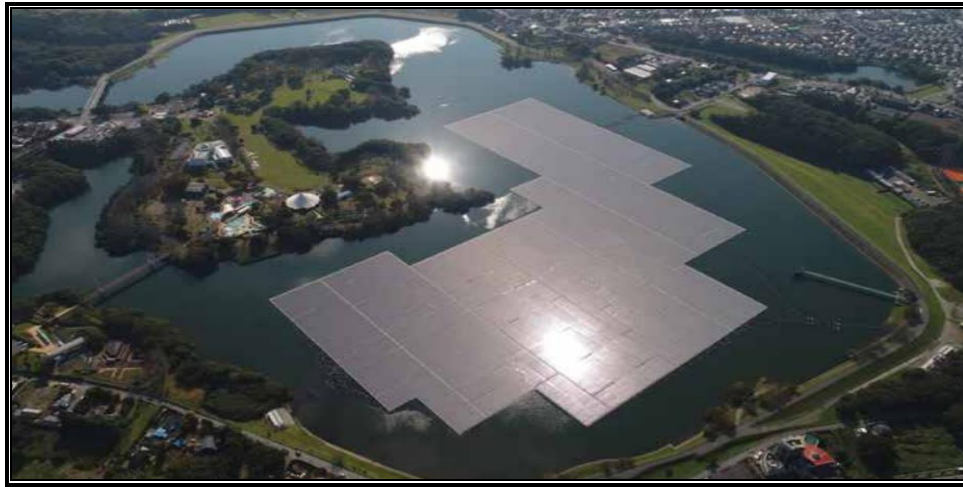
Ilustración 10 Instalación FPV (con una capacidad de 13.7 MWp) en la presa de Yamakura (Japón). Fuente: Banco Mundial (WB). Where Sun Meets Water Vol. 2.
