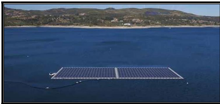
Ilustración 13 Sistema FPV (con 220 kWp de capacidad) en la desembocadura del río Rabagão, en Montalegre - Portugal. Fuente: Banco Mundial (WB). Where Sun Meets Water Vol.2.
