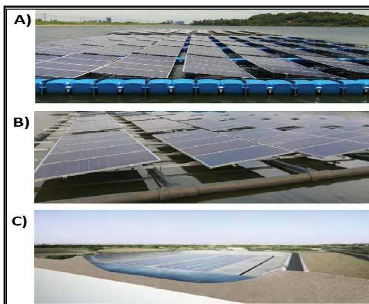
Ilustración 3 Sistemas de Flotación A) Puros; B) Metálicos; C) Membrana y esferas. Fuente: Banco Mundial (WB). Where Sun Meets Water Vol. 2.
