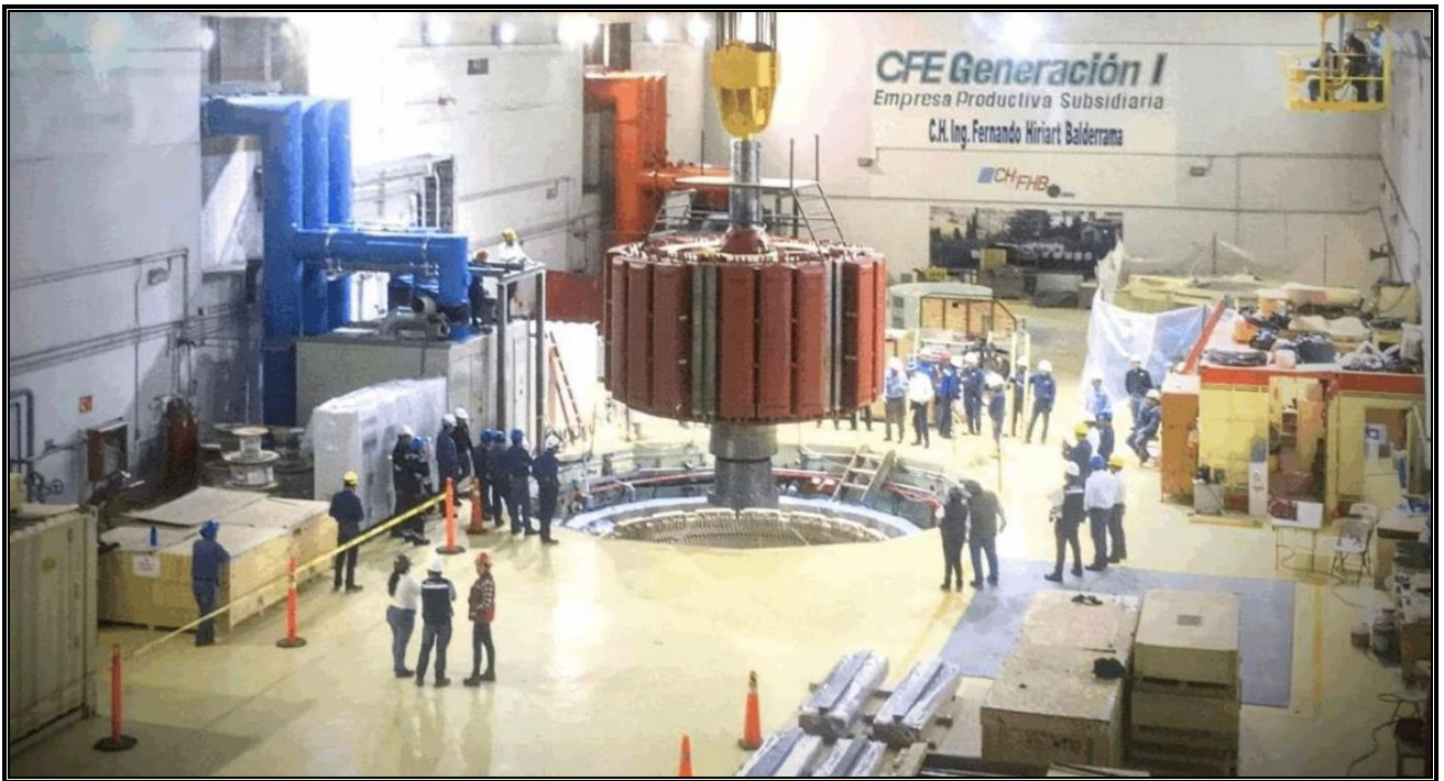
Ilustración 18 Repotenciación del rotor del equipo turbo generador de una de las dos unidades de la Central Hidroeléctrica Ing. Fernando Hiriart Balderrama (Zimapán). Fuente: CFE Generación I.
