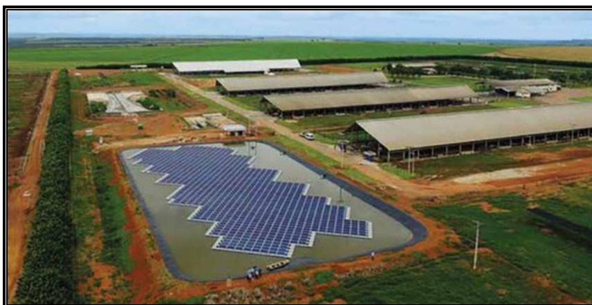
Ilustración 9 Sistema FPV (de 305 kWp de capacidad) en Goias - Brasil. Fuente: Banco Mundial (WB). Where Sun Meets Water Vol. 2.
