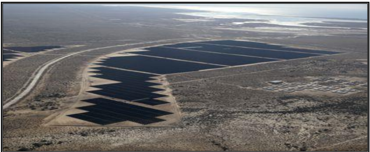
Ilustración 23 Central Fotovoltaica Puerto Peñasco. Fuente: El País. López Obrador inaugura la central fotovoltaica de Puerto Peñasco, el proyecto verde más ambicioso de su Administración.
