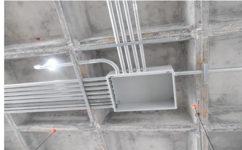
*Ilustración 197-Registro himel ramificación a equipos hidráulicos.*
