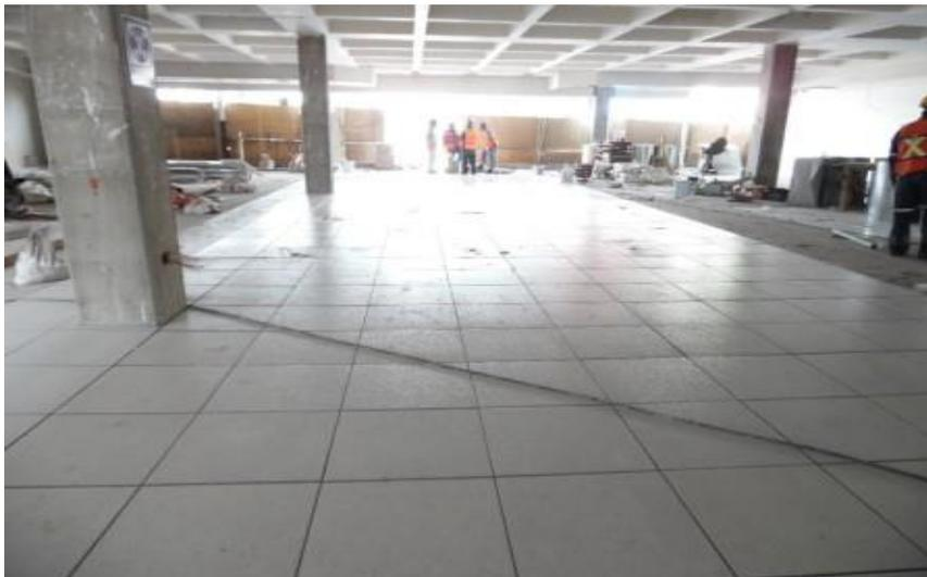
*Ilustración 251-Colocación de piso Cerámico Traffic marca Lamosa.*
