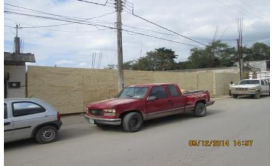
*Ilustración 95.-Colocación de tapial de madera para protección de la obra y transeúntes.*
