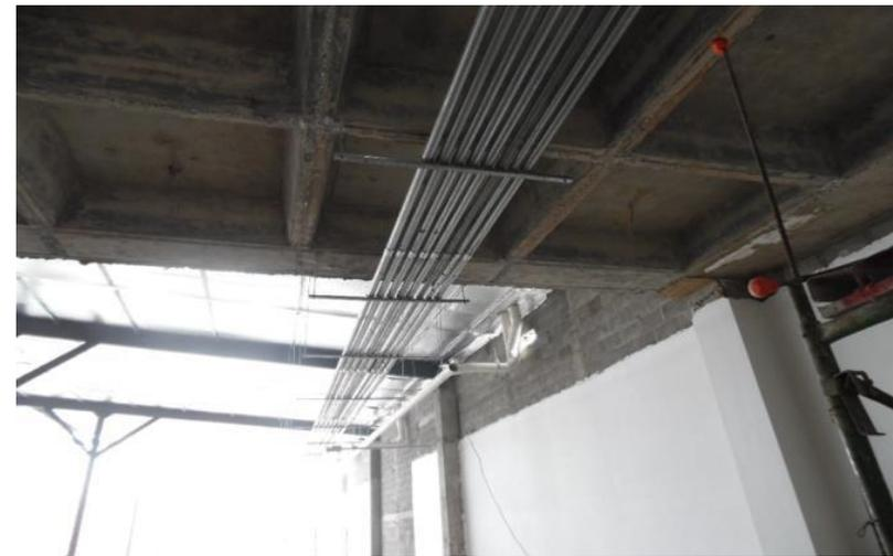
*Ilustración 198-Circuitos de alimentación hacia áreas de cjas de abono.*
