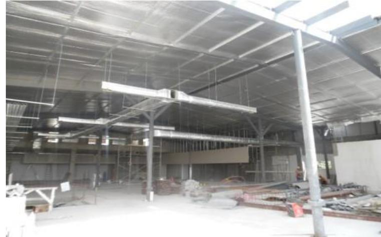
*Ilustración 220-Ramificación de ductos en primer nivel*
