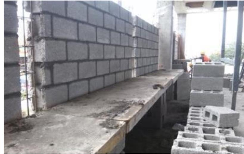
*Ilustración 180.-Tapancos para construcción de muros de block.*
