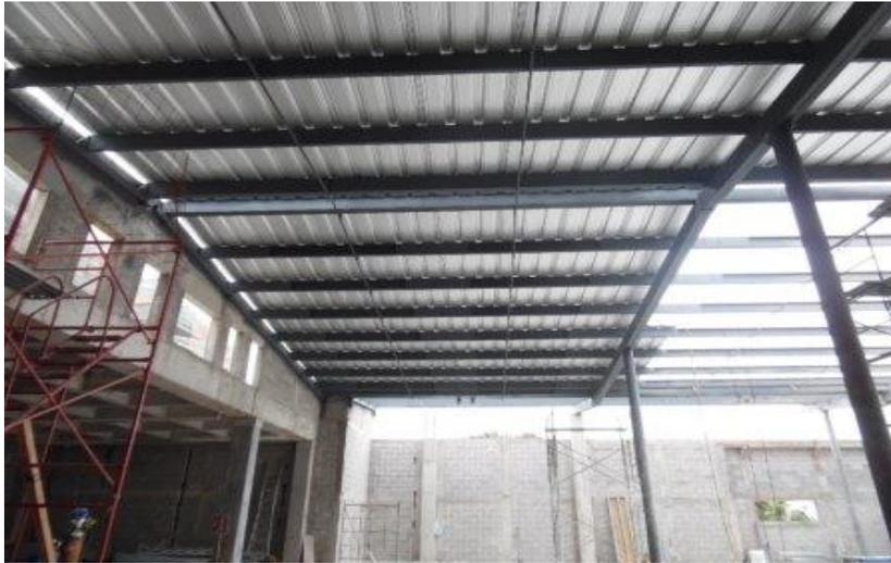
*Ilustración 174.-Colocación de lámina galvanizada.*
