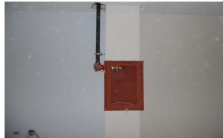
*Ilustración 229-Colocación de gabinetes de hidrantes contra incendio según proyecto.*
