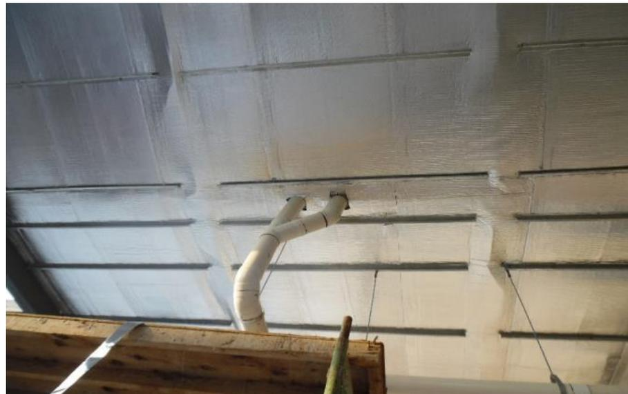
Ilustración 236-sellado de pasos para instalación pluvial de reflectix y lamina.
