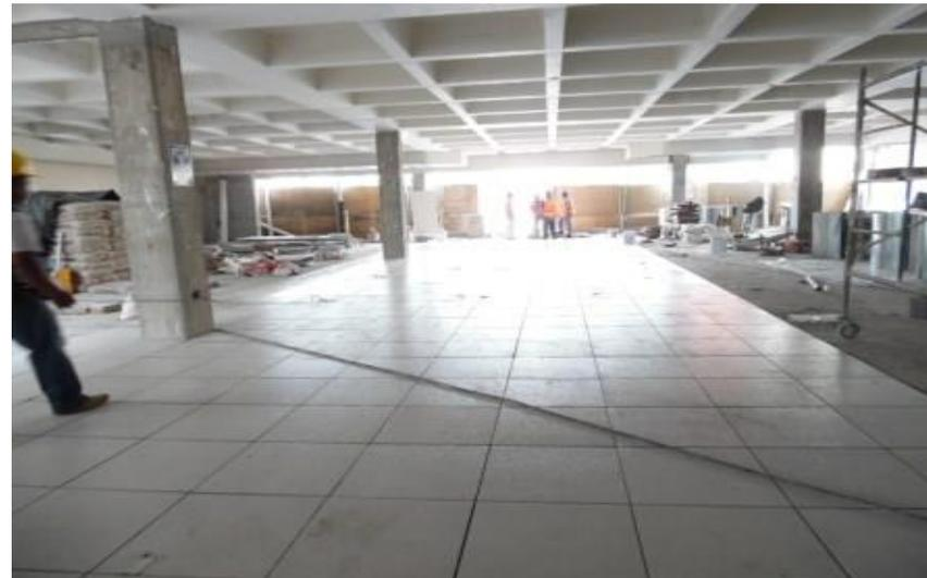
*Ilustración 252-Colocación de piso Cerámico Traffic en piso de venta.*
