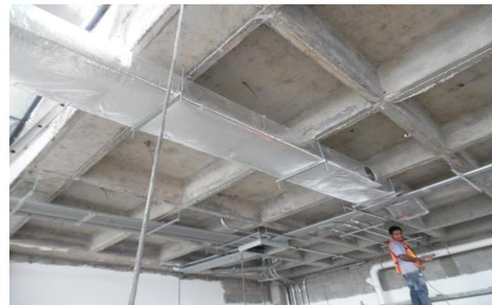
*Ilustración 217-Ductos de aire acondicionado en área de banco*
