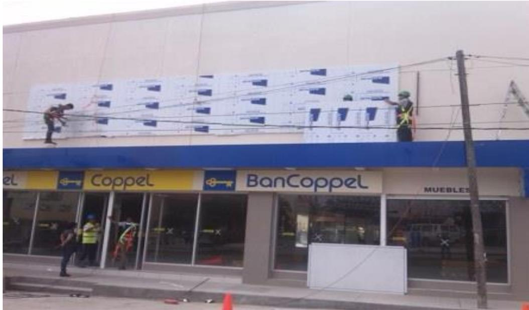
*Ilustración 285.-Colocación de paneles de aluminio en fachada.*
