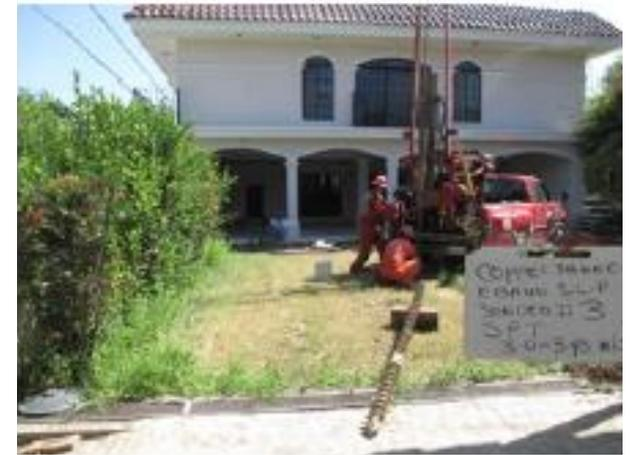
Ilustración 54.-Vista de los trabajos de perforación sondeo N°3, fotografía tomada en sitio en el año 2014.
