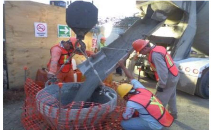
*Ilustración 122.-Monitoreo del colado de pilas.*
