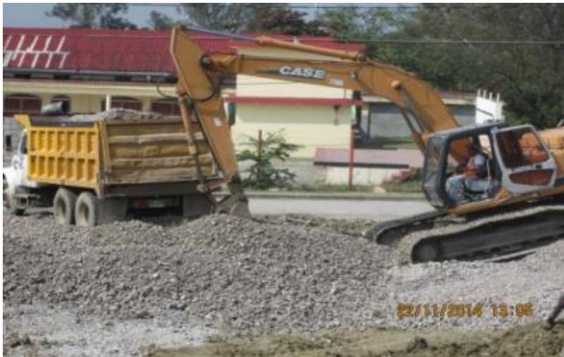
Ilustración 82.-Movimiento de material para mejoramiento de suelo.
