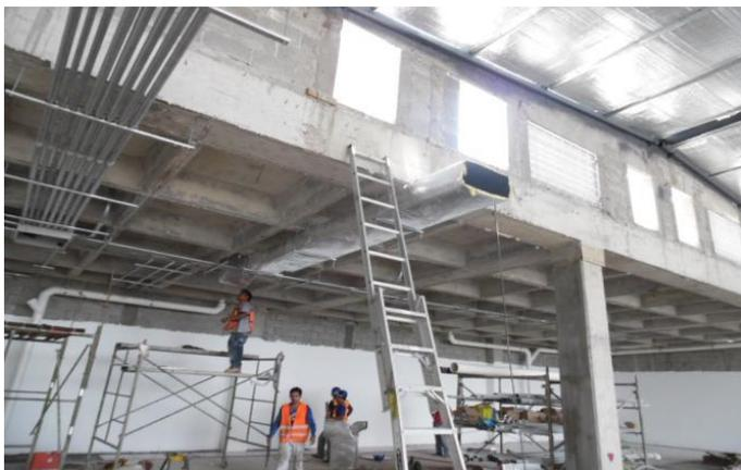
*Ilustración 218-Ductos de aire acondicionado en área de cajas de abono*
