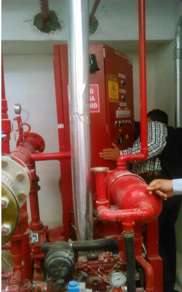
*Ilustración 306.-Revisión de tableros de arranque de equipo contra incendio.*
