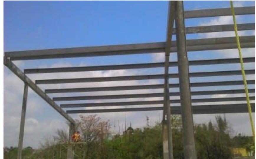
*Ilustración 168.-Colocación de vigas y columnas metálicas.*
