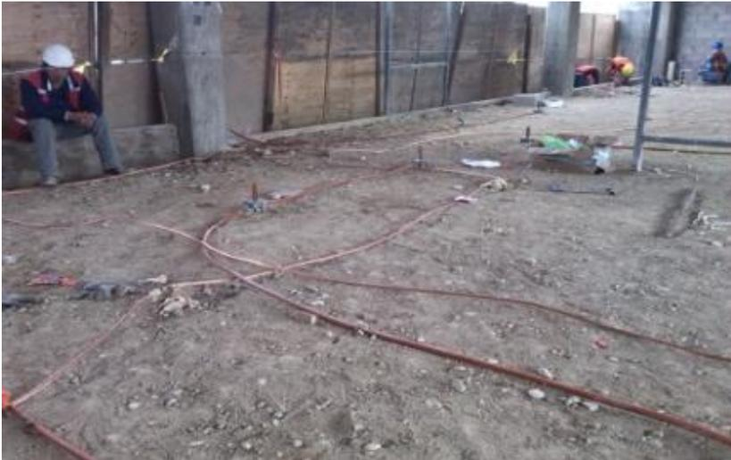
*Ilustración 194-Colocación de canalización en áreas de electrónica.*
