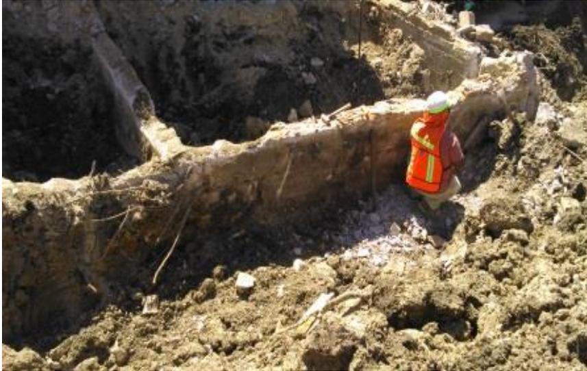
*Ilustración 72-Demolición de cimentaciones existentes de concreto.*
