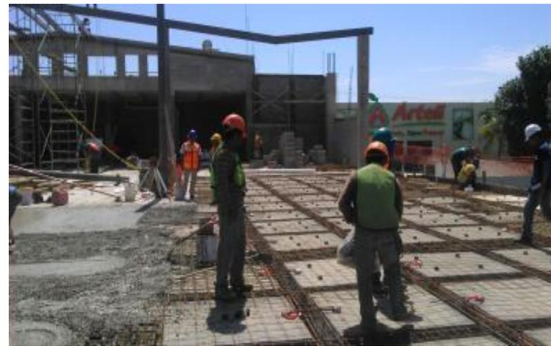
*Ilustración 165.-Colocación de silletas para malla electro soldada.*
