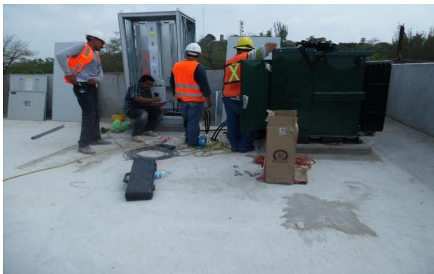
*Ilustración 208-Cableado y habilitado de l line y transformador.*
