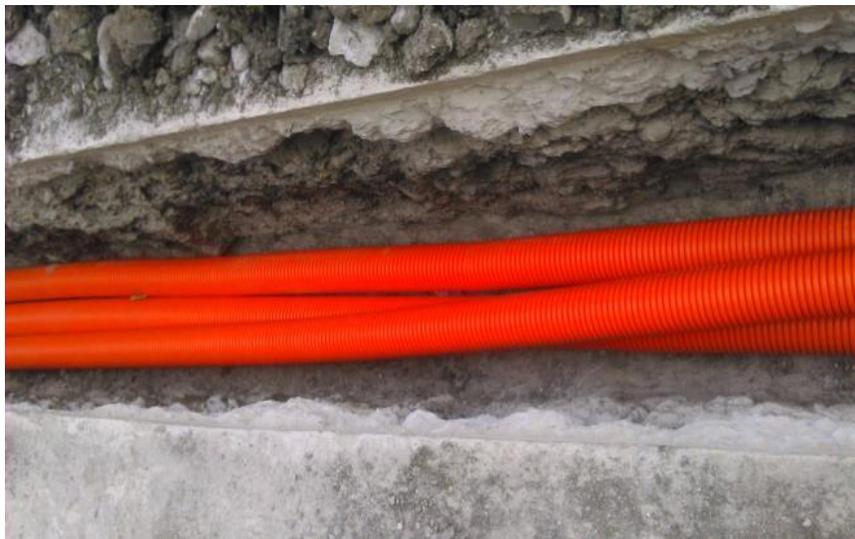
*Ilustración 207-Poliducto enterrado bajo paso vehicular.*
