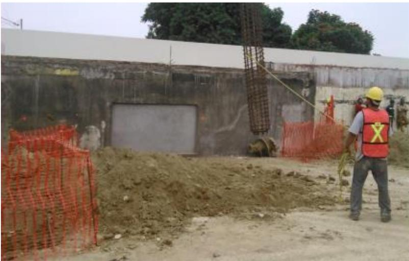
*Ilustración 116.-Colocación de armado para pila en perforación*
