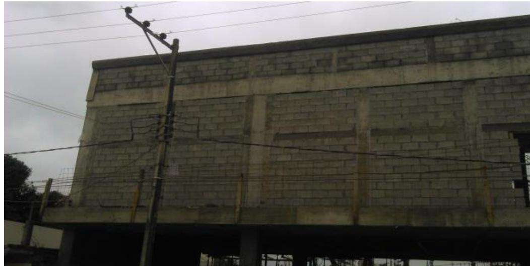
*Ilustración 185.-Vista de fachada principal con muros de block terminados y confinados.*
