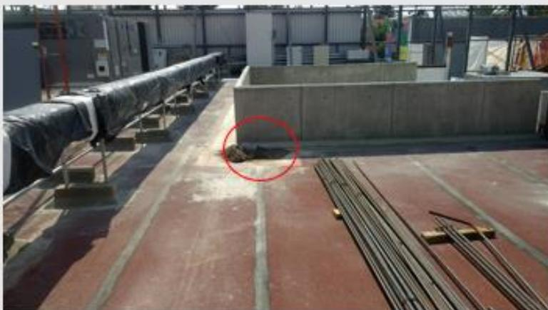
**Bajada pluvial se taponeó con arena debido a fuga en la tubería de descarga.**
