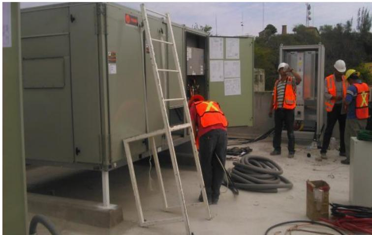
*Ilustración 222-Equipos de aire marca Trane de 15 toneladas de capacidad.*
