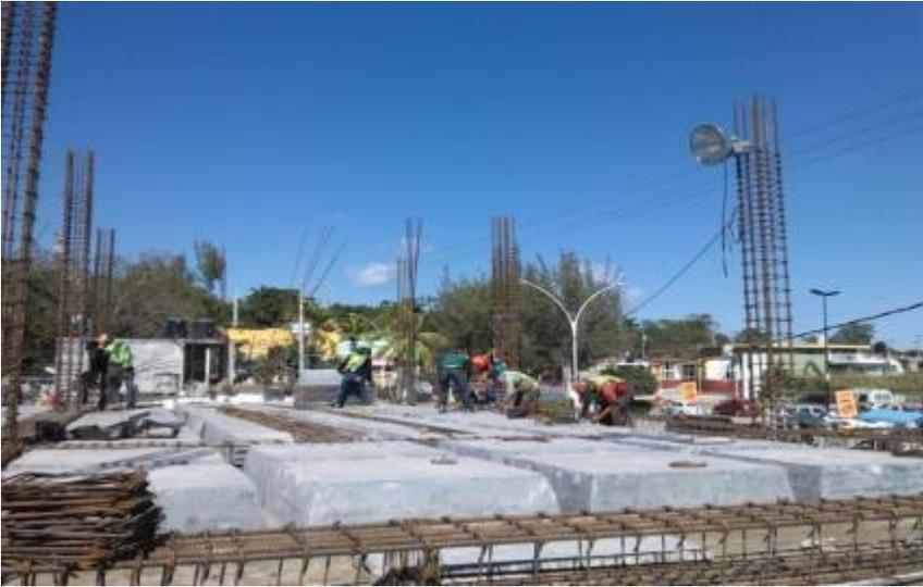
*Ilustración 155.-Habilitado de armado de acero en losa (trabes principales).*
