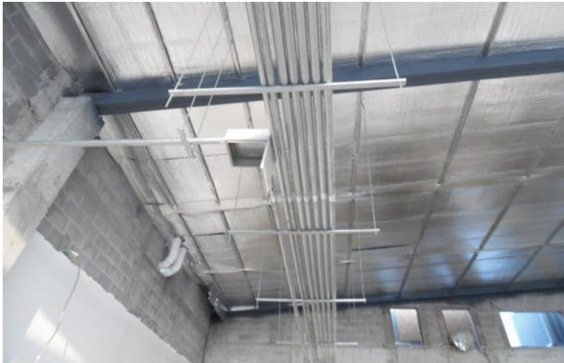
*Ilustración 199-Circuitos de alimentación hacia áreas de banco.*
