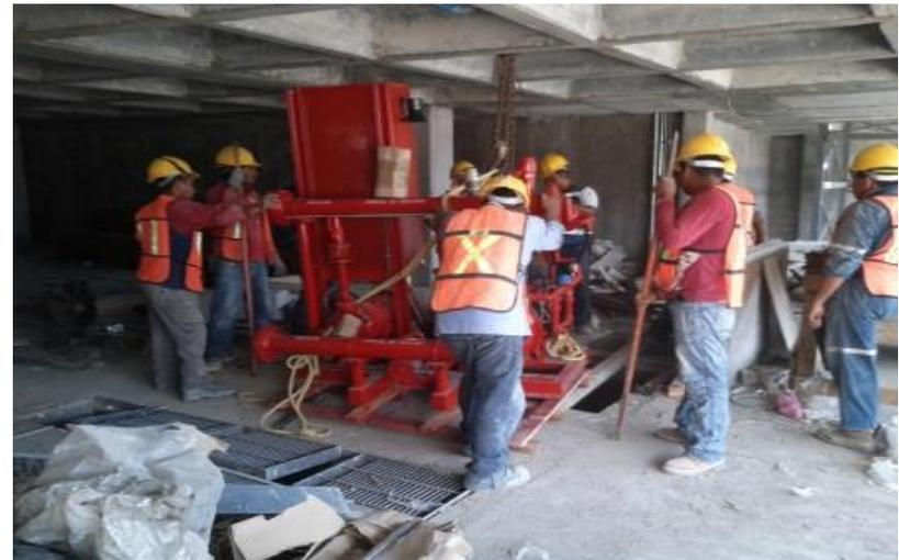
*Ilustración 224-Maniobra para colocación de equipo contra incendio.*
