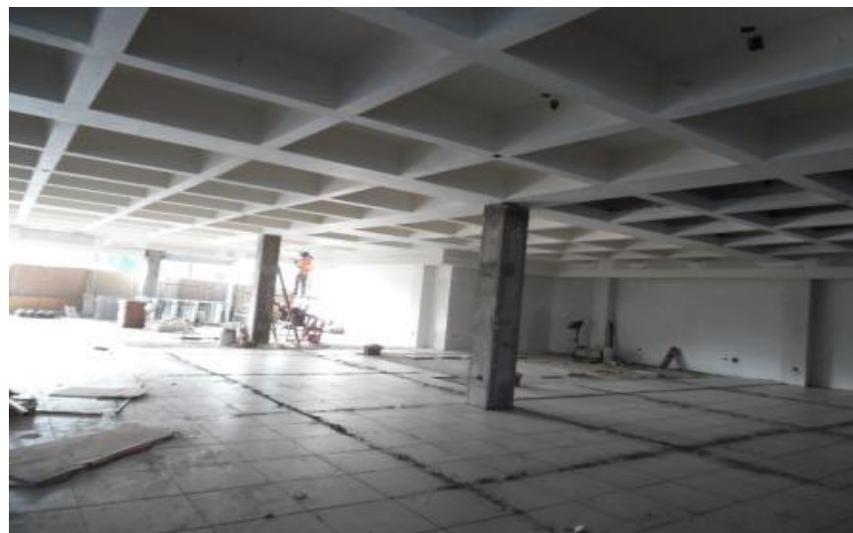
*Ilustración 254-Seccionamiento de piso para colocación de junta de control.*
