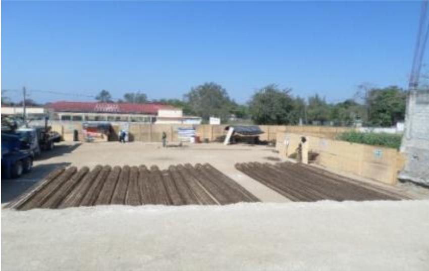
*Ilustración 100.-Habilitado de acero para armado de pilotes.*
