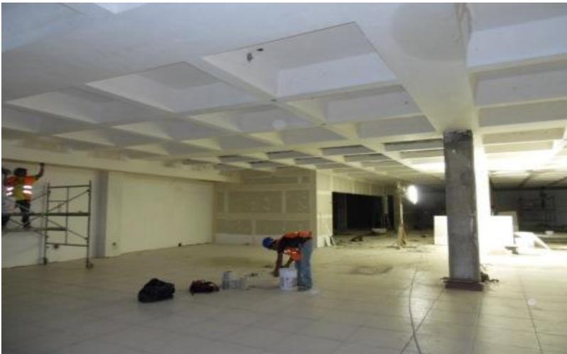
*Ilustración 242-Aplicación de yeso y Ready Mix al interior de casetones*
