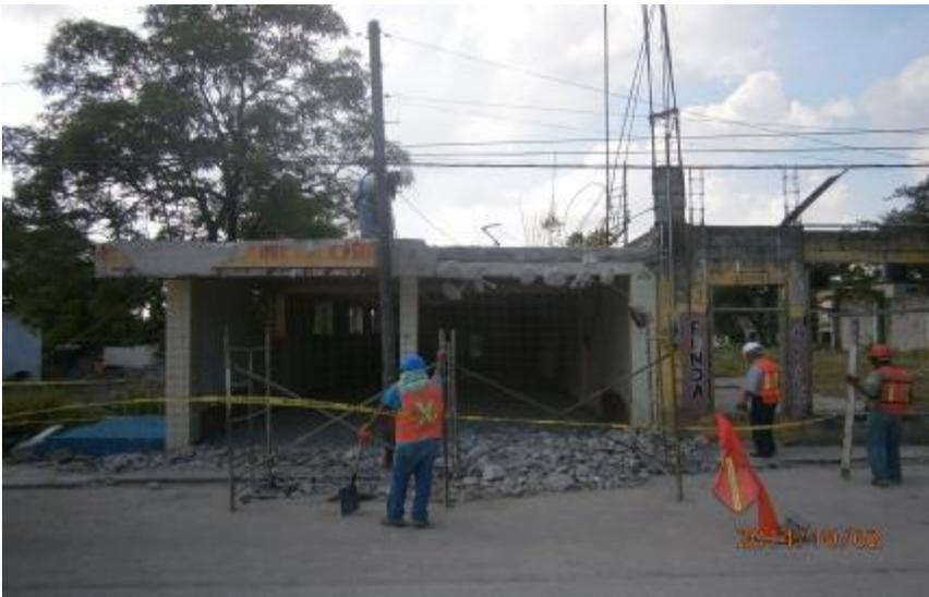
*Ilustración 65.-Demolición de losas de entrepiso.*
