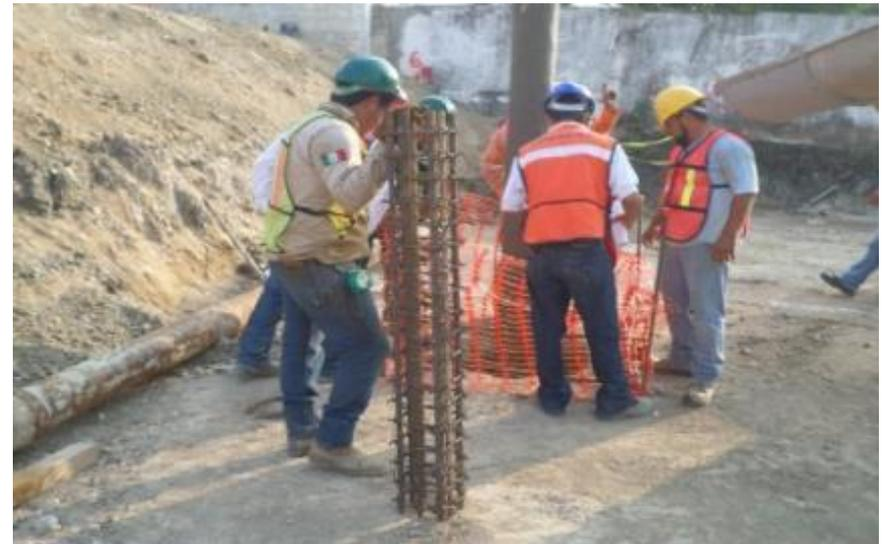
*Ilustración 125.-Colocación de acero para conexión de pilas a contratraves.*
