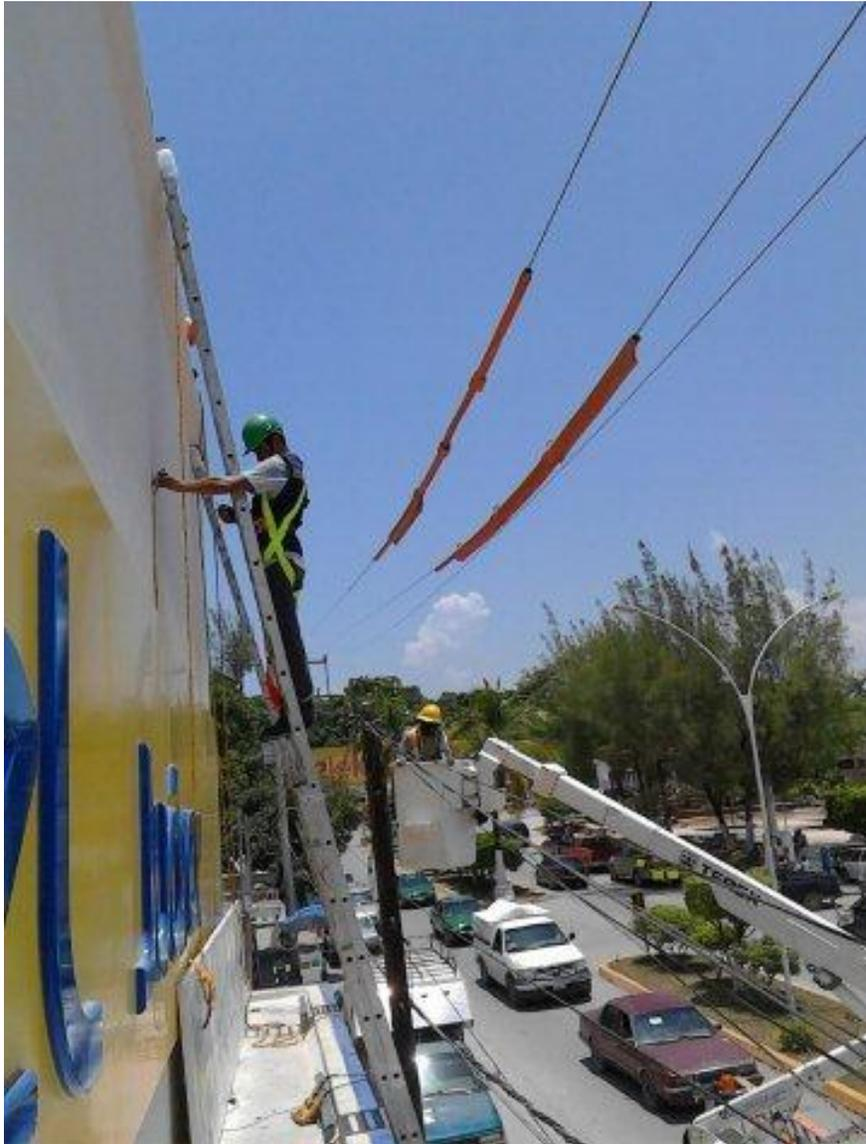
*Ilustración 287.-Colocación de letras sobre paneles de aluminio*
