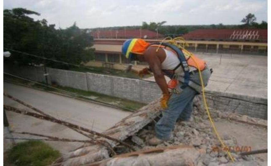
*Ilustración 63.-Demolición de losa maciza de entrepiso.*
