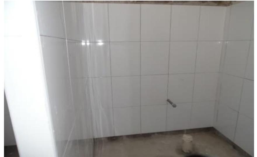
*Ilustración 257-Detales de saques para instalaciones en losetas de muro.*
