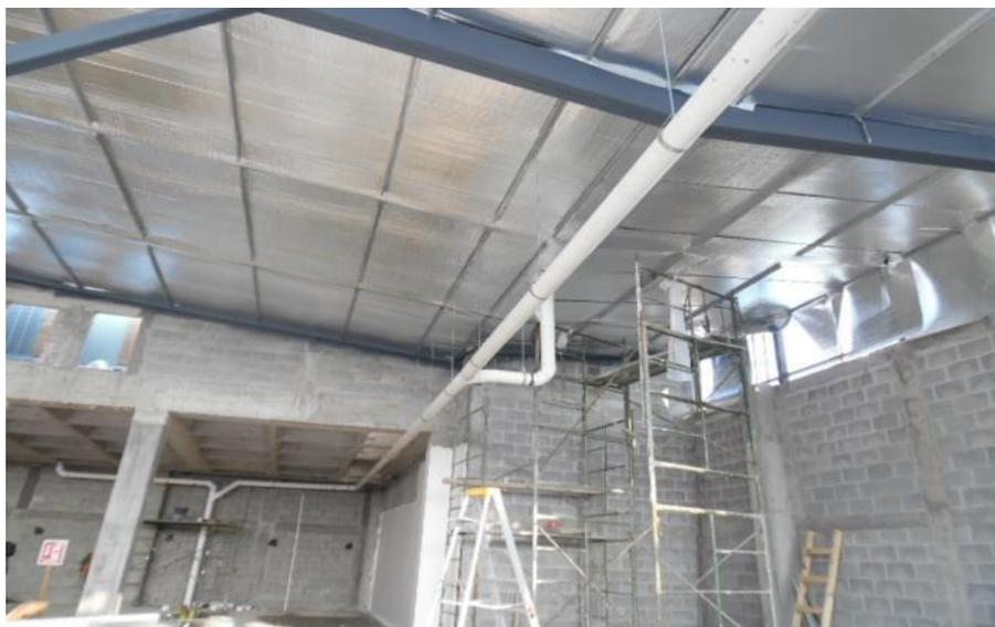
Ilustración 237-La soportería se sostiene de los montenes de la techumbre.
