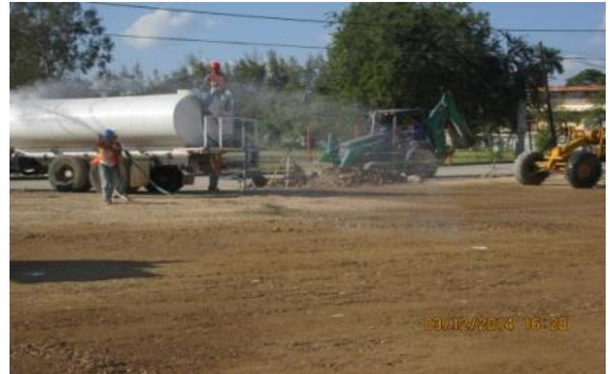
*Ilustración 94.-Se aplicó agua al terreno para mejorar el grado de compactación.*
