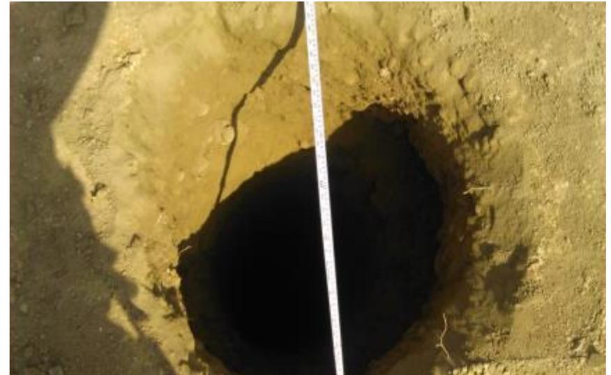
*Ilustración 110.-Diámetro de perforación para fincar pila.*
