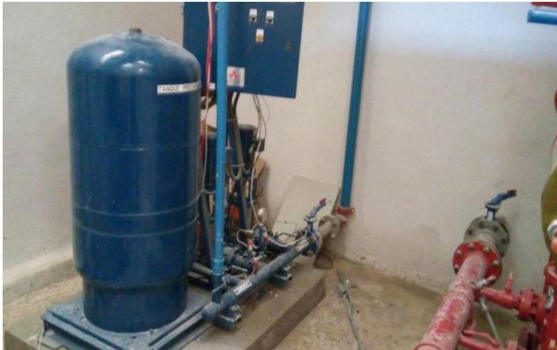
*Ilustración 225-Equipos hidroneumáticos para abastecimiento de agua potable al edificio.*
