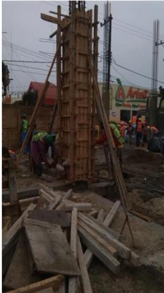
*Ilustración 143-Cimbra de columnas, revisión de plomo y troqueles.*
