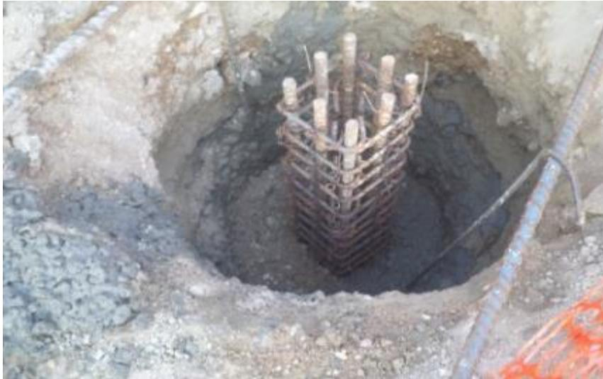
Ilustración 127.-Columna armada conexión de columna a pila de cimentación.
