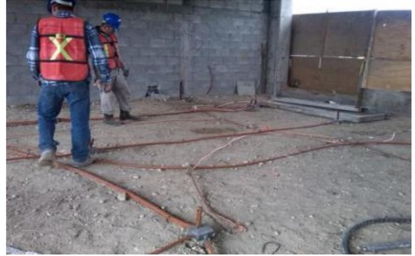
*Ilustración 192-Colocación de cajas para registros y terminales.*
