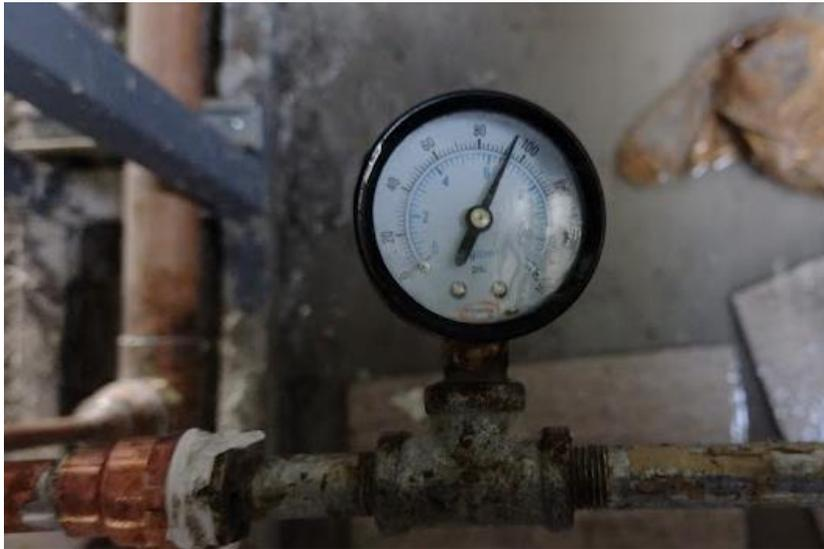
*Ilustración 231-Tubería de cobre recién cargada a  $6.5 \text{ kg/cm}^2$  el día 15 de marzo del 2015*
