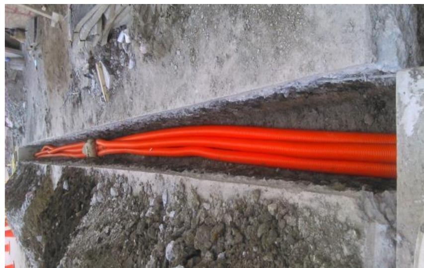
*Ilustración 210-Colocación de poliducto bajo firme por arroyo vehicular.*
