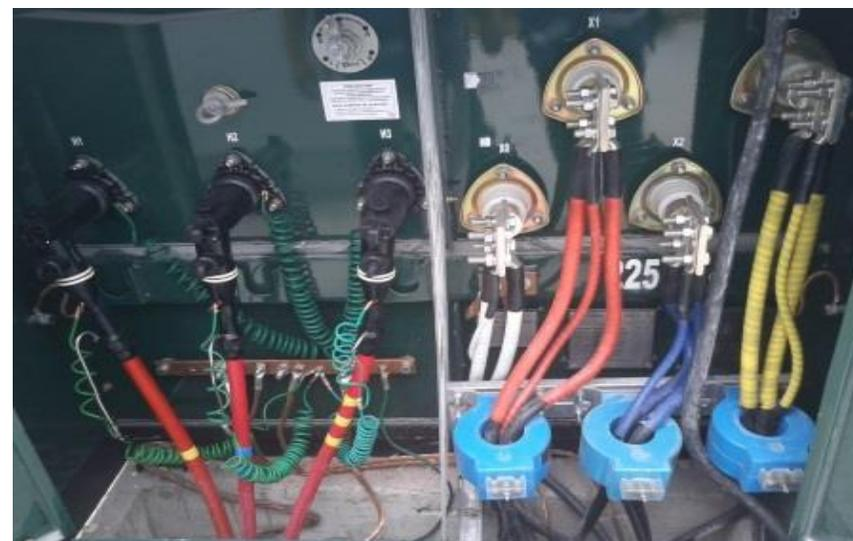
*Ilustración 209-Conexión a transformador.*
