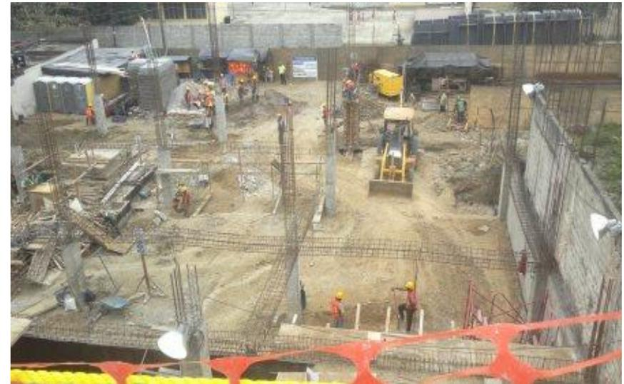
*Ilustración 141-Proceso constructivo armado, cimbrado y colado de columnas en planta sótano.*
