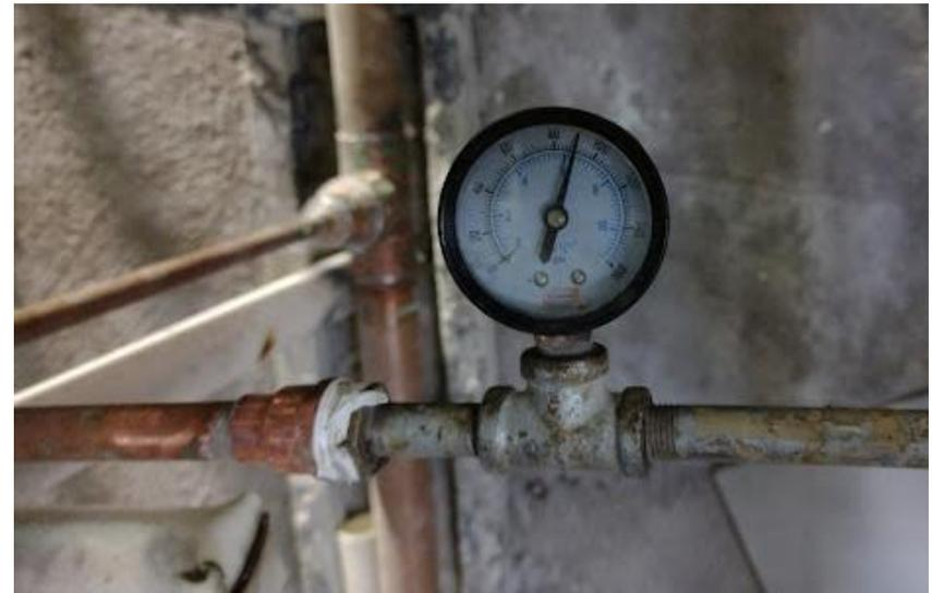
*Ilustración 232-Manómetro revisado después de más de 24 horas, lectura de casi  $6 \text{ kg/cm}^2$  el día 17 de marzo del 2015, la variación fue muy poca, por lo tanto, se entiende que hubo fuga, por lo que se liberó el tramo.*
