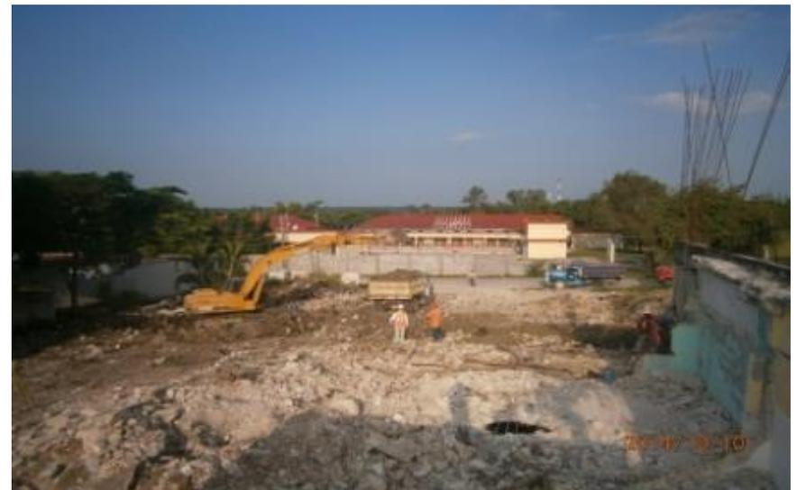
*Ilustración 69.-Retiro de excedente de material para nivelar terreno.*
