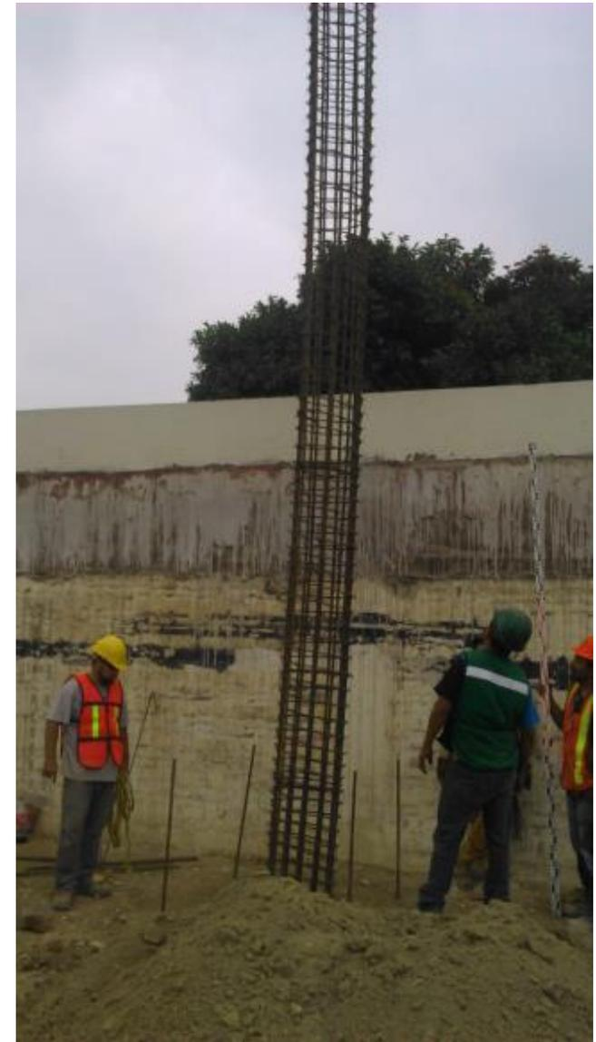
*Ilustración 117.- Apoyo a personal de grúa para ubicar armado de pila en su sitio.*
