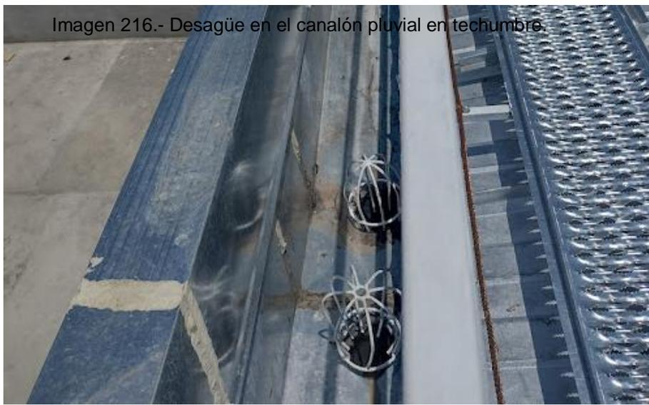
Imagen 216.- Desagüe en el canalón pluvial en techumbre.
