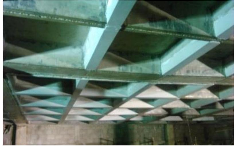
*Ilustración 239-Detallado de yeso definiendo traveses y nervaduras como lo indica el proyecto.*
