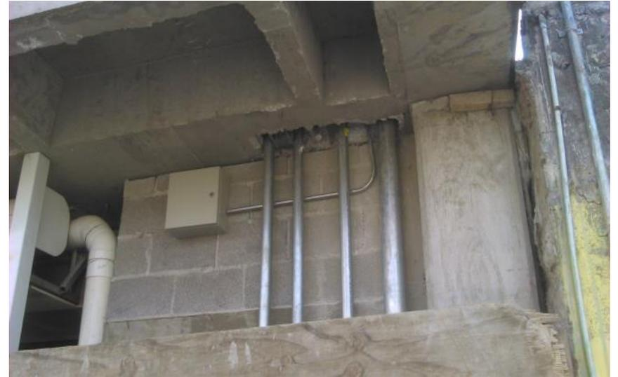
*Ilustración 203-Acometida de alimentación eléctrica a edificio.*
