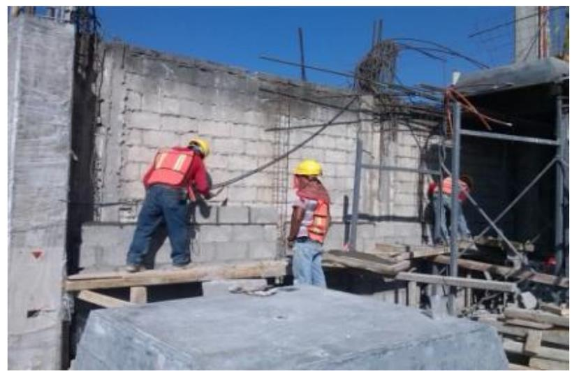
*Ilustración 182.-Remate de muros de block perimetrales.*
