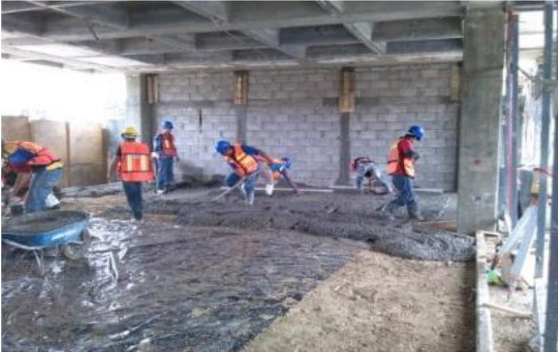
*Ilustración 188- Colado de losa en planta baja.*
