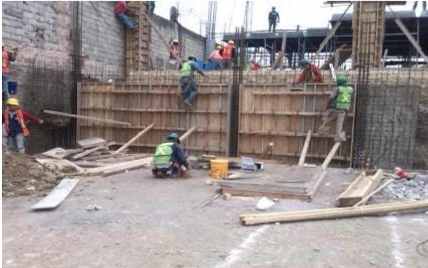
*Ilustración 131.-Trabajos de acero y cimbra en muros de contención.*
