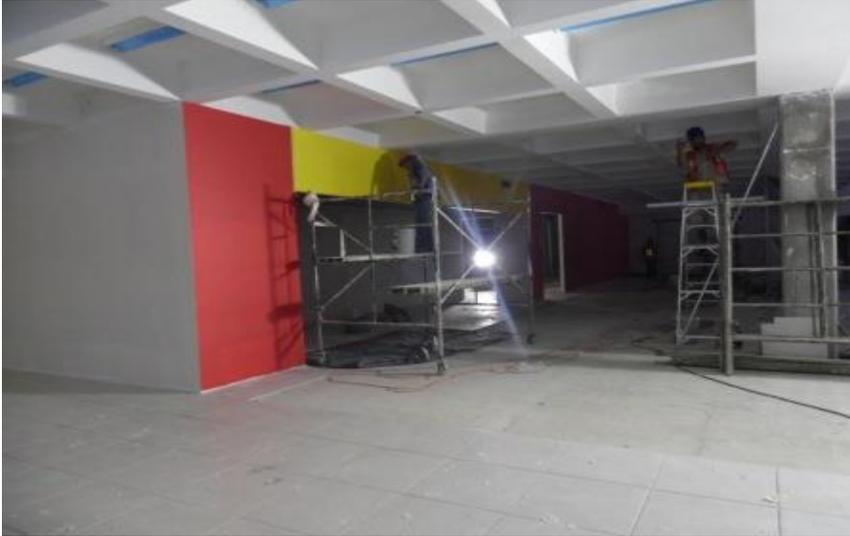
*Ilustración 263-Plafon liso empastado previo a la aplicación de pintura.*
