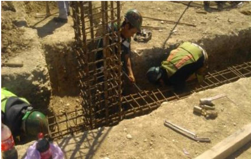
Ilustración 128.-Armado de varilla de contratrabes y columnas
