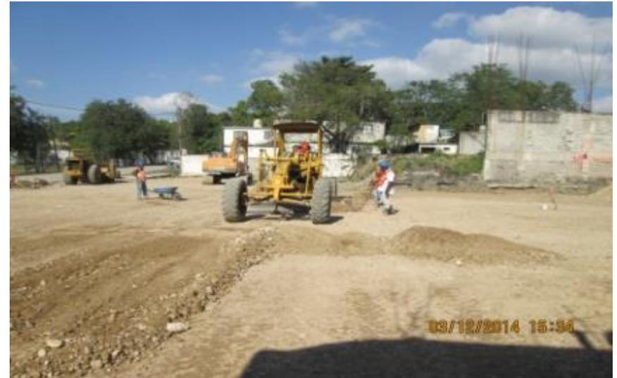
*Ilustración 92.-Extendido de material con moto escoba.*
