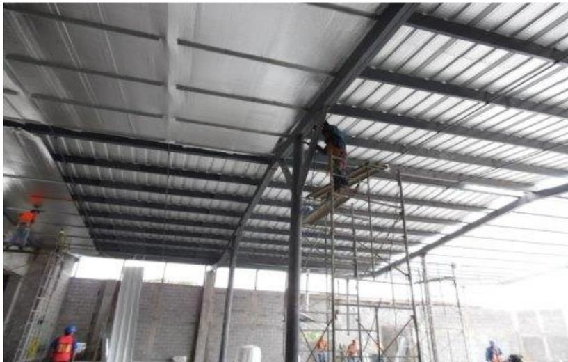
*Ilustración 176.-Colocación de Reflectix bajo la lámina galvanizada*
