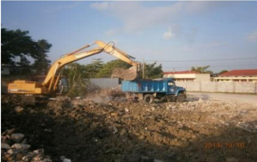
*Ilustración 67.-Retiro de escombros en camión de volteo de 14 m3.*
