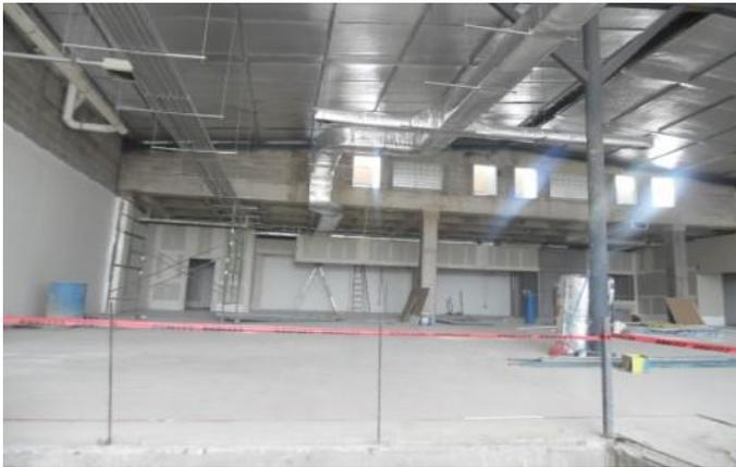
*Ilustración 215-Instalación de ductos de aire acondicionado.*
