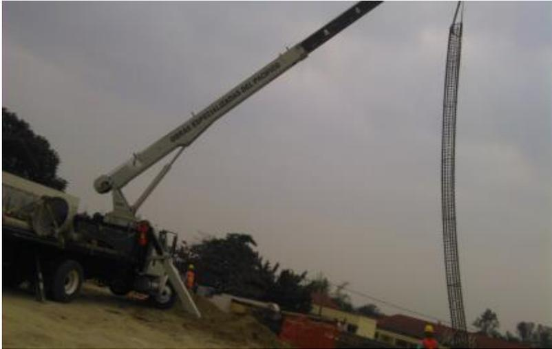
*Ilustración 115.-Colocación de armado para pila en la perforación del suelo.*
