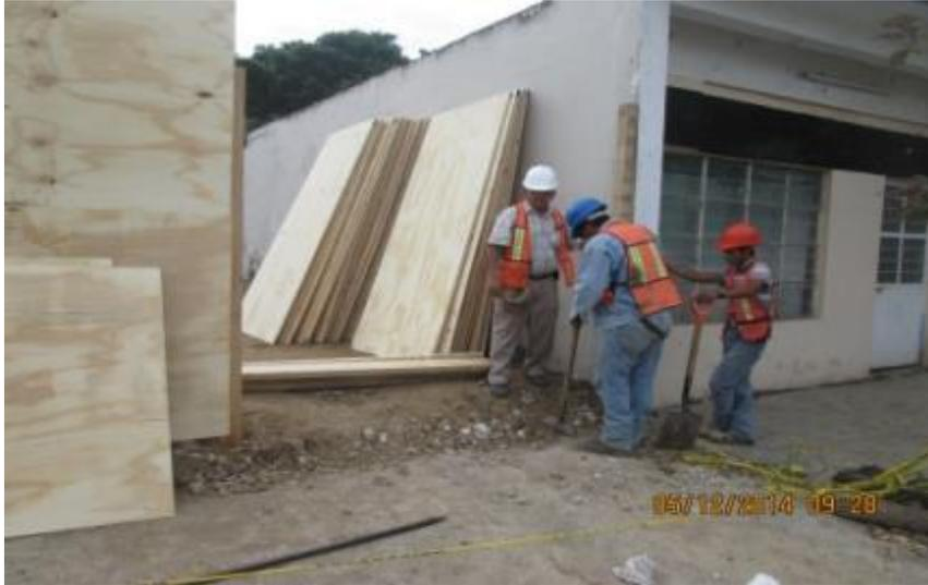
*Ilustración 96.-Excavación para postes con polines para habilitar tapial.*
