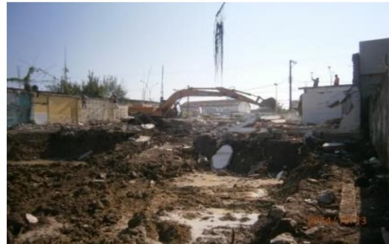
*Ilustración 78-Demolicion de firmes y cimentaciones existentes.*
