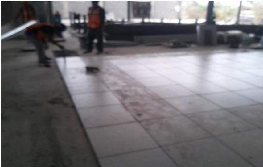
*Ilustración 256-Cuidando la calidad, alineación y niveles en la colocación de loseta.*
