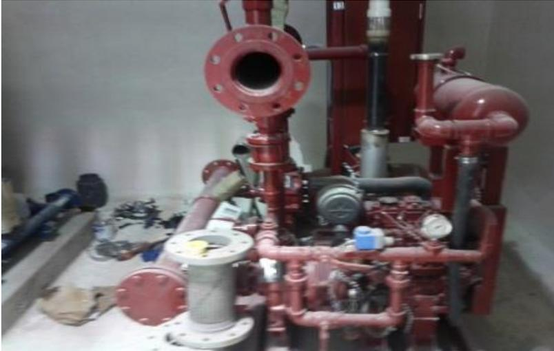
*Ilustración 223-Equipo de bombas para sistema contra incendio.*
