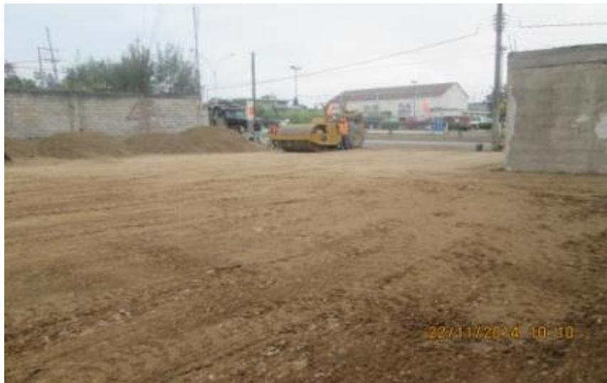
*Ilustración 90.-Se aplicó material de mejoramiento.*
