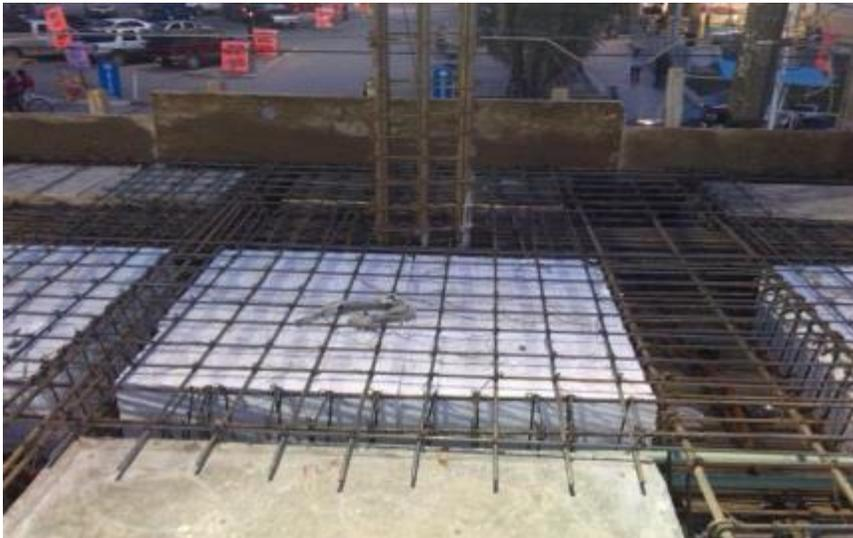
*Ilustración 157.-Colocación de casetones de poliestireno en detalles perimetrales.*
