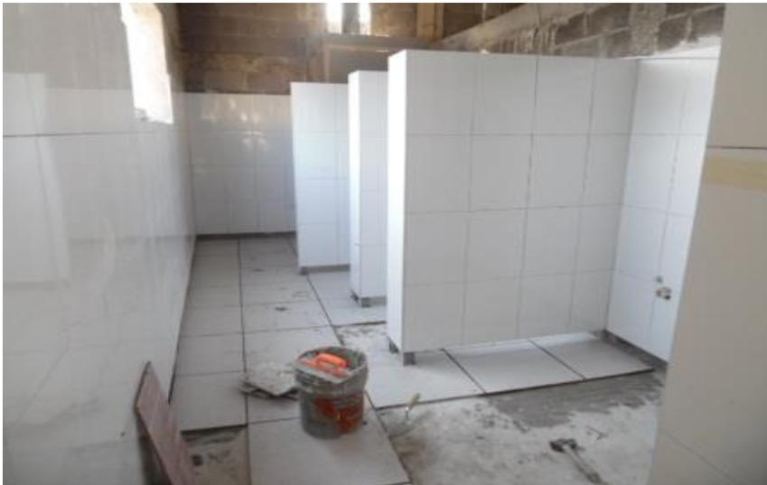
*Ilustración 260-Colocación de loseta en piso de baños.*
