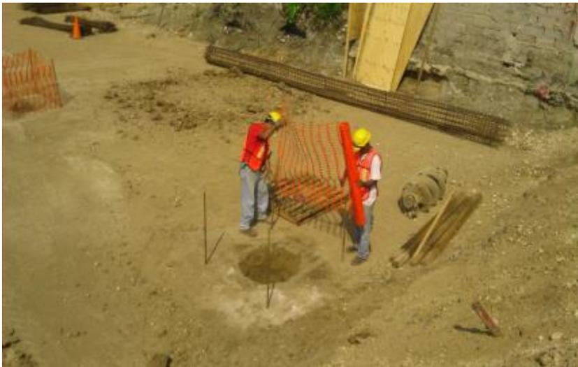
*Ilustración 112.-Colocación de malla plástica para delimitar perforación.*
