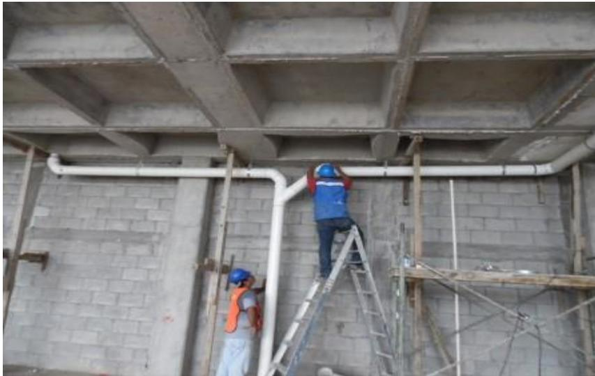
*Ilustración 233-Colocación de tubería de instalaciones pluviales*
