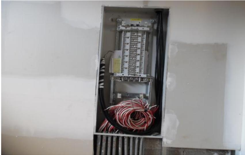
*Ilustración 200-Tablero de distribución de contactos e iluminación.*
