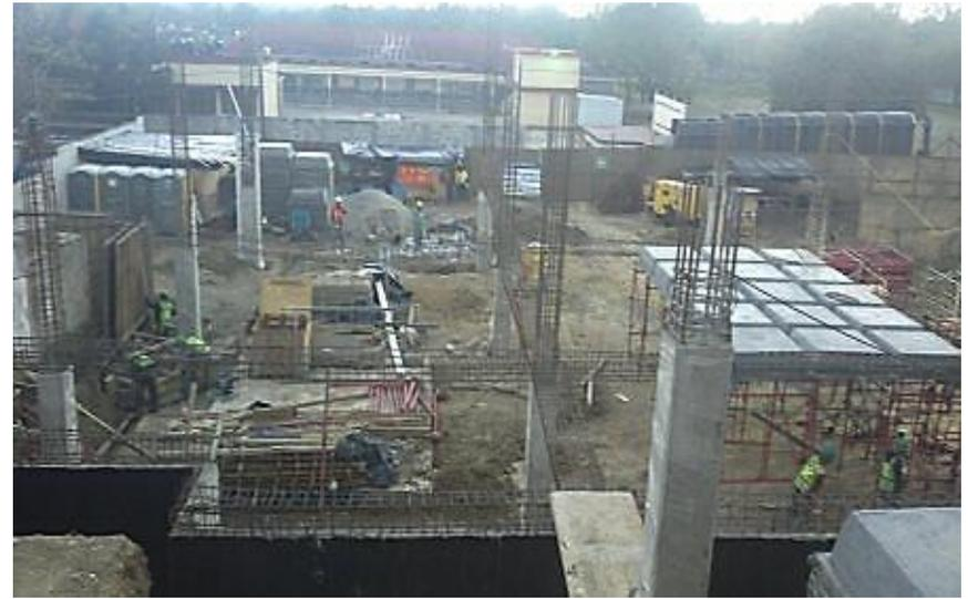
*Ilustración 140-Proceso de armado cimbrado y colado de columnas para recibir losa reticular.*
