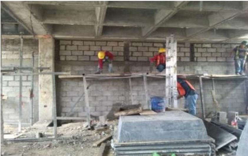
*Ilustración 183.-Remate de muros de block perimetrales.*
