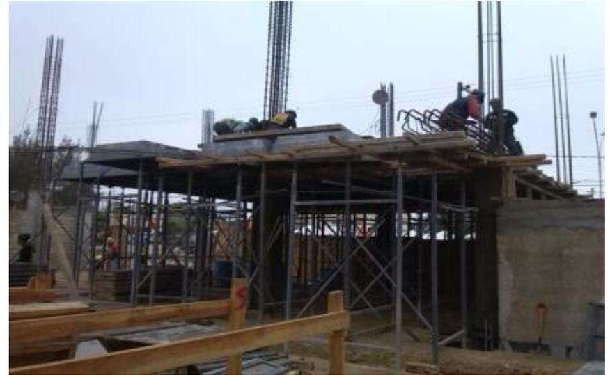
*Ilustración 154.-Habilitado de cimbra tipo Coppel las orillas de la losa como la frontera se rematan con casetón de unice y madera como se muestra.*
