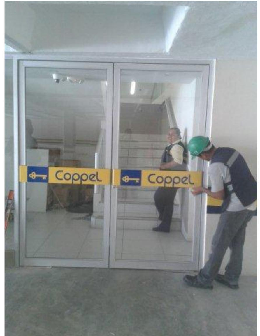
*Ilustración 288.-Colocación de barras de empuje en acceso al Lobby en planta Sótano.*
