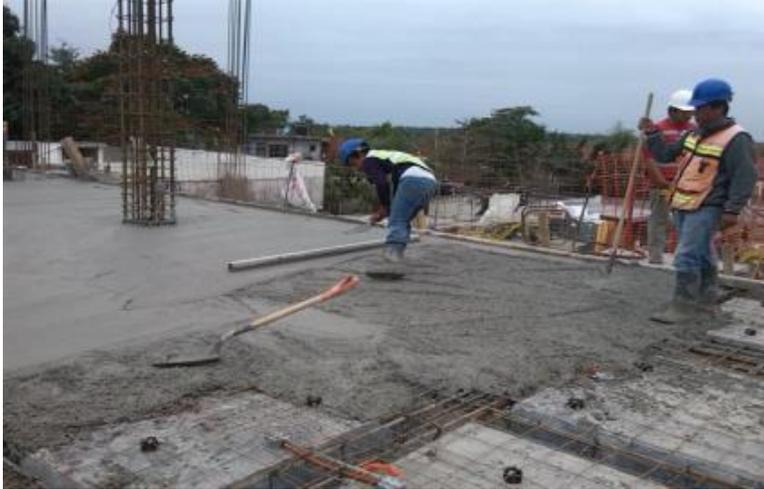
Ilustración 159.-Regleo de losa en el lecho superior.
