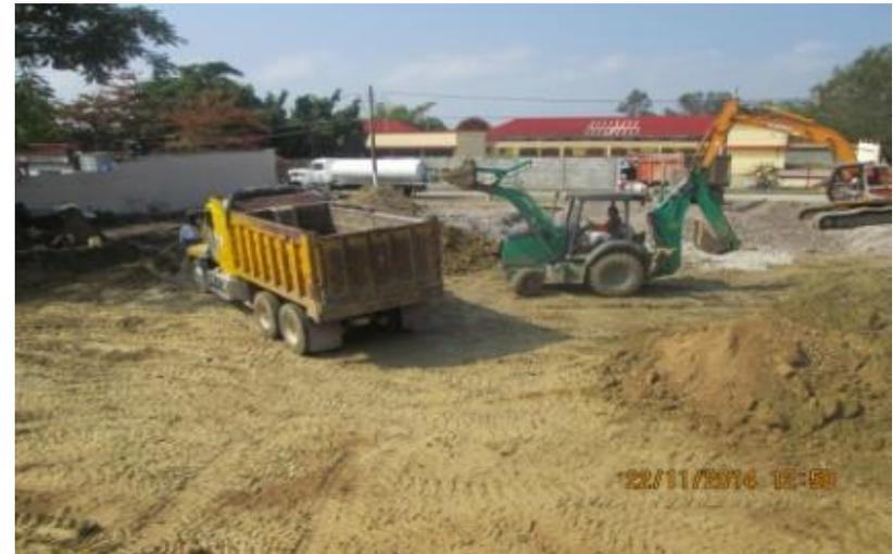
Ilustración 79.-Movimiento de tierras para nivelación.
