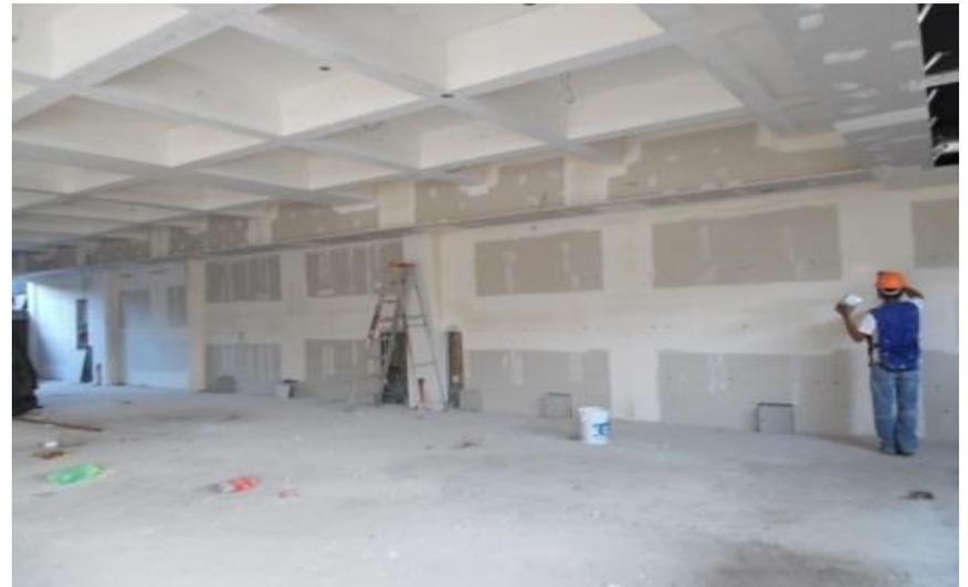
*Ilustración 250-Aplicación de pasta ReadyMix en muro Lambrin de Tabla roca en muro de Electrónica.*
