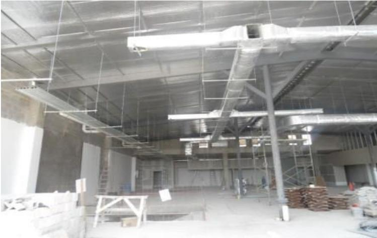
*Ilustración 219-Ramificación de ductos en primer nivel*
