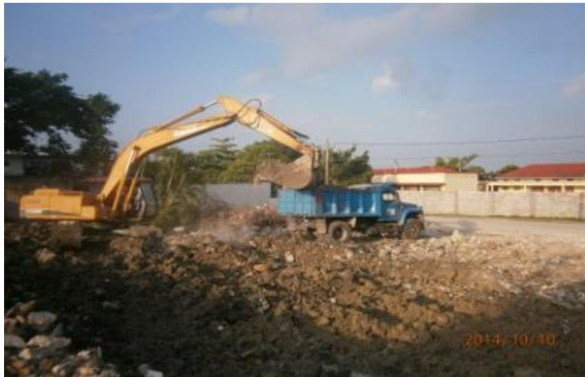
*Ilustración 70.-Retiro de escombros en camión de volteo de 14 m3.*
