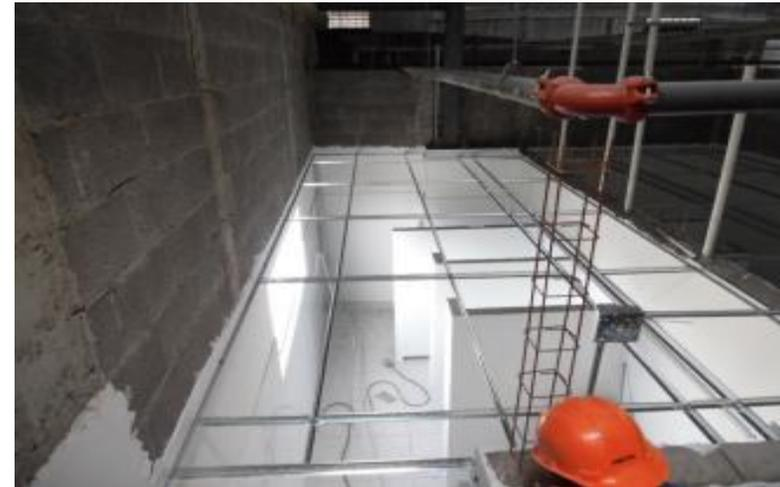
*Ilustración 228-Trayectoria de tubería de agua sobre área de baños.*
