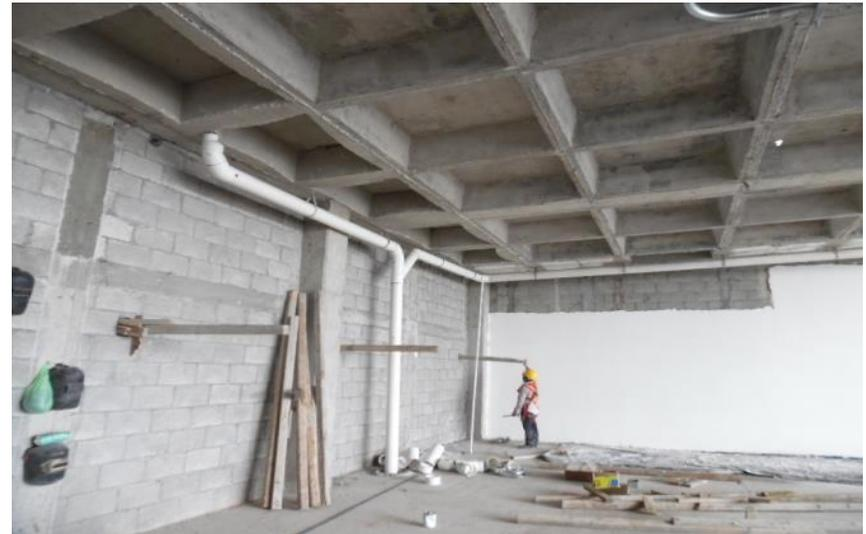
*Ilustración 234-Colocación de ramales de instalación pluvial*
