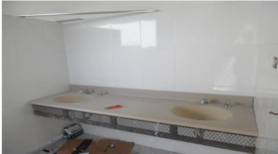
*Ilustración 261-Colocación de loseta en área de espejos y lavabos.*
