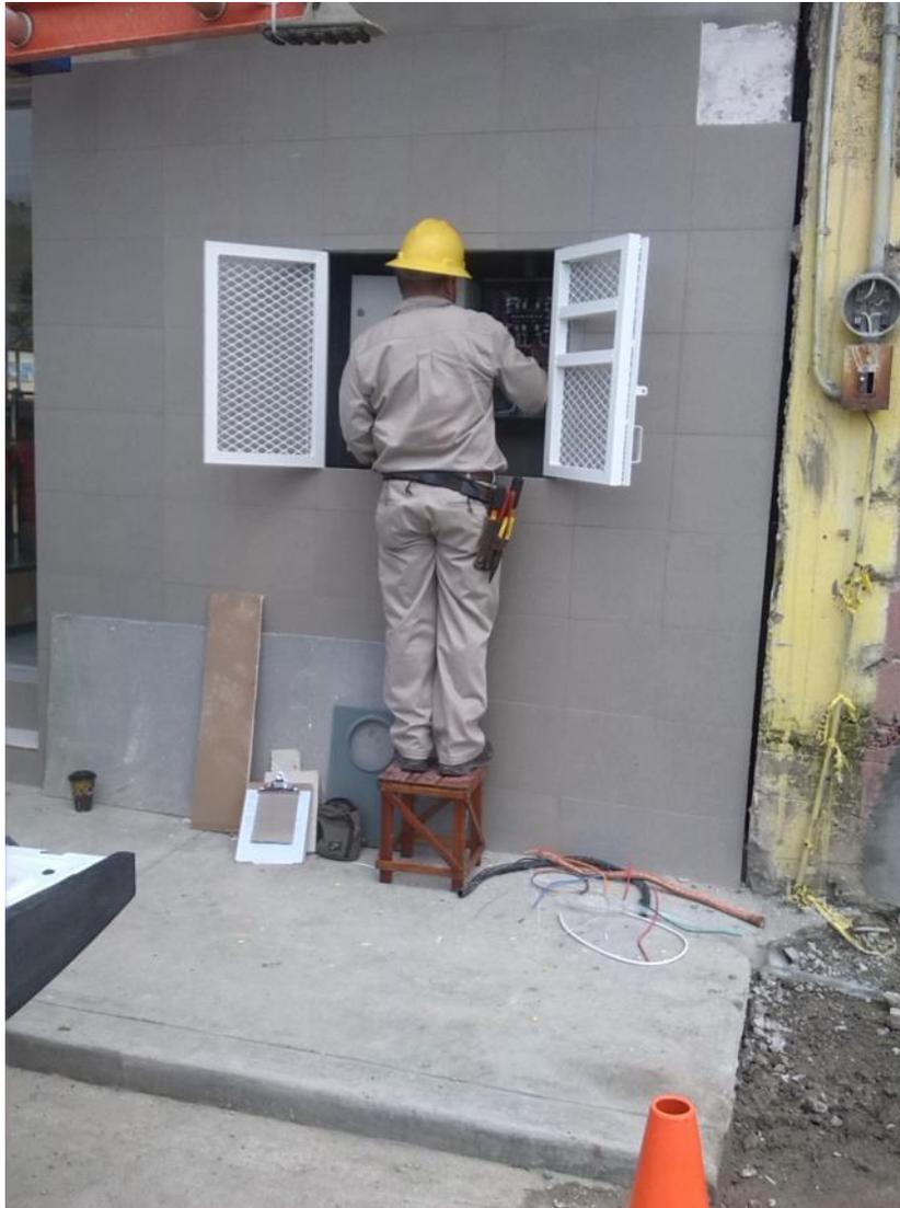
*Ilustración 212-Trabajos de conexión en acometida de CFE.*
