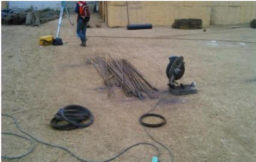
*Ilustración 102.-Habilitado de acero para armar pilotes.*
