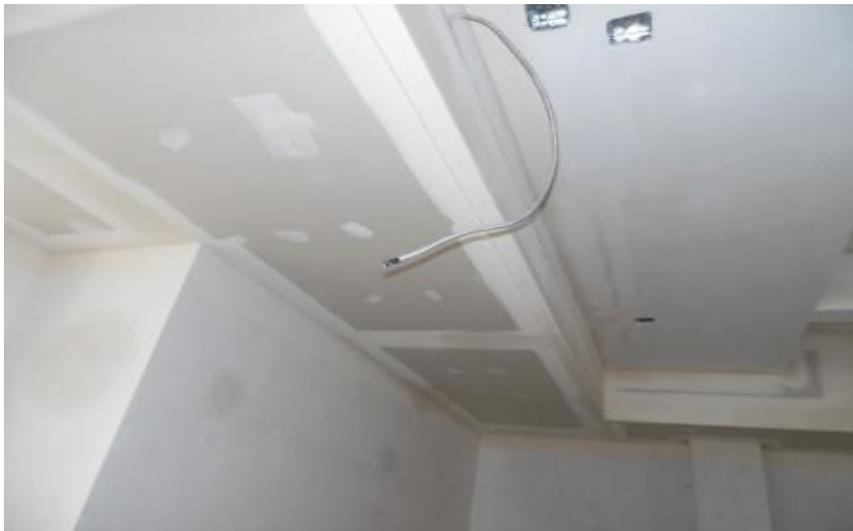
*Ilustración 249-Plafón liso empastado previo a la aplicación de pintura.*
