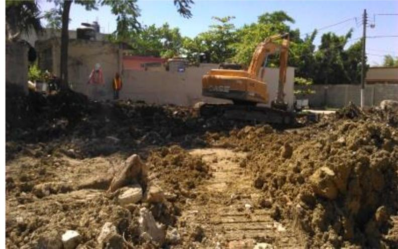
*Ilustración 75-Movimiento de tierras para retirar material excedente.*
