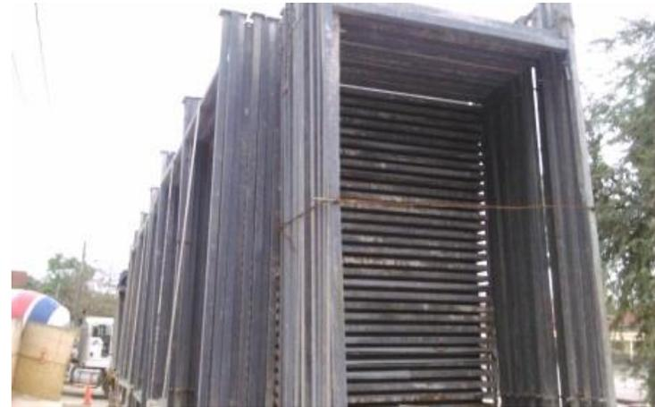
Ilustración 150.-Acomodo de cimbra prefabricada Coppel en cama baja.
