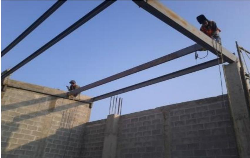
*Ilustración 167.-Colocaciones de sección canal tipo C*
