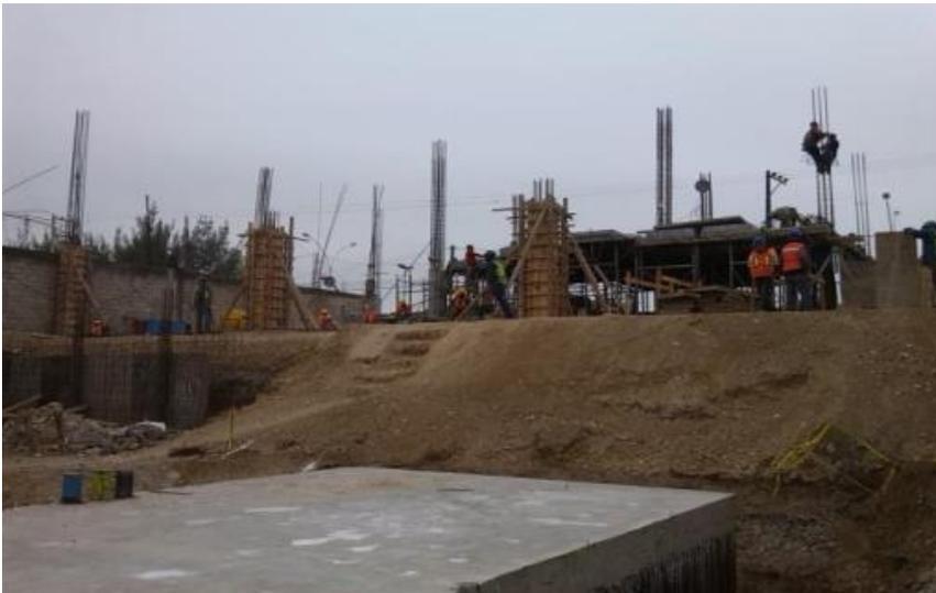
*Ilustración 142.-Proceso de cimbrado de columnas.*
