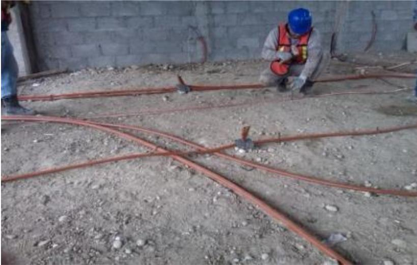
*Ilustración 193-Colocación de manguera canalizaciones de sistemas.*
