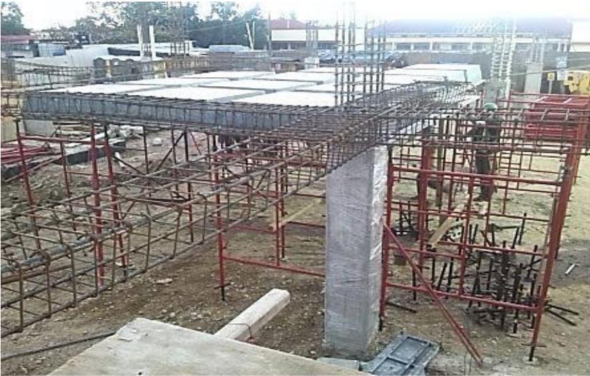
*Ilustración 139-Cubrir las columnas con emplea es uno de las técnicas de curado más comunes en obra.*
