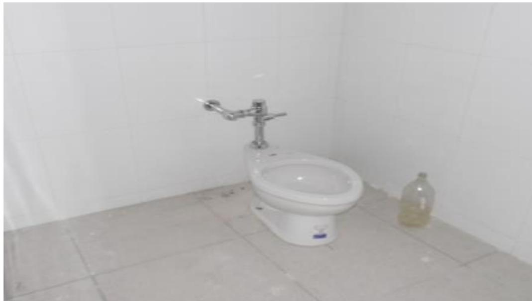
*Ilustración 262-Vista de cerámico terminados juntados y limpios en piso y muros en baño,.*
