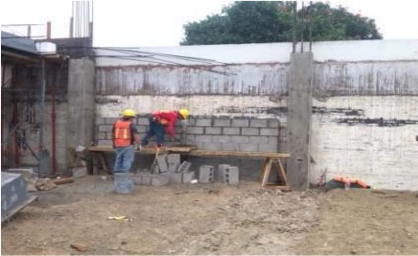
*Ilustración 181.-Construcción de muro de block perimetral.*
