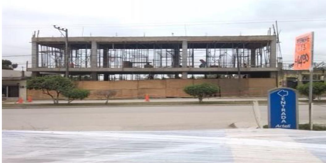
*Ilustración 184.-Vista de fachada principal marcos rígidos de concreto armado.*
