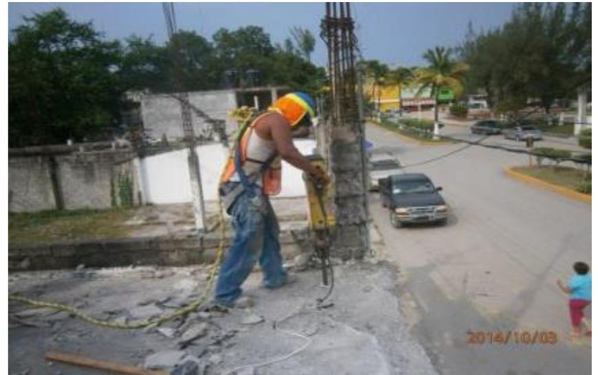
*Ilustración 73-Demolición de cimentaciones existentes de concreto.*
