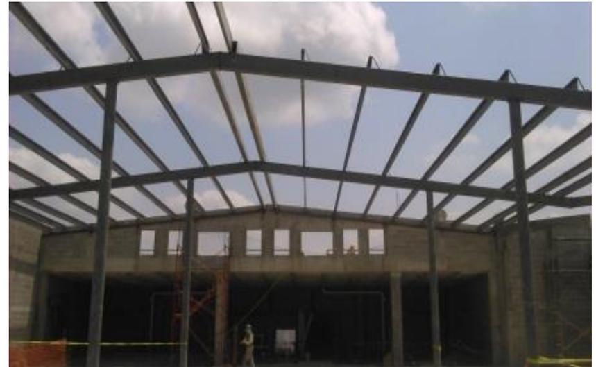
Ilustración 172.-Estructura metálica apoyada en muro piña.
