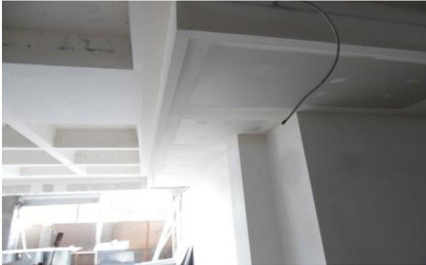
*Ilustración 247-Plafón de tabla roca en perímetro de piso de venta.*
