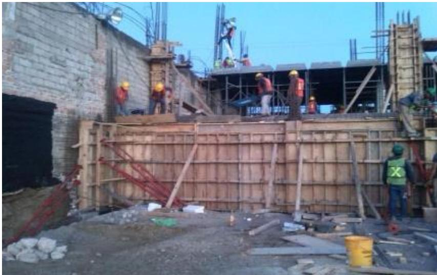
*Ilustración 133.-troquelado de cimbra para colado de muro de contención.*
