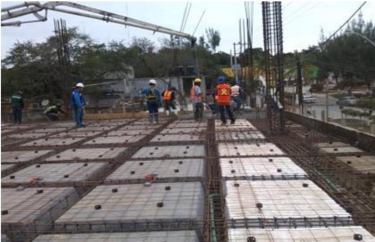
Ilustración 160.-Notese la colocación de silletas para la malla electro soldada 6-6/8-8 como marca el proyecto.
