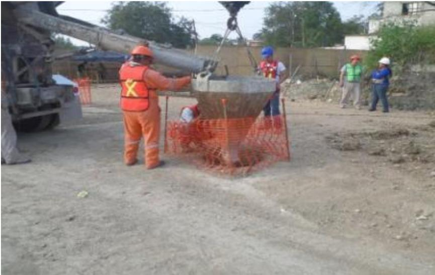
*Ilustración 123.-Colado de pilas en zona central del predio.*
