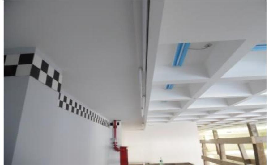
*Ilustración 269-Tipo de moldura que se hace con azulejos llamada dominó que se coloca regularmente en área de línea blanca.*
