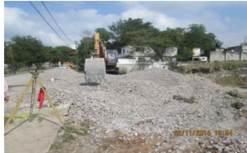
Ilustración 81.-Se extiende material pétreo para que no se atasquen los vehículos al transitar sobre material fangoso.
