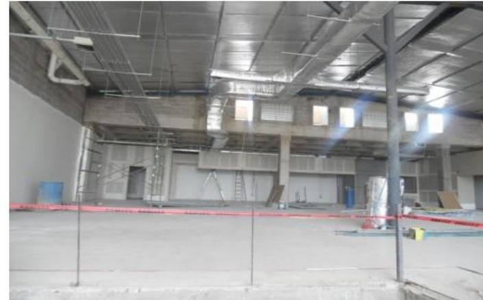
*Ilustración 216-Instalación de aire acondicionado en primer nivel.*
