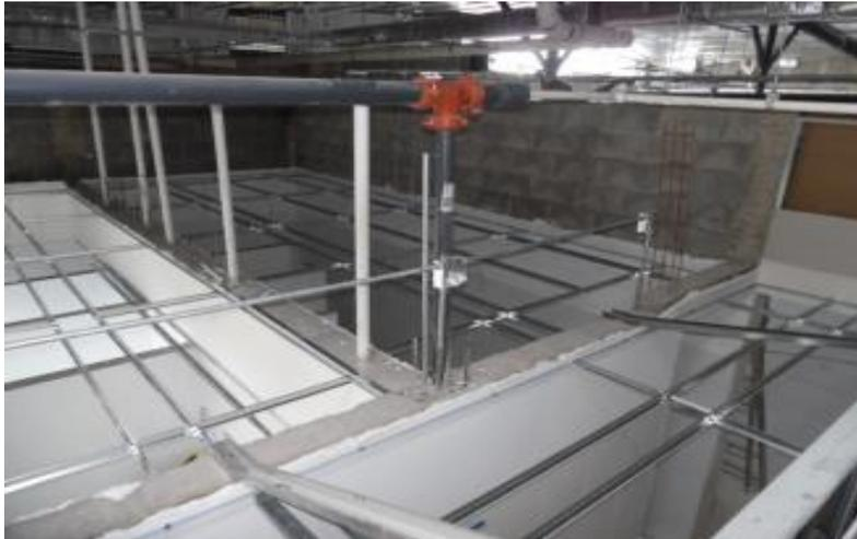
*Ilustración 227-Trayectoria de tubería de alimentación de agua en área de baños y cuarto de servicio.*
