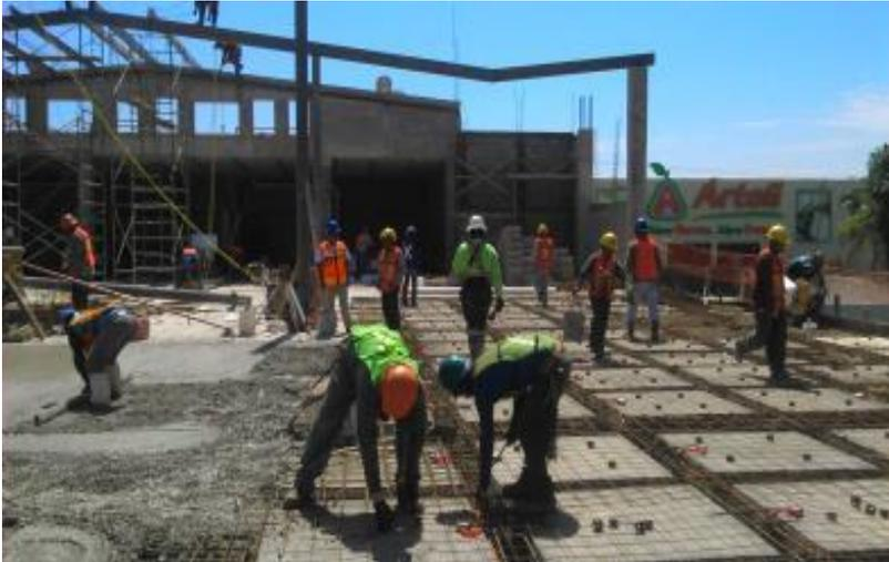
*Ilustración 162.-Corrección de detalles de instalaciones mientras se está colando.*
