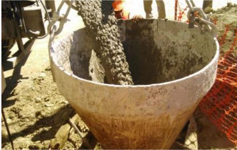
*Ilustración 119.-Embudo metálico para colado de pilas.*
