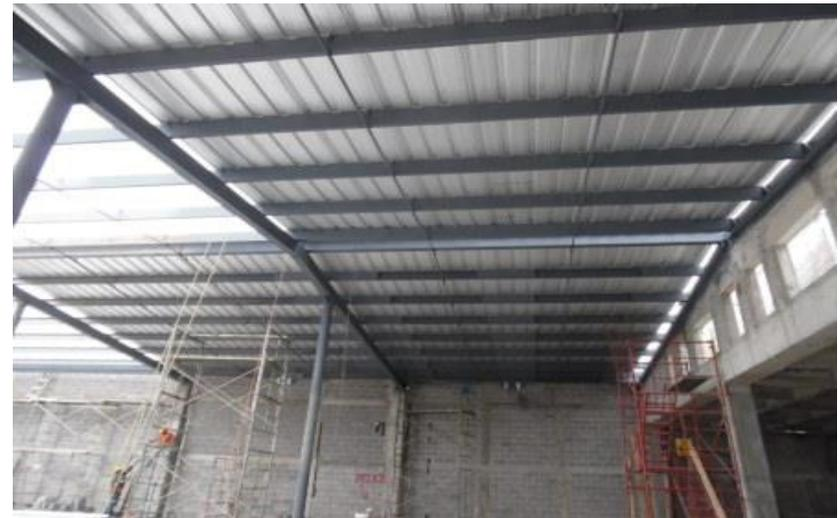
*Ilustración 175.-Colocación de lámina galvanizada.*
