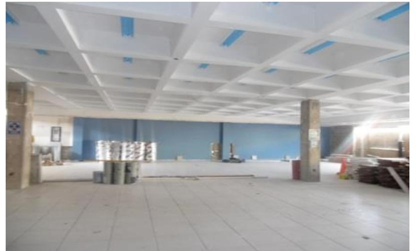
*Ilustración 241-Aplicación de pasta Ready Mix en lecho inferior de losa.*
