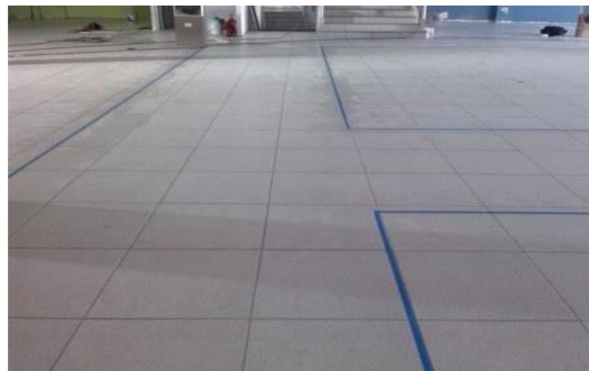
*Ilustración 274-Trazo de pasillos en piso de venta planta baja.*
