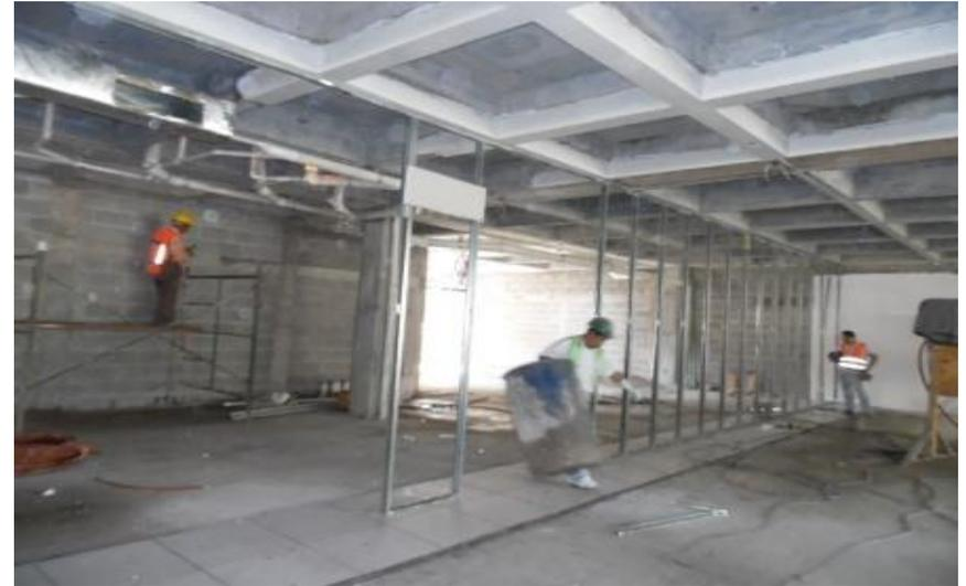
*Ilustración 248-Elaboración de muros divisorios de Tabla roca.*
