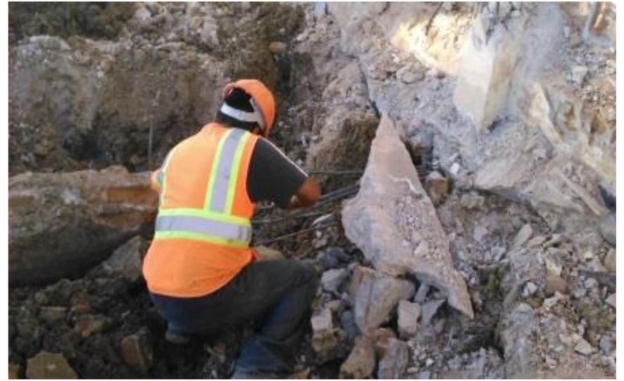
*Ilustración 71-Demolición de cimentaciones existentes de concreto.*
