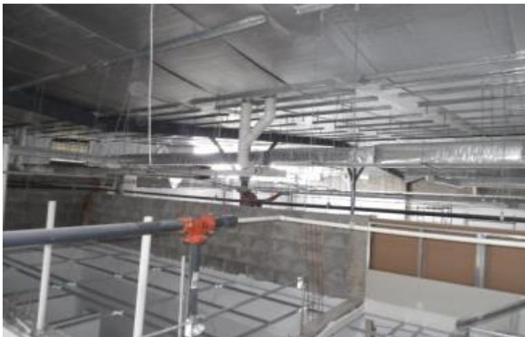
*Ilustración 230-Ramales de alimentación de agua potable para baños, cuarto de servicio y tarja de azotea*
