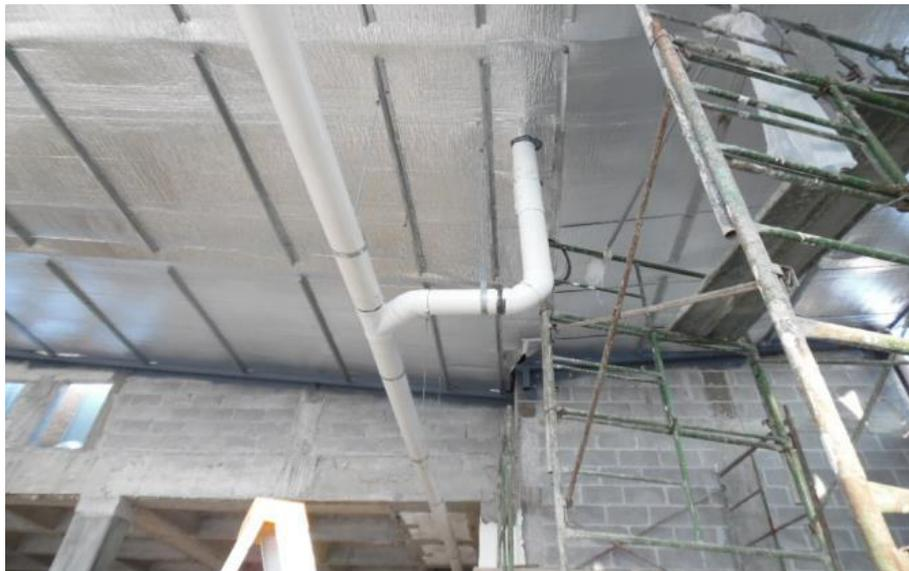
Ilustración 235-Paso para instalación pluvial de reflectix y lamina
