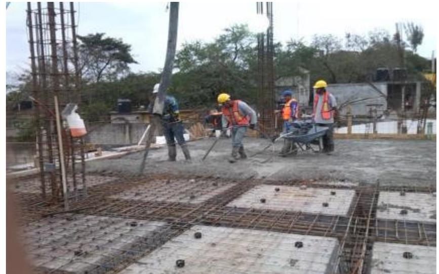
*Ilustración 156.-colado de losa de entepiso tipo Coppel.*
