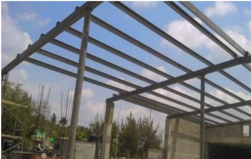
*Ilustración 170.-Colocación de vigas y columnas metálicas.*
