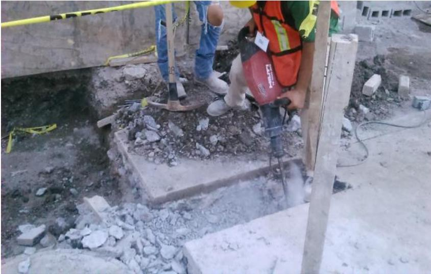
*Ilustración 204-Habilitado de trinchera para instalación de registro.*
