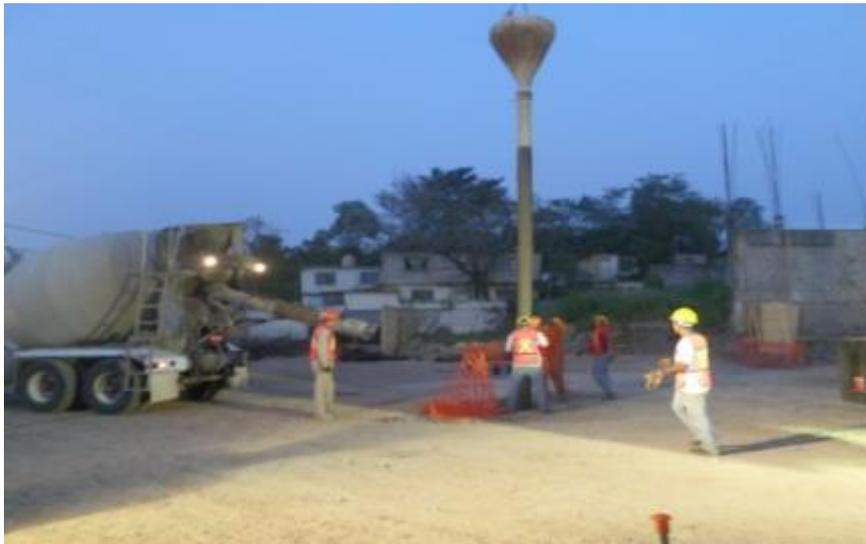
*Ilustración 124.-Colocación de tubo tremi en el colado de pilas.*
