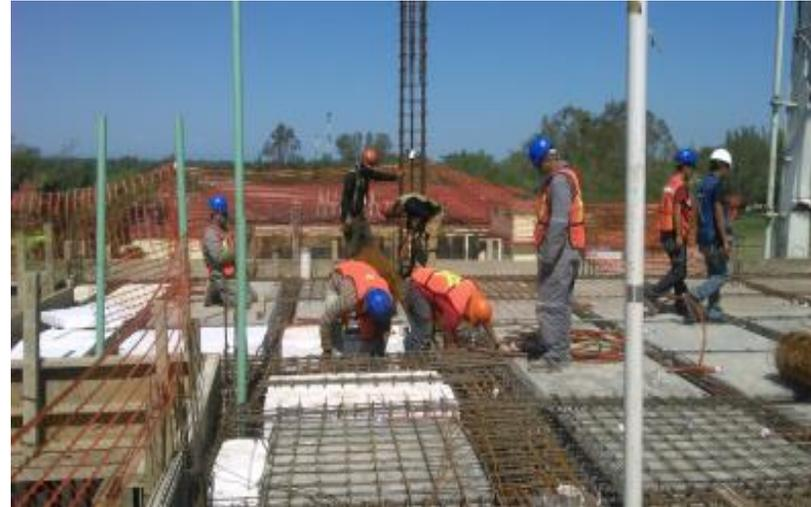
*Ilustración 163.-Colocación de disparos de instalaciones en losa de entrapiso.*
