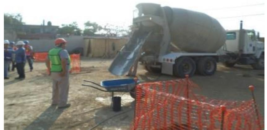
*Ilustración 120.-Colado de pilas con concreto premezclada clase 1*
