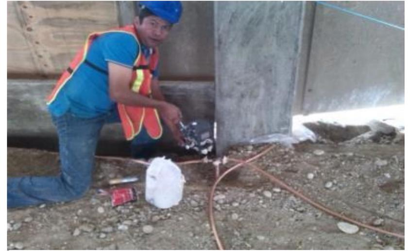
*Ilustración 195-Soldadura en electrodo para sistema de tierra física.*
