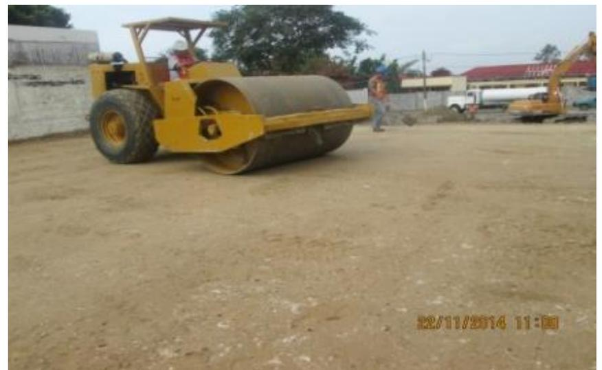
*Ilustración 89.-Movimiento de tierras y compactación de suelo para comenzar desplante de cimentación.*
