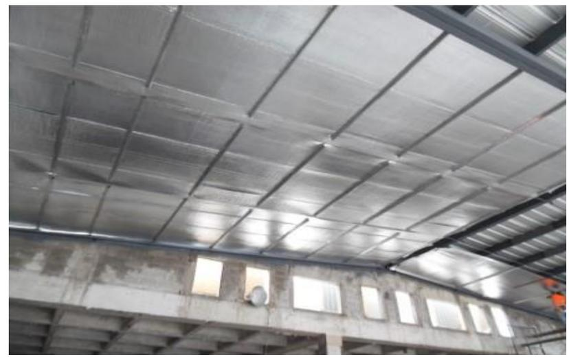
*Ilustración 177.-Colocación de Reflectix para regular temperatura.*
