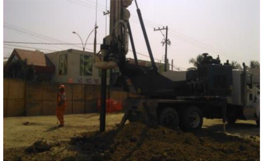
*Ilustración 108.-Perforación en suelo cerca de la fachada.*
