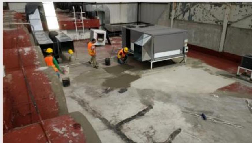
Se han hecho entortados para garantizar la pendiente y canalizar el agua hacia las tuberías de desagüe.
