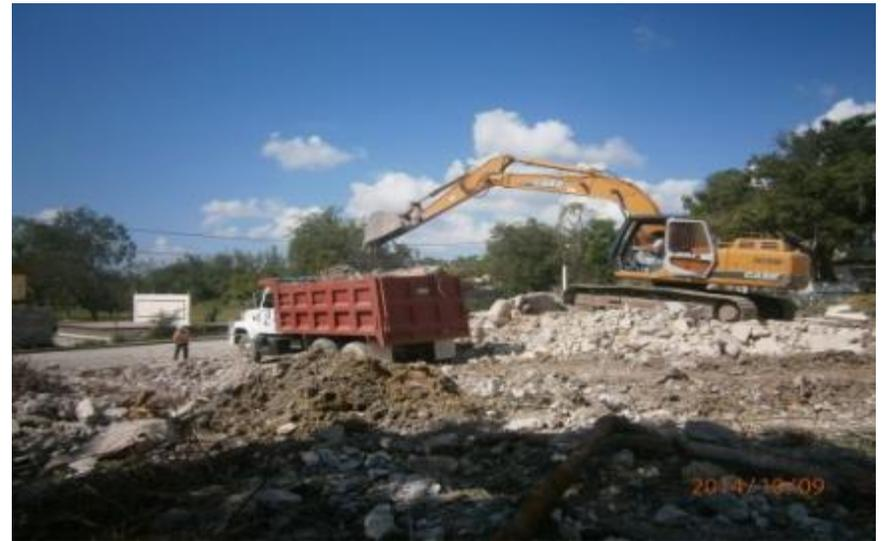
*Ilustración 68.-Retiro de escombros en camión de volteo de 14 m3.*
