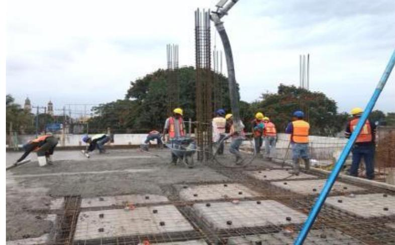
Ilustración 158.-Extendido de concreto premezclado en colado.
