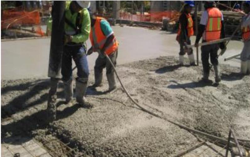
*Ilustración 164.-vibrado de concreto en trabes y nervaduras de losa tipo Coppel.*
