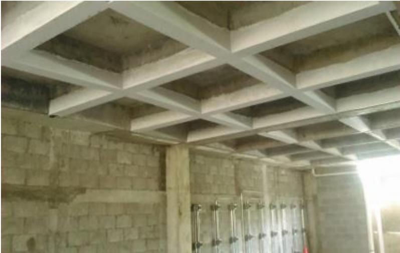
*Ilustración 240-Aplicación de yeso en lecho inferior de losa.*
