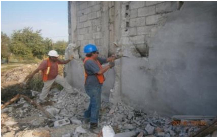
*Ilustración 74-Demolición de cimentaciones existentes de concreto.*
