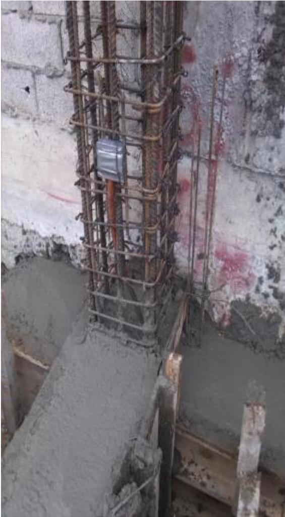
*Ilustración 144-Colado de columnas con contratraves.*
