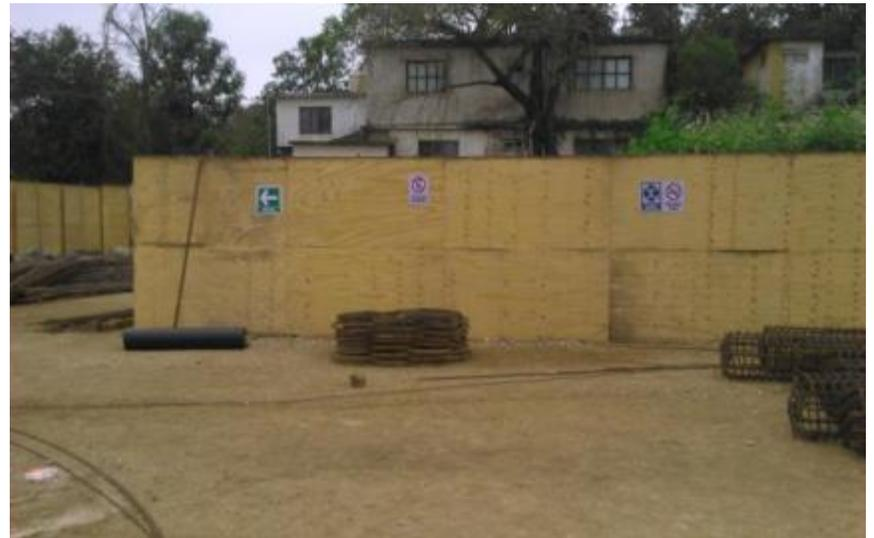
*Ilustración 103.-Armado de acero en pilotes.*
