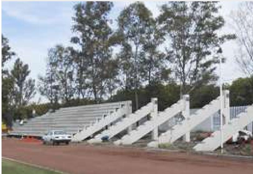
Imagen 40. Gradas prefabricadas de concreto.
