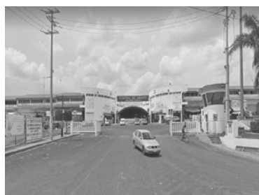
Imagen 66 Central de Abasto | Google Maps
