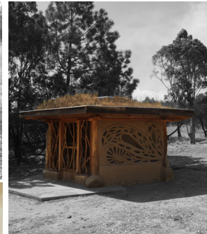
Fig 63 Entramados: Maqueta de muro de bajareque, detalle de entresijo de pajarcilla con acabado de yeso y cubierta de madera. Estructura de madera con muros de relleno. Obras en Proyecto San Isidro. Fotografías del autor.
