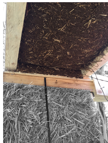
Fig 71 Cadena de madera que recibe viguetas para entrepiso de pajarcilla. Fotografía del autor.
