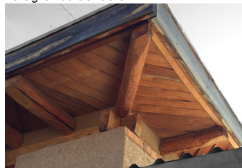
Fig 67 Ensamble en esquina de muros. Fotografías del autor.
