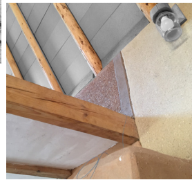
Fig 63 Entramados: Maqueta de muro de bajareque, detalle de entresijo de pajarcilla con acabado de yeso y cubierta de madera. Estructura de madera con muros de relleno. Obras en Proyecto San Isidro. Fotografías del autor.
