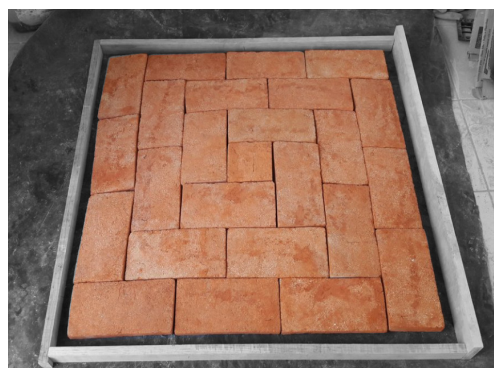
Fig 51 Fabricación del Domotej en obra. Tomado de Castañeda Nolasco, 2022.
