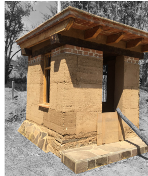
Fig 62 Técnicas masivas: Detalle de muro de adobe, inicio de muro de tapial y construcción de tierra apisonada que carga una losa catalana. Obras en Proyecto San Isidro. Fotografías del autor.
