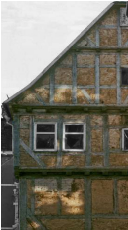
Fig 22 Leichtlehbau en Alemania. Volhard, 2016.
