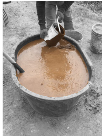
Fig 57 Consistencia adecuada para su uso en pajarcilla. Fotografía del autor.
