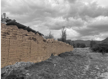
Fig 8 Barda de predio hecha con adobe en Atltzayanca, Fotografía del autor.
