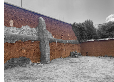
Fig 10 Barda de adobe con contrafuerte de tabique en Patzcuaro. Fotografía del autor.
