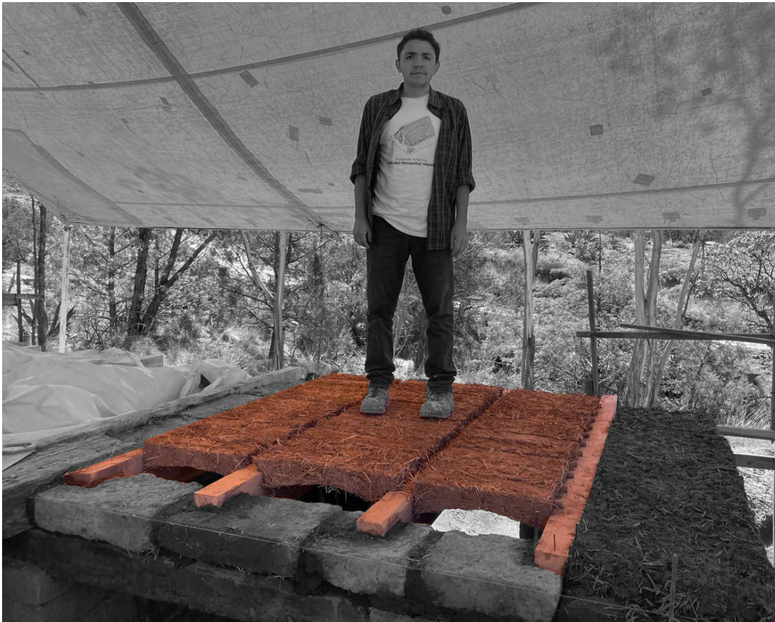
Fig 198 Construcción a escala real del entrepiso semi-prefabricado de pajarcilla. Fotografía del autor.
