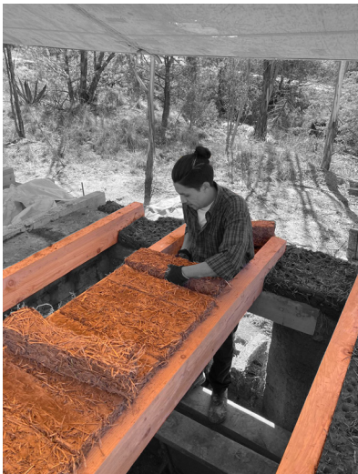
Fig 195 Colocación de piezas prefabricadas sobre viguetas de madera. Fotografía del autor.
