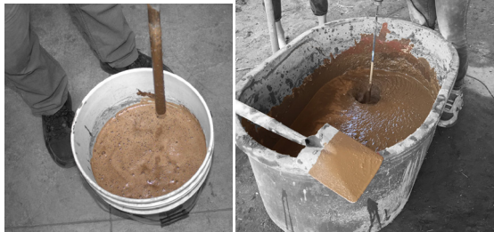
Fig 58 Revoltura de la barbotina con ayuda de un mezclador de pintura o de forma manual con un palo de madera. Fotografías del autor.
