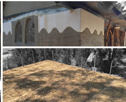
Fig 69,70 Viga collar sobre muros y vanos que mantiene unidas las esquinas portantes de tierra apisonada. Entre- piso de pajarcilla como desplante del siguiente nivel. Obras en Proyecto San Isidro. Fotogra- fías del autor.
