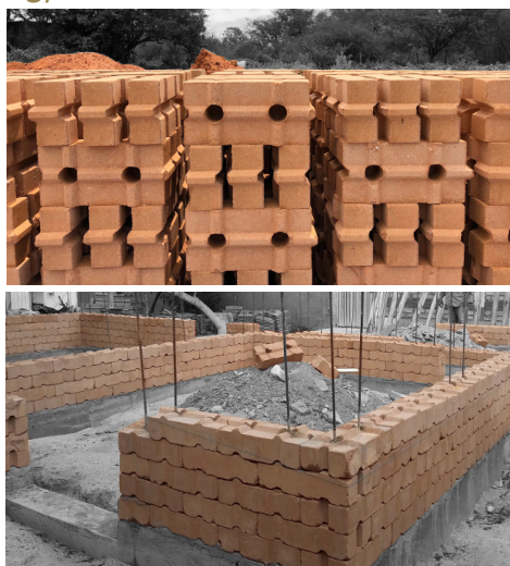
Fig 43 Piezas de machimbloque y colocación en obra. Fotografías de Comunal Taller, 2020. Edición propia.
