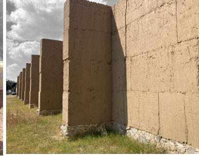
Fig 79 Barda y contrafuertes de tapial para propiciar un mejor apoyo en el suelo. Fotografía del autor.
