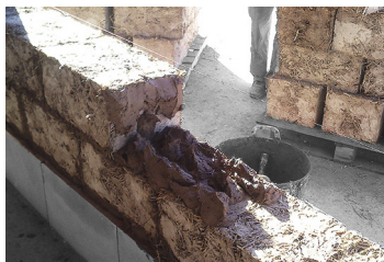
Fig 49 Swallow brick y su colocación en obra. Fotografías de Swallow brick, 2022. Edición propia.
