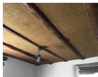
Fig 73 Vista inferior del entrepiso de pajarcilla. Fotografía del autor.
