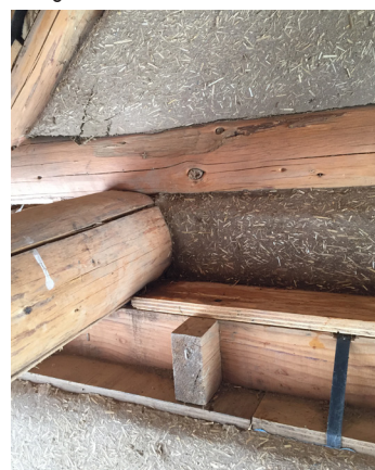
Fig 72 Interacción de la estructura de madera con la pajarcilla en muro y entrepiso. Fotografía del autor.
