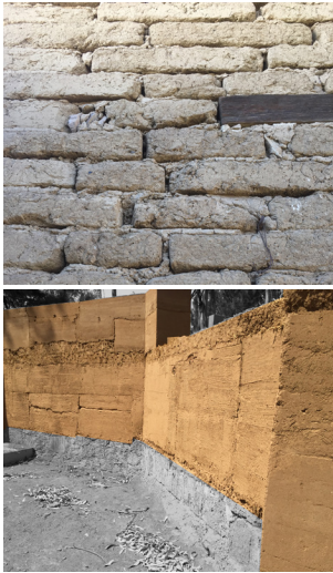
Fig 62 Técnicas masivas: Detalle de muro de adobe, inicio de muro de tapial y construcción de tierra apisonada que carga una losa catalana. Obras en Proyecto San Isidro. Fotografías del autor.
