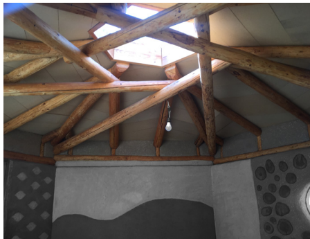
Fig 68 Estructura recíproca de madera que al estar sobre la viga collar fun- ciona como diafragma. Fotografías del autor.
