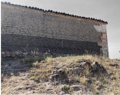
Fig 77 Diferencias entre suelo y tierra. Muro de adobe sobre suelo seco. Fotografía del autor.
