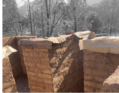
Fig 78 Construcción de adobe sobre cimientos de piedra asentado sobre el suelo del terreno. Fotografía del autor.
