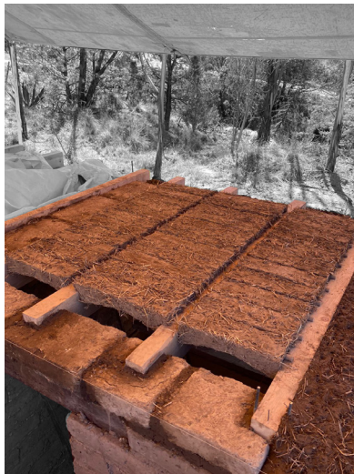
Fig 196 Vista superior de entrepiso semi-prefabricado de pajarcilla. Fotografía del autor.
