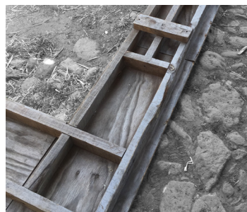
Fig 65 Armado de viga collar de madera previo a su colocación. Fotografías del autor.
