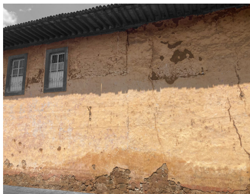
Fig 12 Vivienda de 2 niveles hecha de adobe con recubrimiento de cal-arena en Morelia. Fotografía del autor.
