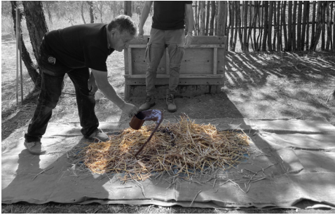
Fig 60 Colocación por capas de paja y barbotina para hacer la pajarcilla y mezclado con biello. Fotografías del autor.
