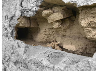
Fig 9 Interior de muro de adobe recubierto de piedra en Puebla. Fotografía del autor.
