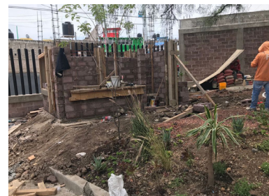
66 Fotos de proceso de obra en estación 5 Cablebús Foto propia
