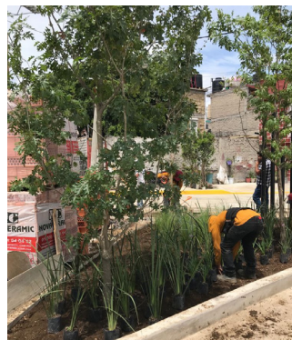
67 Foto de proceso de obra de estación 3 Línea 2 de Cablebús Foto propia
