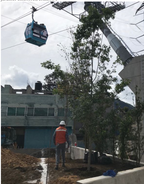
64 Trazo de jardineras en estación 3 de Cablebús, Línea 2 Iztapalapa
