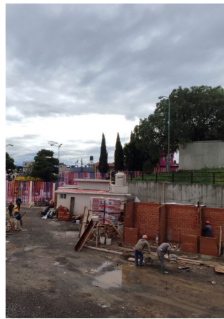
69 Foto de proceso de obra de estación 6 Línea 2 de Cablebús Foto propia
