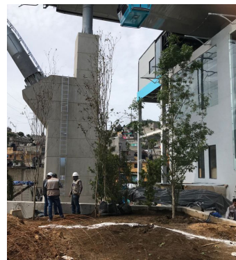
68 Foto de proceso de obra de estación 3 Línea 2 de Cablebús Foto propia
