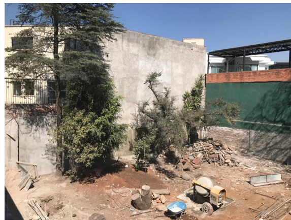
56 Foto de inicio de obra jardín privado : Casa Miramar Fotos propias
