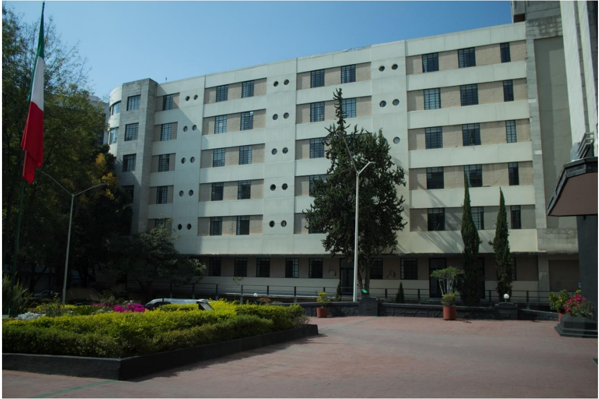
(Fig. 4) Carlos Greenham, arq, Federico Ramos, ing. Hospital Colonia de Ferrocarrileros. Fotografía de Miguel Ángel Illescas Barbosa. Ala lateral derecha del Hospital Colonia de Ferrocarrileros. Fecha: 13/12/22
