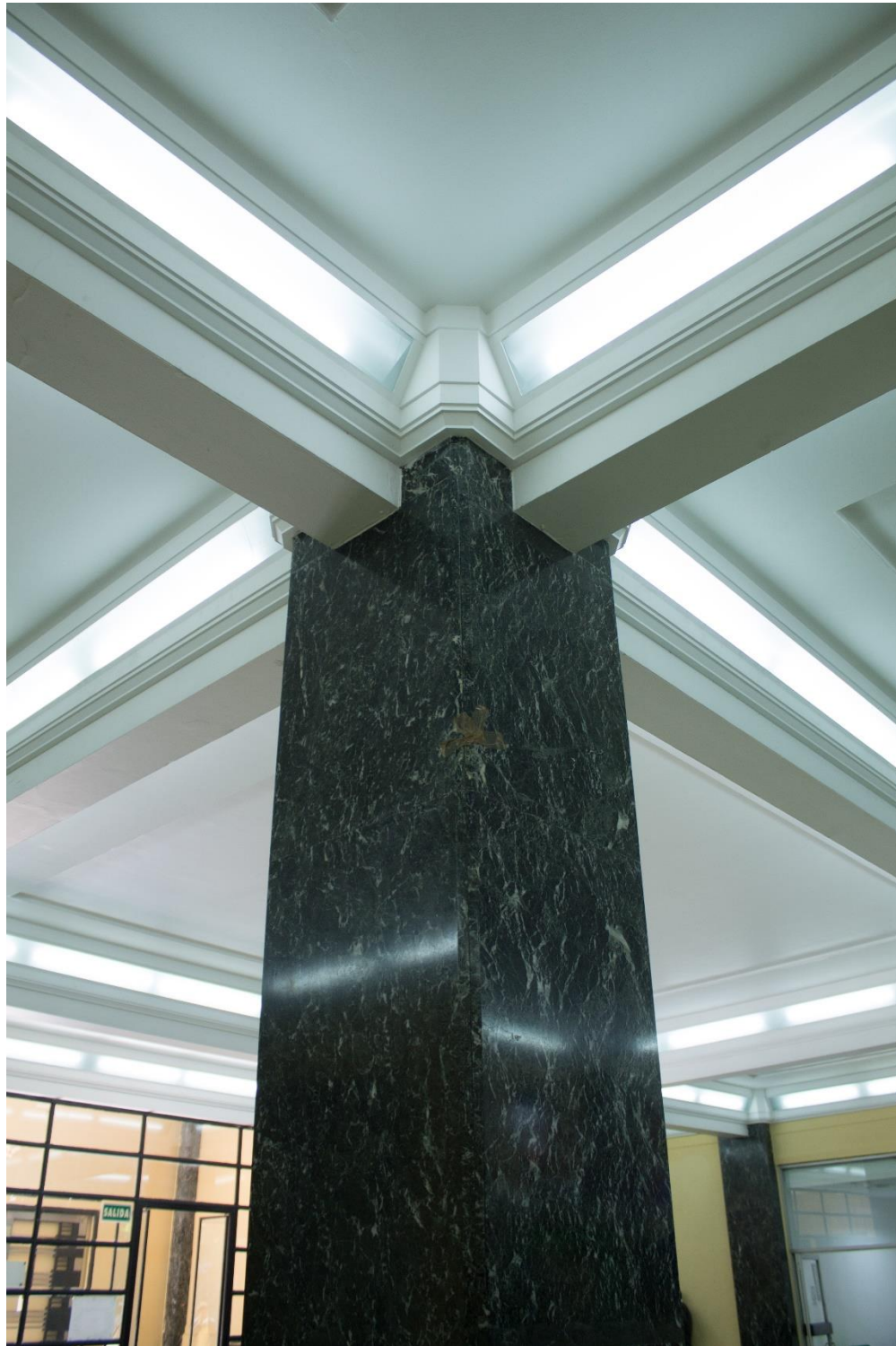
(Fig. 15) Carlos Greenham, arq, Federico Ramos, ing. Hospital Colonia de Ferrocarrileros. Fotografía de Miguel Ángel Illescas Barbosa. Detalle del techo y pilar. Fecha: 13/12/22.
