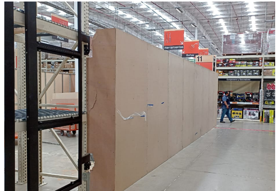
Imagen 39 a) Fotografía colocación de canales en piso b) Fotografía de la colocación de MDF y soportes a base de canales y postes de aluminio. c) Fotografía del tapial terminado. Planos proporcionados por Interceramic. Fotografía de Autoría Propia para Interceramic.
