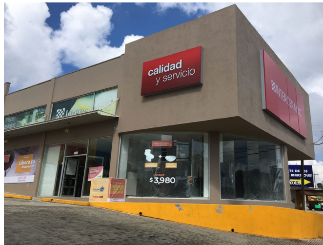
EN ACCESO DE UNA PLAZA
