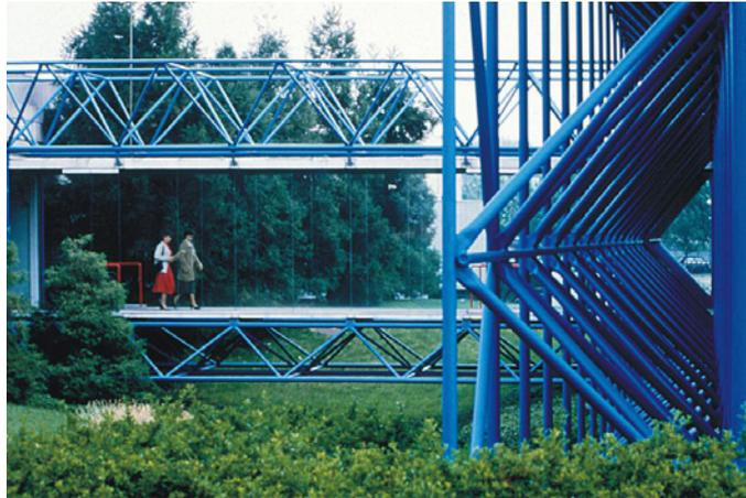
ejemplo, el edificio de oficinas de la fábrica de muebles B&B en Italia de Renzo Piano y Richard Rogers representa la experimentación de la idea tecnológica de crear un contenedor suspendido. A través de una serie de 20 pórticos de acero tubular se logra una innovación técnica y funcional que ha determinado este edificio como una obra arquitectónica.
