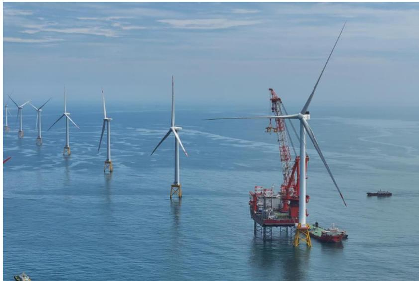
*Figura 2.3. Aerogenerador MingYang Smart Energy MySE 16-260 de la empresa Three Gorges Energy siendo instalado y conectado a la red eléctrica. (Blain, 2023)*
