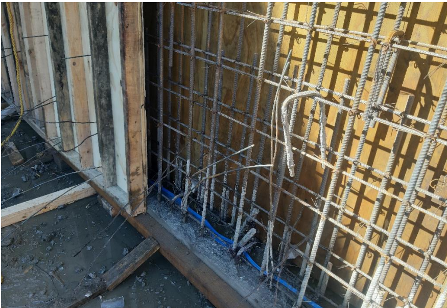
Foto 19: Acero en muro
