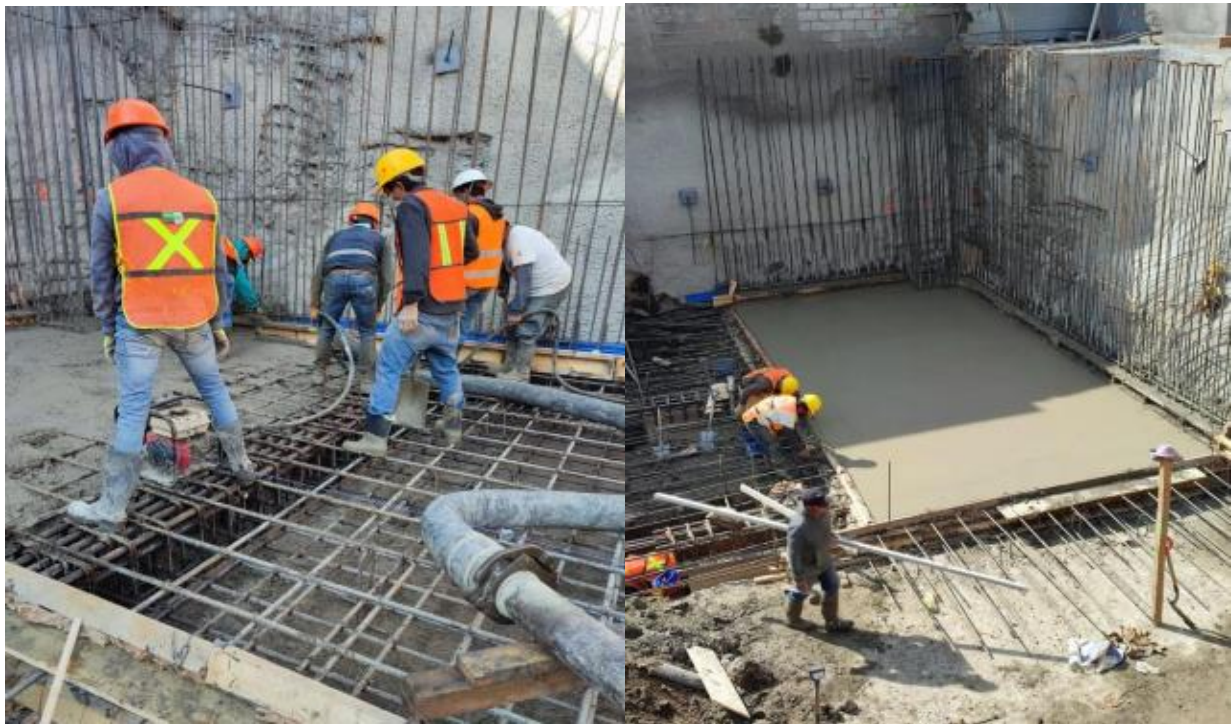
Foto 22-23: Colado y vibrado de concreto.
