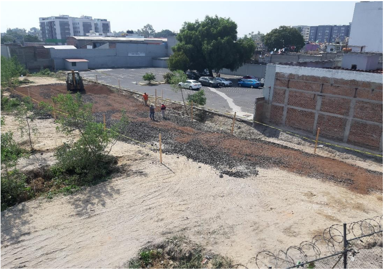
Foto 04: Tendido de balastre.
