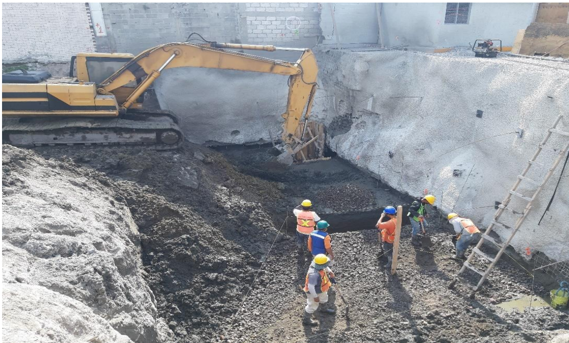
Foto 17: Excavación de cepas.
