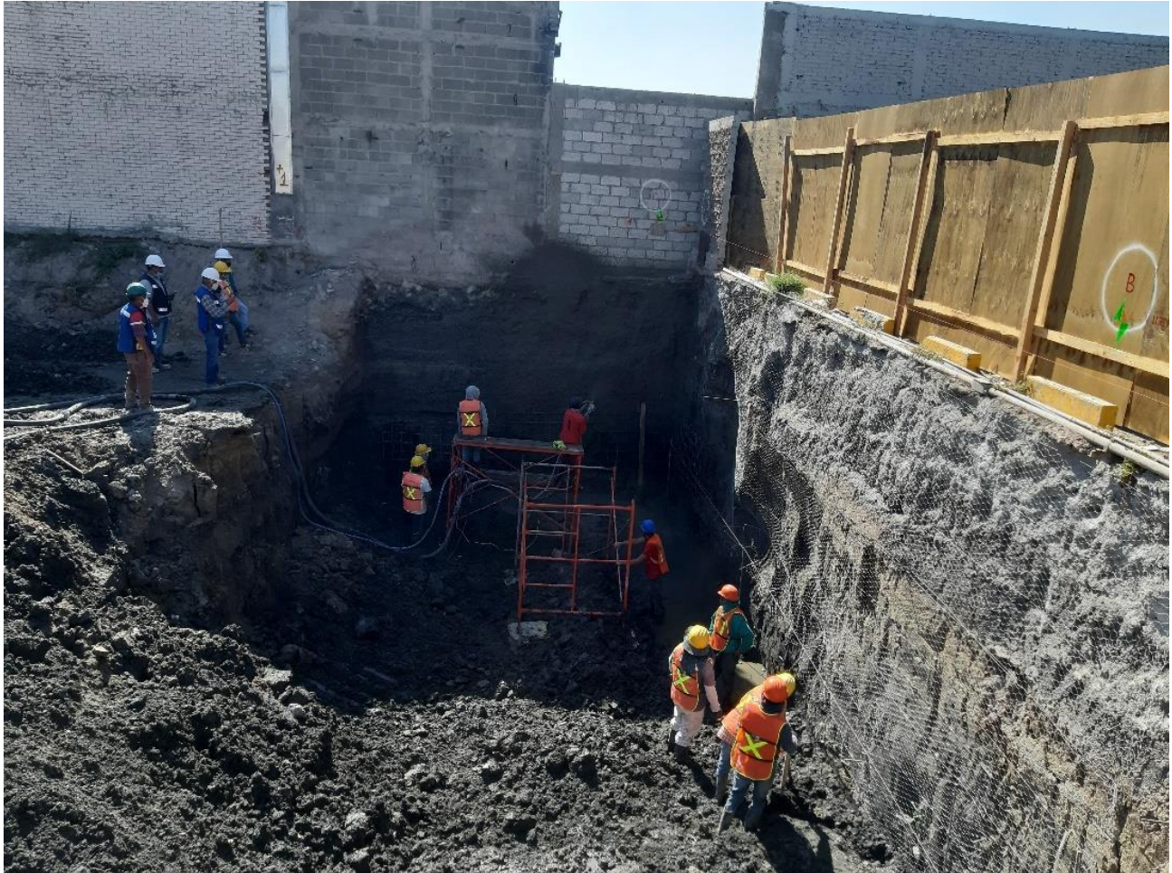
Foto 13: lanzado de concreto.
