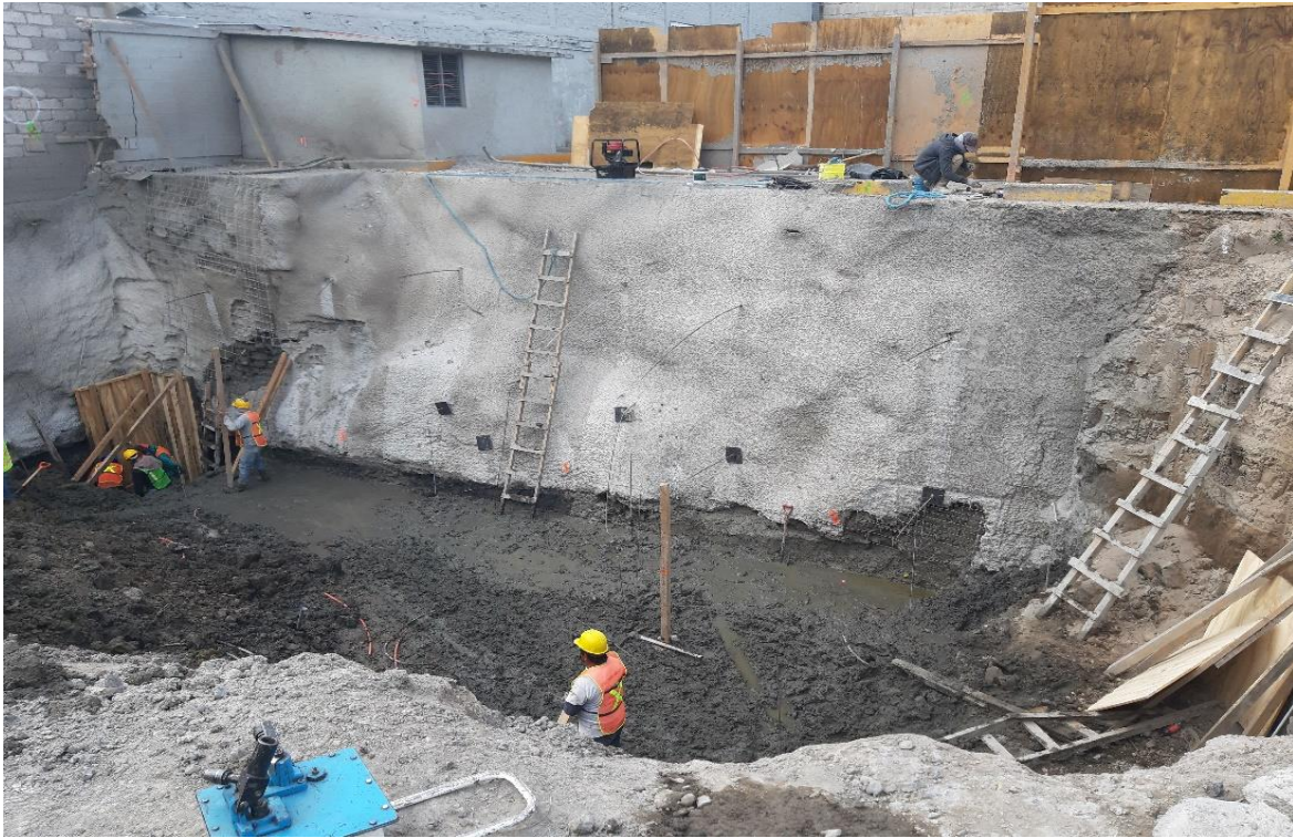
Foto 16: Estabilización con anclas y placas
