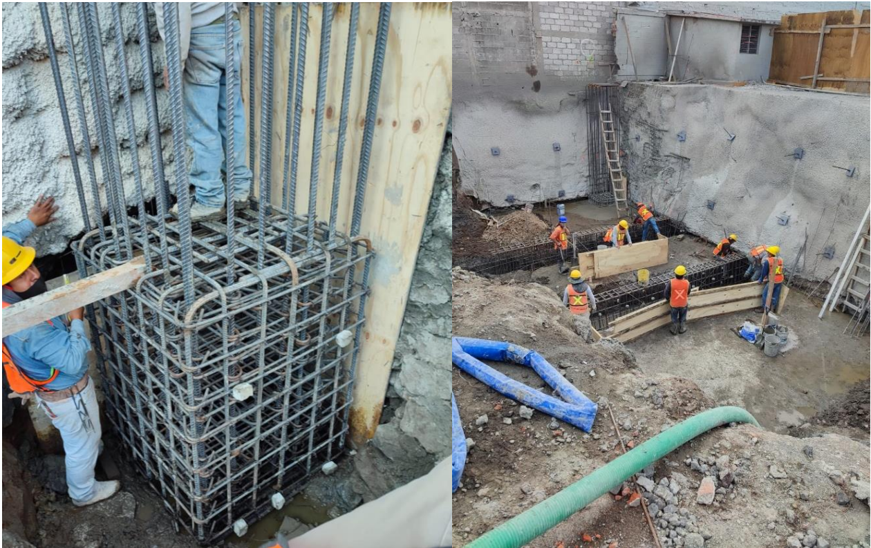
Foto 20 y 20.1: Colocación y armado de acero.
