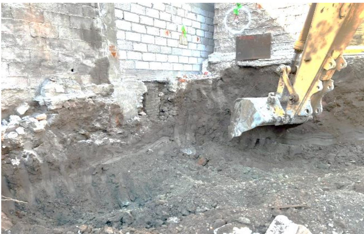
Foto 06: Excavación en caja con máquina excavadora. Fuente: Archivo propio.
