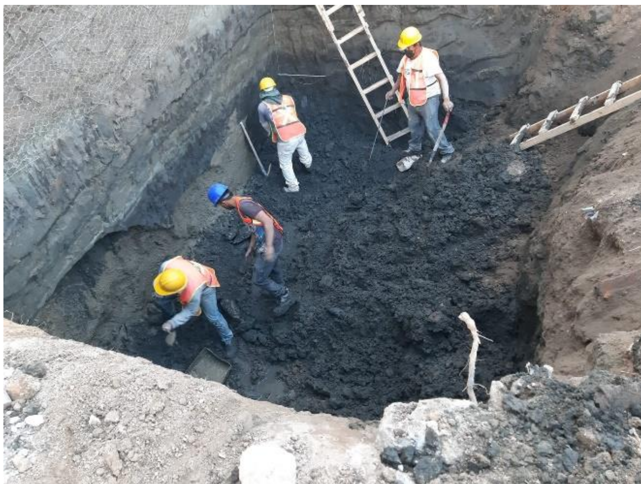
Foto 09: Zampeados y excavación a mano.
