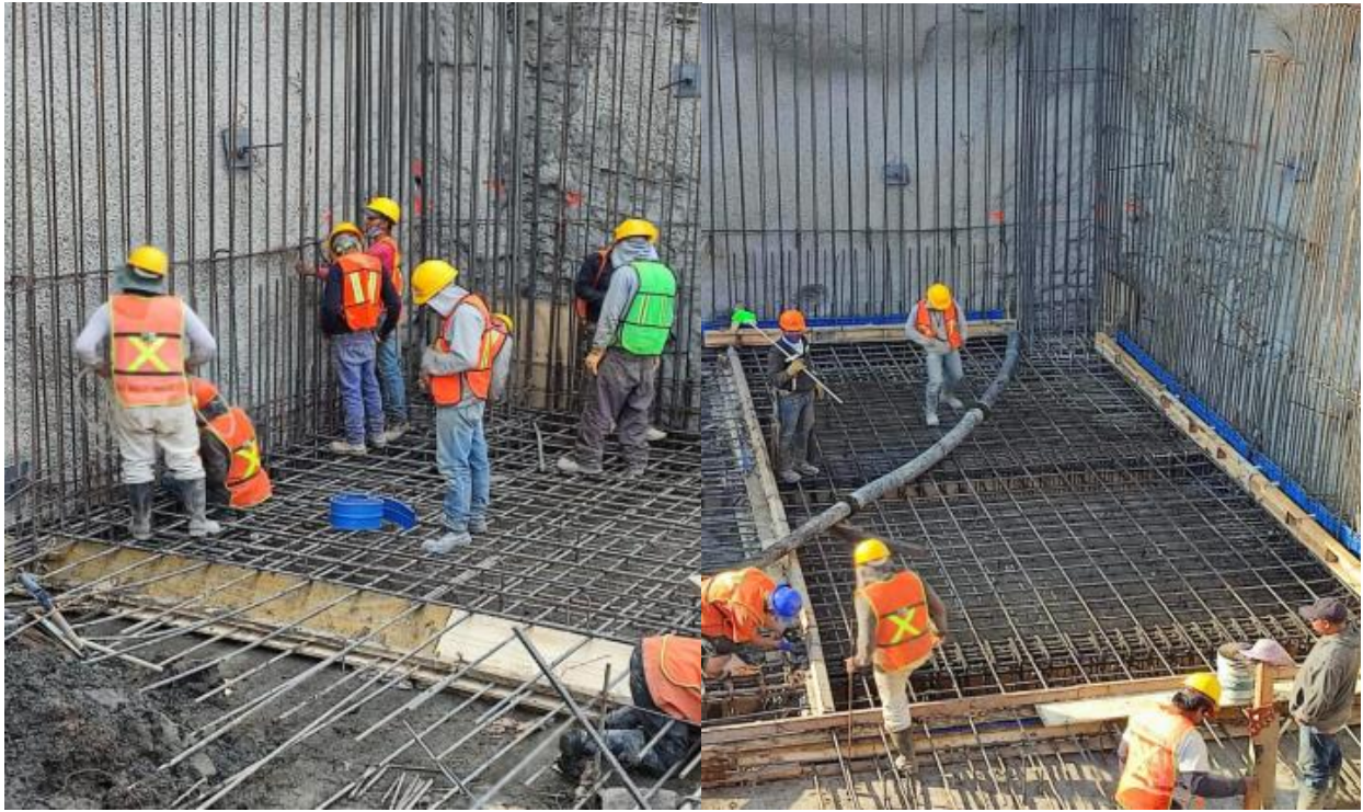
Foto 21: Colocación y armado de acero y cimbra.
