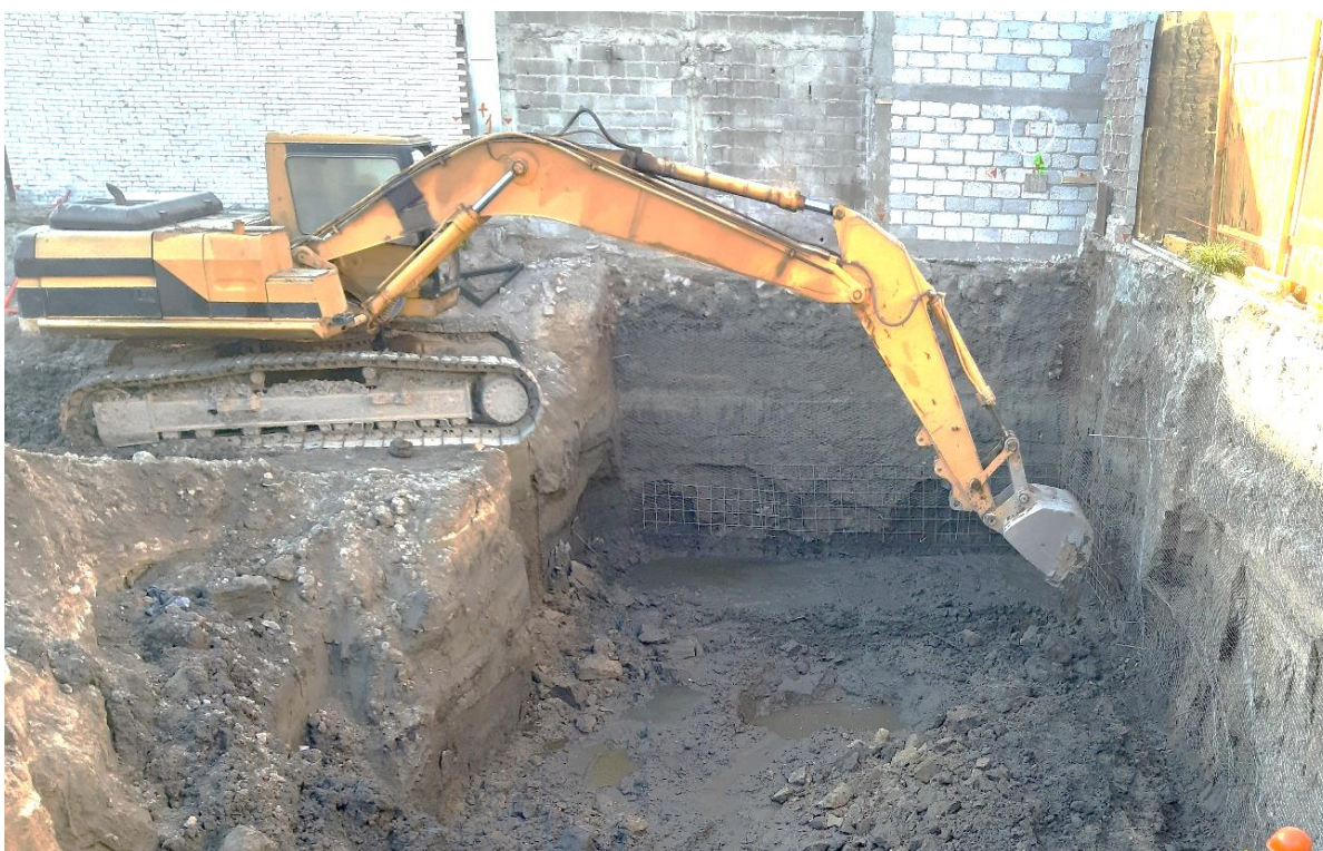
Foto 07: Excavación en caja con máquina excavadora. Fuente: Archivo propio.
