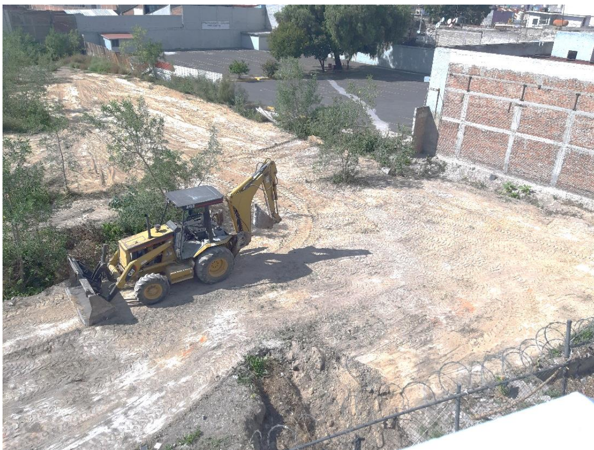
Foto 03: Retroexcavadora limpiando el terreno. Fuente: Archivo propio.
