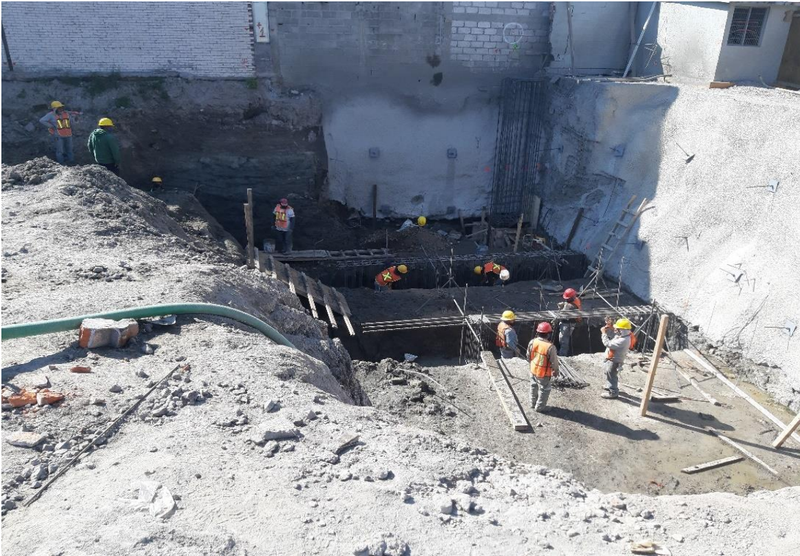
Foto 18: Colocación y armado de acero. Fuente: Archivo propio.
