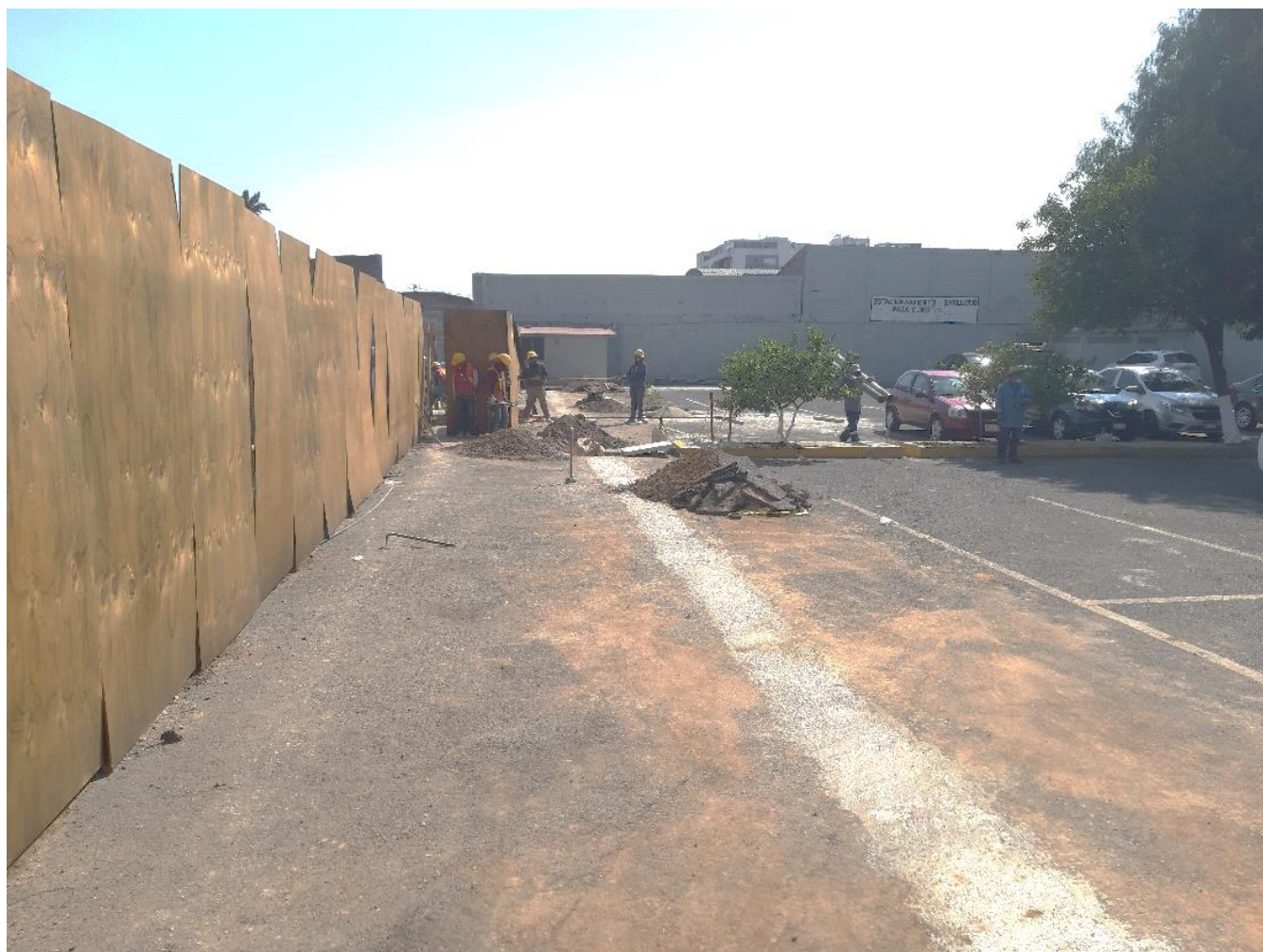
Foto 02: Colocación de tapias.
