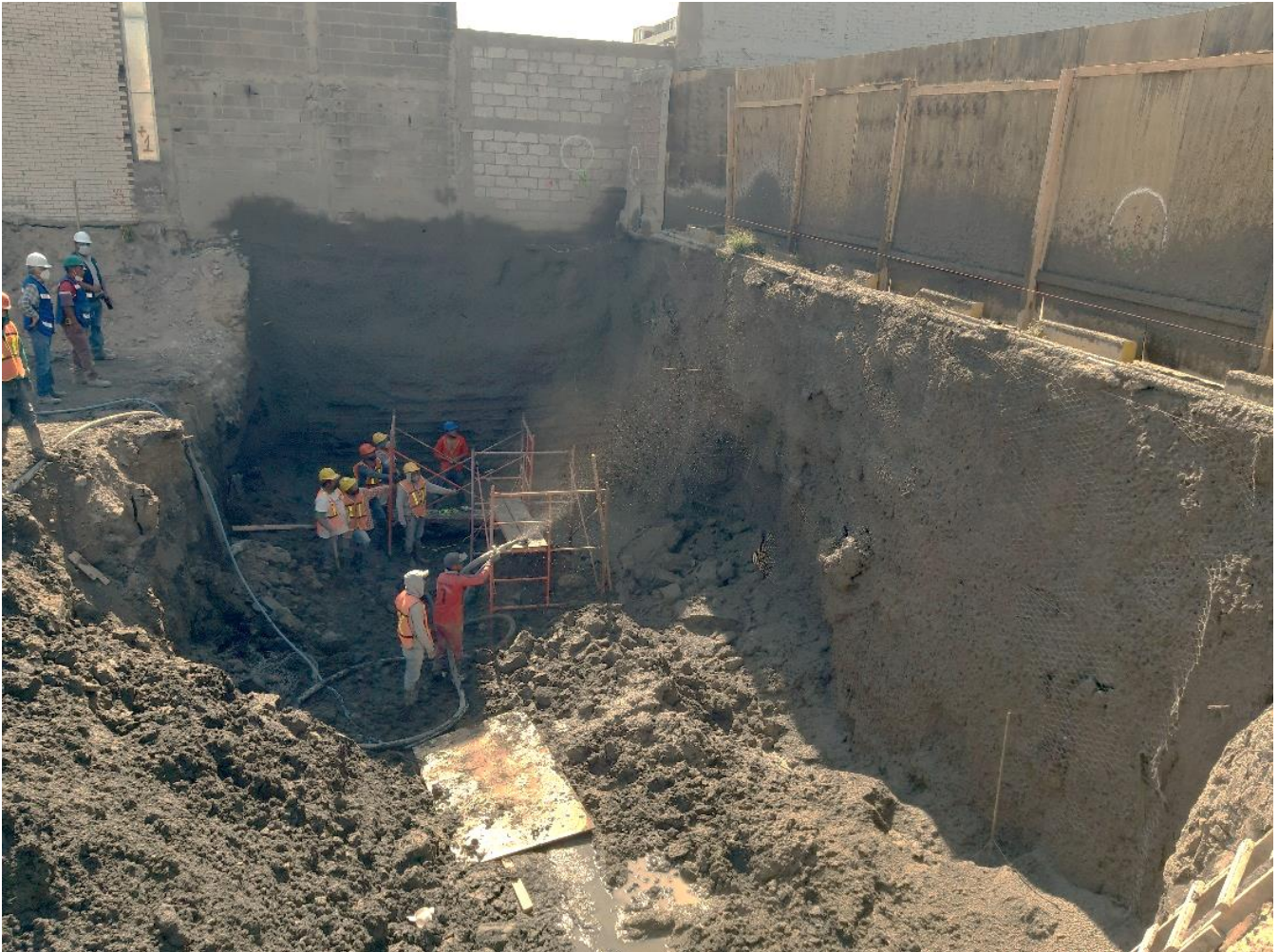
Foto 14: Lanzado de concreto.
