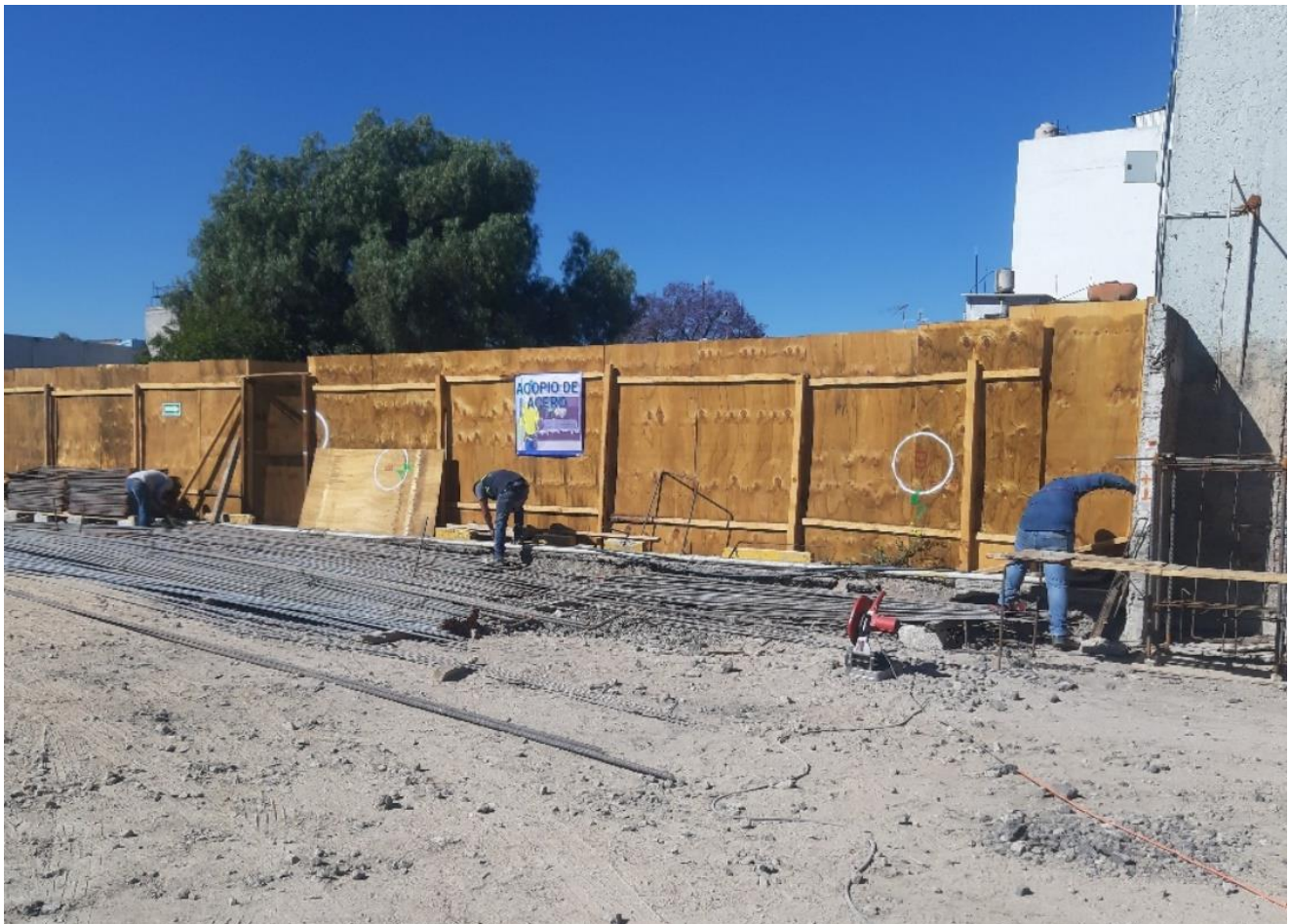
Foto 12: Acopio y habilitado de acero.
