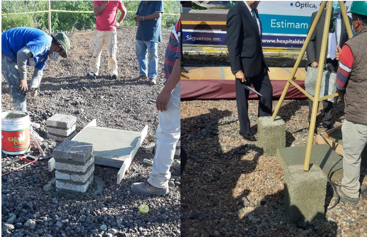
Foto 05 y 05.1: Celebración de colocación de 1ra piedra. Fuente: Archivo propio.
