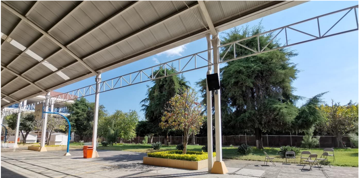
Fig 30. Condición actual de predio de la investigación (Vista principal)
