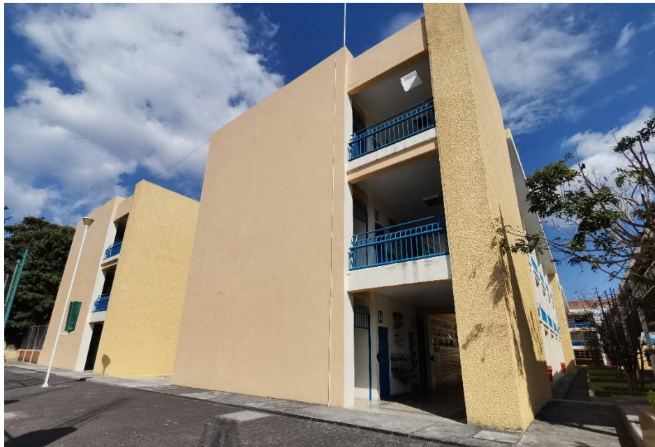
Fig 27. Edificaciones de concreto existentes en la institución
