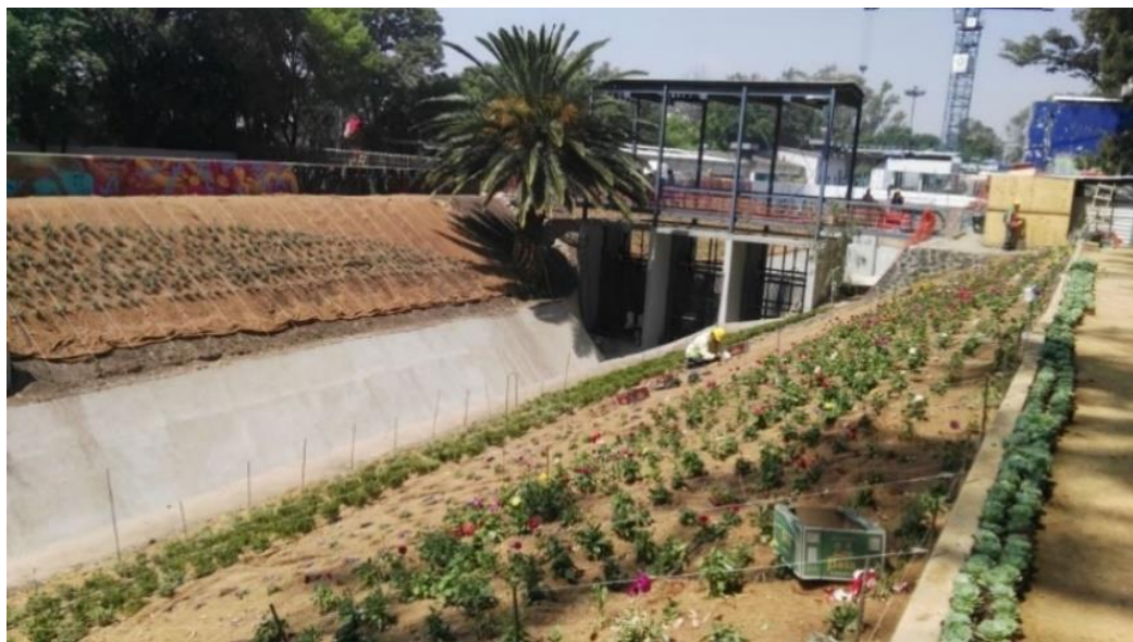
(Fig. 42) Colocación de vegetación en talud, Canal Nacional.
