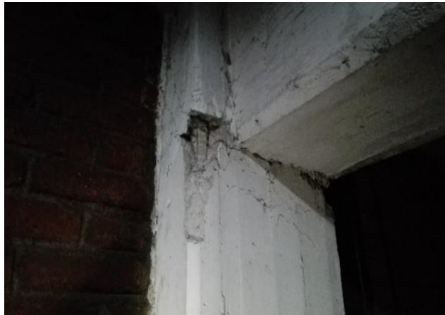
Figura 2.7. Fallas en nudos, conexión trabe-columna. ISCDF (2017).
