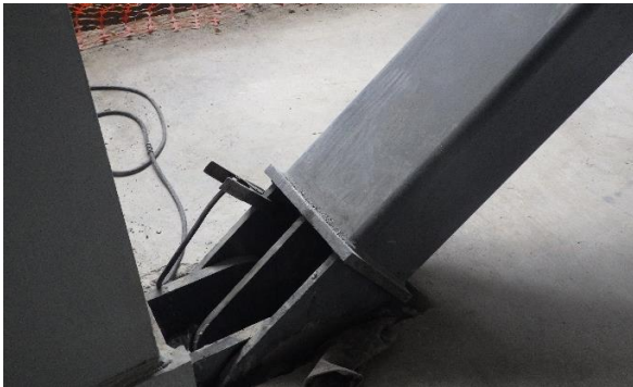
Fig. 3.5. Conexión de amortiguador inferior.
