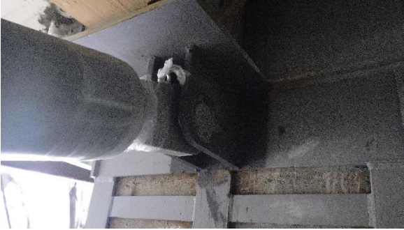
Fig. 3.3. Conexión de amortiguador superior.
