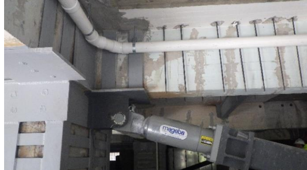
Fig. 3.4. Conexión de amortiguador zona centro.
