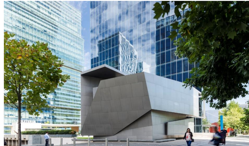
Fachada principal del centro cultural copArtes
