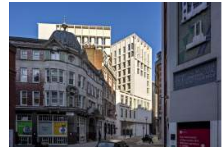
Imagen 23. Fachada Sur y su Contexto
