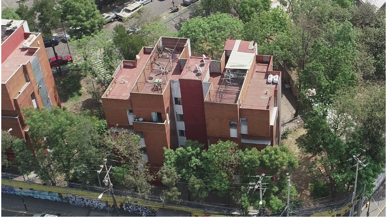
Figura 2.6. Edificio considerado en el caso de estudio.
