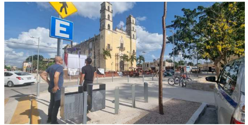
Rehabilitación Centro de Chemax Yucatán / SEDATU
