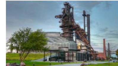
03. Parque Urbano La Cementera Parque La Fundidora, Monterrey, México
