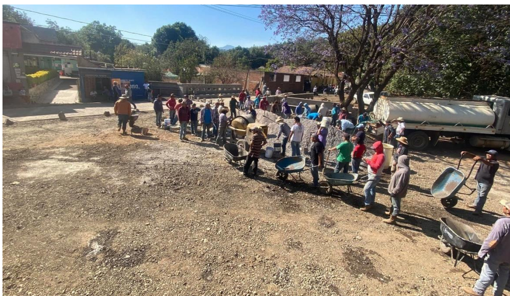
Fotografía 24. Construcción del puente de San Ángel a través de faenas y cooperaciones de la comunidad. Fuente: Por el futuro de san angel, Facebook, publicada el 11 de junio de 2021.
