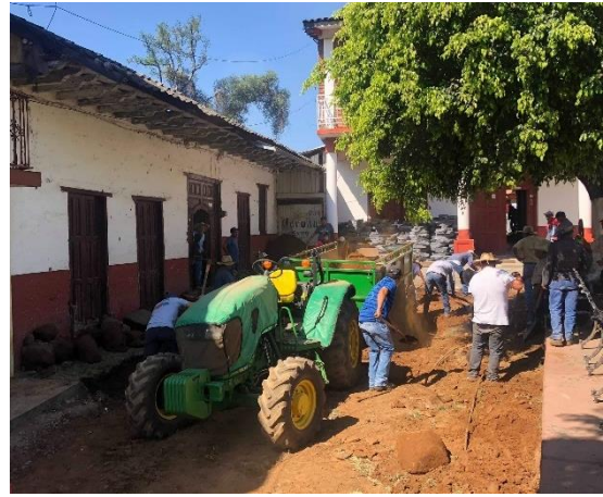
Fotografía 22. Pavimentación de la calle que da acceso a la plaza principal y presidencia comunal de San Ángel Zurumucapio. Fuente: Por el futuro de san angel, Facebook, 18 de noviembre de 2020.
