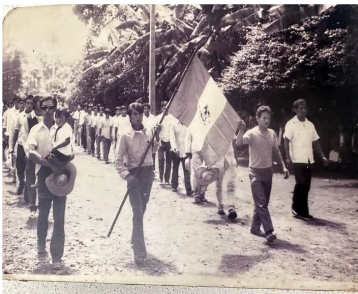
Fotografía 2. Primer Comité de Obras de Faenas en la Comunidad de San Ángel. Fotografías del año 1968, publicadas en Facebook en el perfil “Por el futuro de san angel” el 22 de marzo de 2023. Créditos Sr. Baldomero Motuto Cortes.
