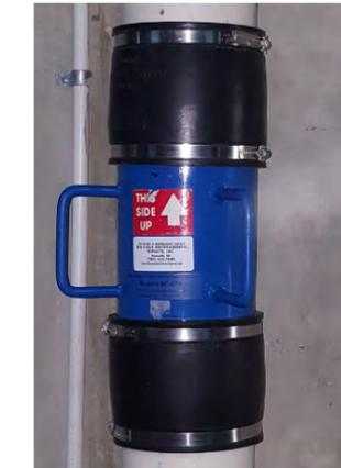
Filtro de bajante pluvial marca Bio Clean para usos no potables.
