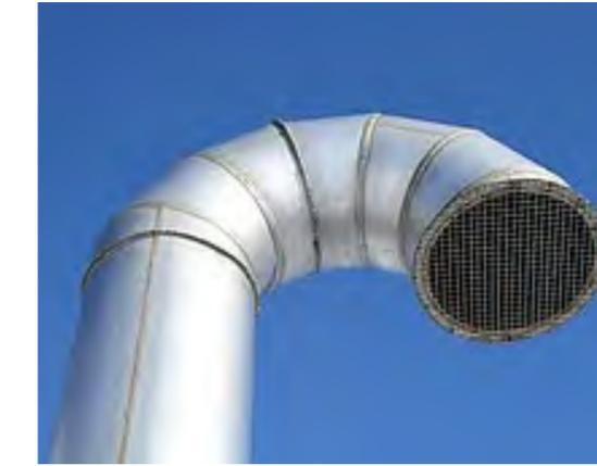
Tubería de ventilación para evitar malos olores en sanitarios.
