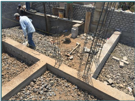
Imagen 6.2.- Representación de zapata corrida en una construcción.
