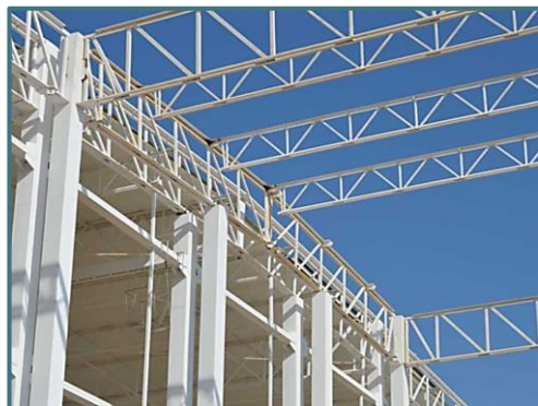
Imagen 6.5.- Sistema de multi-techo y armadura metálica.
