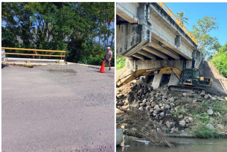
Figura 2.8. Desplazamientos laterales en el tablero y falla rotacional del estribo, El Ticuiz, Michoacán (GEER, 2022)
