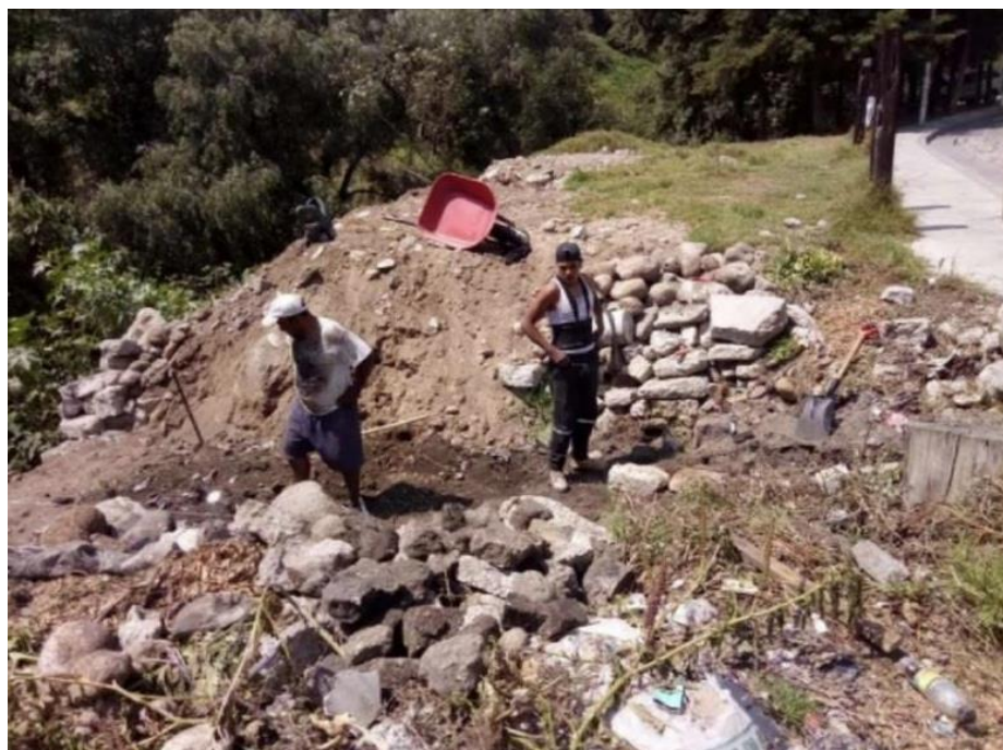
Fotografía 4. Inicio de la construcción del Área recreativa. 2020. Fotografía tomada por: Eugenio Tapia, vecino de la Mancha 1.
