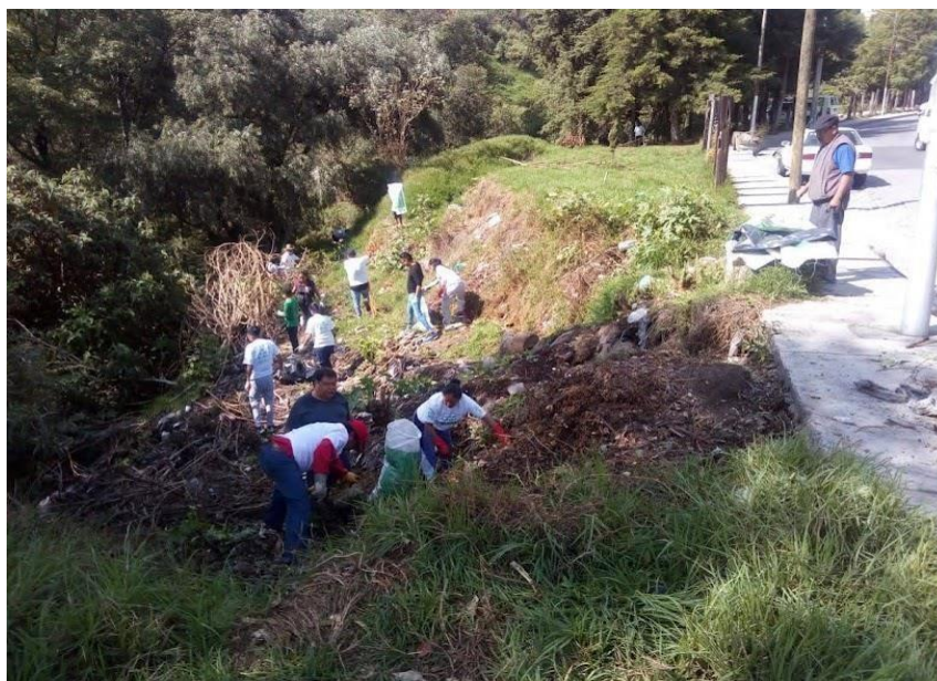
Fotografía 5. Inicio de la construcción del Área recreativa. 2020. Fotografía tomada por: Eugenio Tapia, vecino de la Mancha 1.
