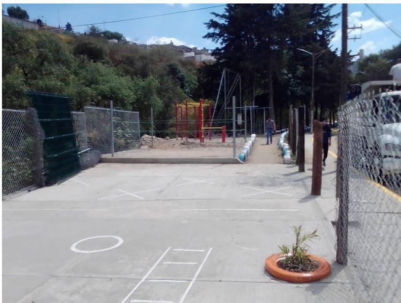
Fotografía 6. Inicio de la construcción del Área recreativa. 2020. Fotografía tomada por: Eugenio Tapia, vecino de la Mancha 1.
