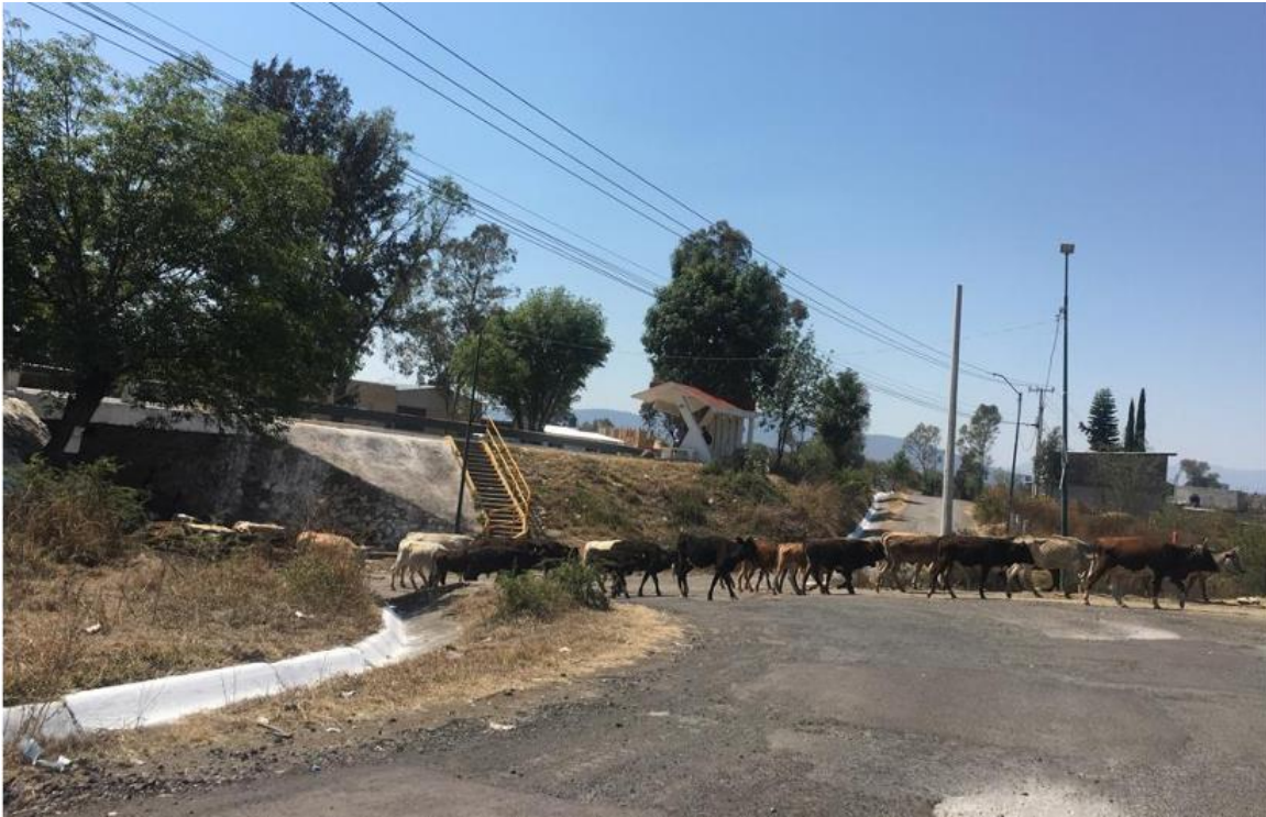
Figura 33. Se muestra el puente de Uruapilla, construido hace aproximadamente 10 años a petición de los agrosilvicultores, para poder trasladar entre localidades a los hatos de ganado a través de la carretera Morelia-Pátzcuaro.
