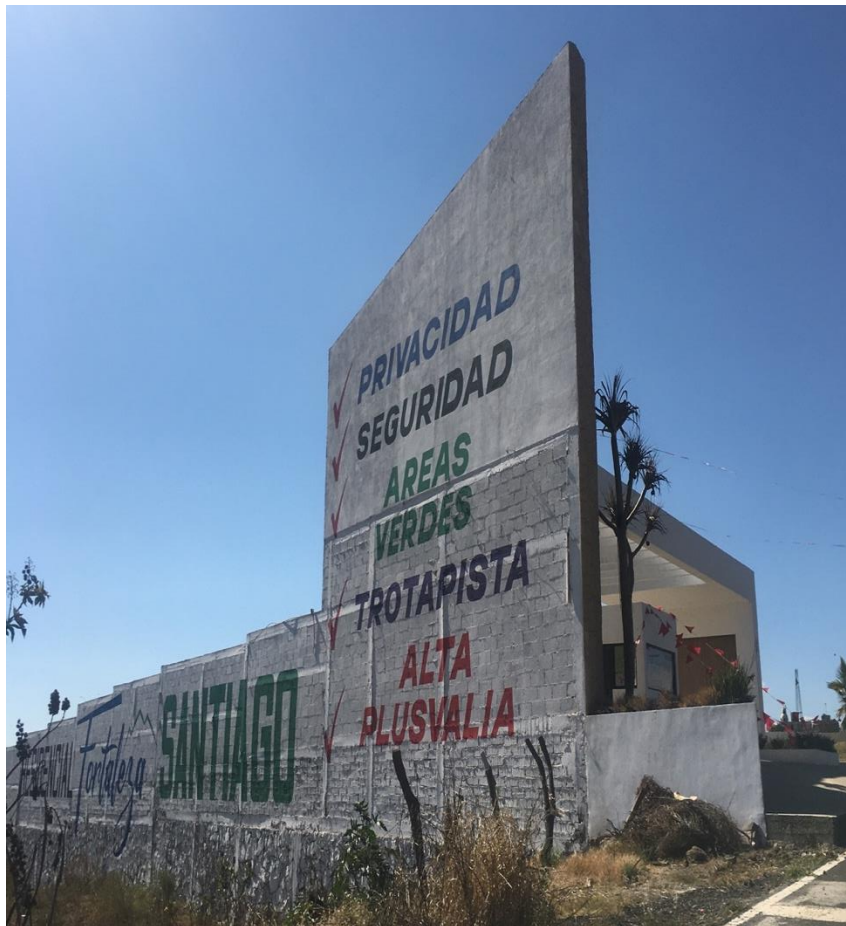
Figura 34. Vista de la construcción del fraccionamiento Fortaleza Santiago , sobre la carretera Morelia- Pátzcuaro, a 300 m de la entrada principal a la tenencia.
