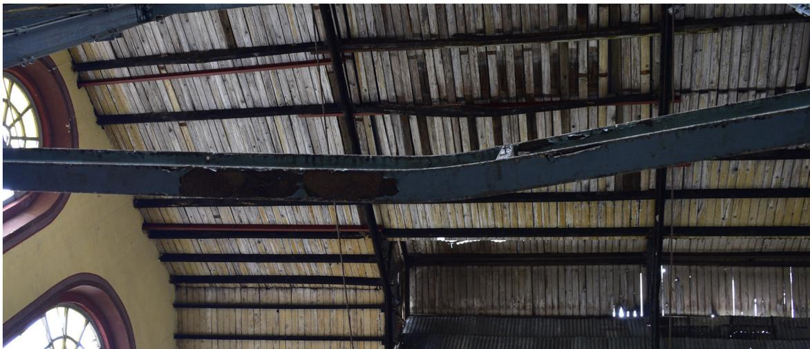
Imagen 19. Deformación de viga
