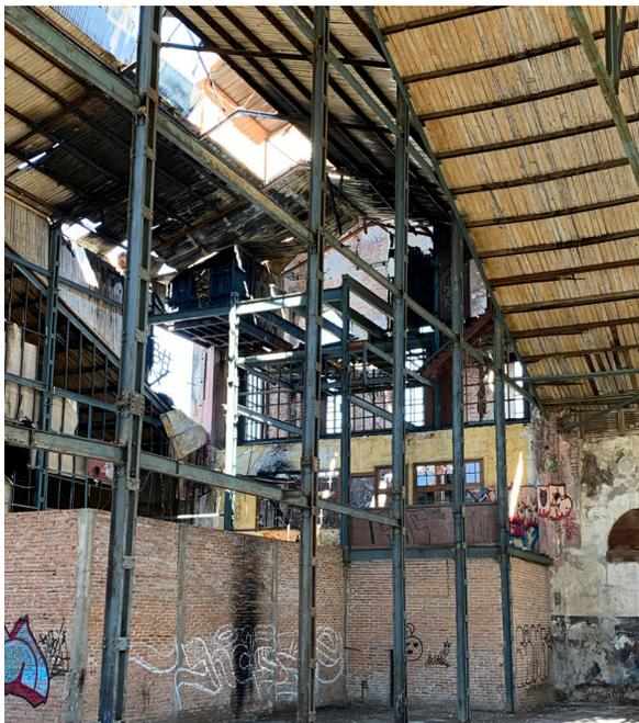
Imagen 33. El Buen Tono edificio-B, pérdida de cubierta a causa del incendio del 2020
