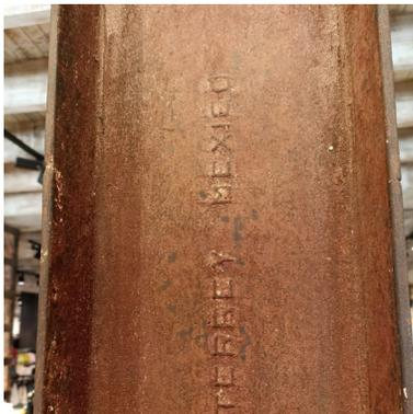
Imagen 20. Corrosión uniforme, columna al interior de un edificio en CDMX
