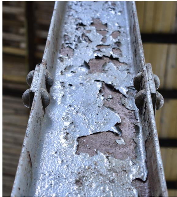
Imagen 15. Faltante de revestimiento, El Buen Tono
