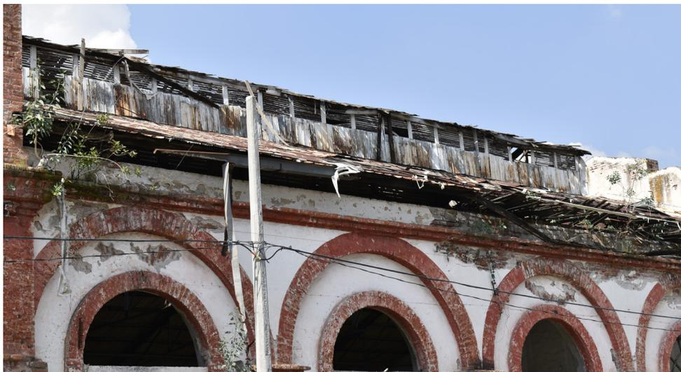
Imagen 31. El Buen Tono edificio-B, deterioros diversos en cubierta
