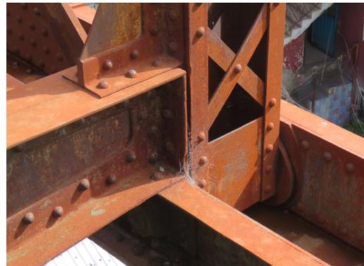
Imagen 21. Corrosión uniforme, componentes de un puente en Atencingo, Puebla
