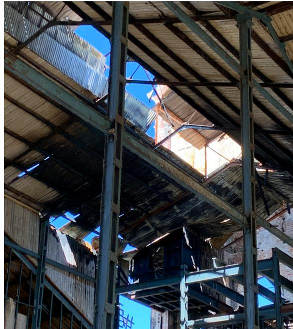
Imagen 34. El Buen Tono edificio-B, presencia de hollín generado por incendio del 2020
