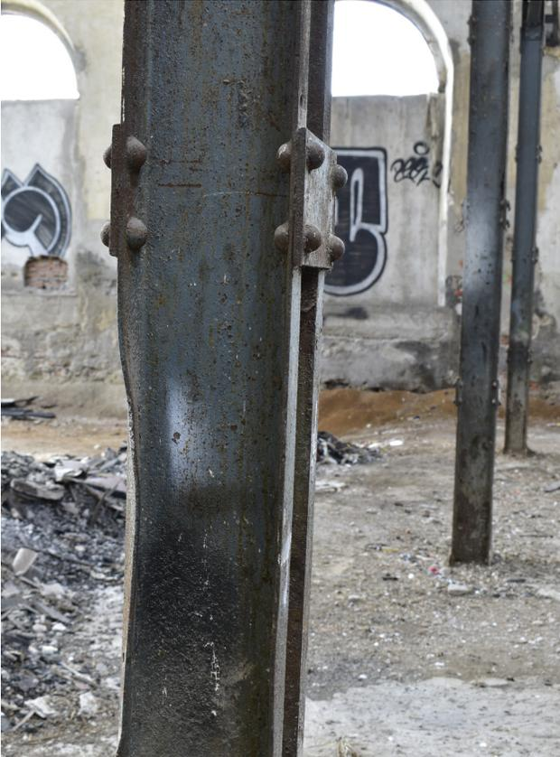
Imagen 17. Deformación de columna, El Buen Tono
