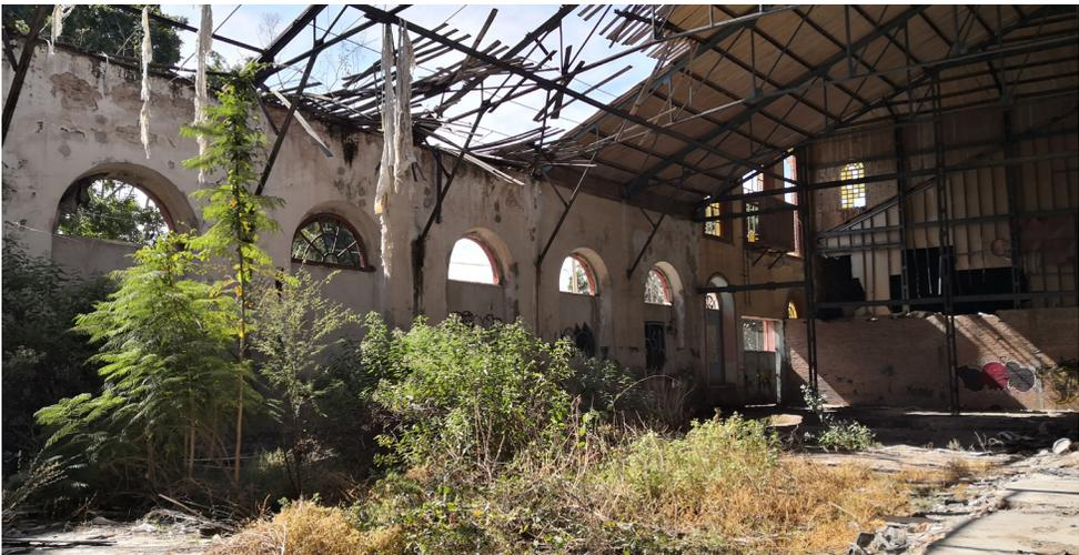
Imagen 30. El Buen Tono edificio-B, falta de mantenimiento, presencia de maleza y pérdida de componentes
