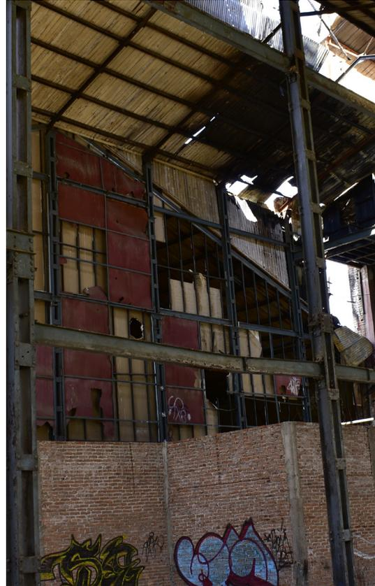
Imagen 18. Deformación de viga
