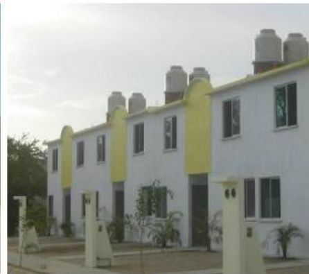
Vivienda sustentable de BRACSA
