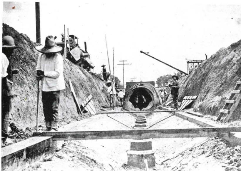
Figura 2. Construcción del acueducto que corría 29 kilómetros desde Santa Cruz Acalpíxca hasta la colonia Condesa. Tomado de Arechiga, 2004.
