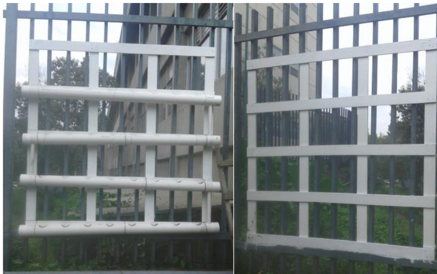
Figura 11. Colocación de bastidor y tubos de PVC.
