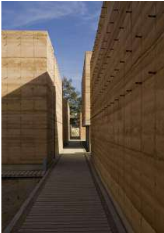
Pasillos interiores. Imagen de Luis Gordo, Archdaily.
