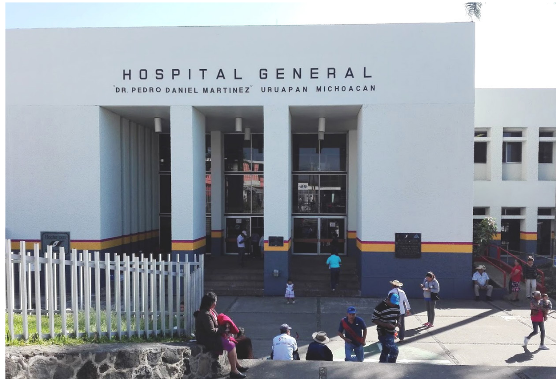
Fachada principal del Hospital General de Uruapan "Dr. Pedro Daniel Martínez".
