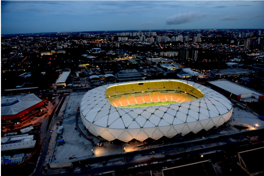
Figura 40. Brazilian Government–Portal da Copa (2014). Arena Amazonia vista desde el exterior. Ser turista. Recuperada de: https://serturista.com/wp-content/uploads/2014/06/Arena-da-Amazonia-1.jpg
