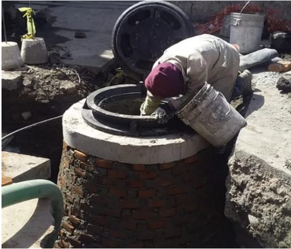
Imagen 26 Colocación de brocal
