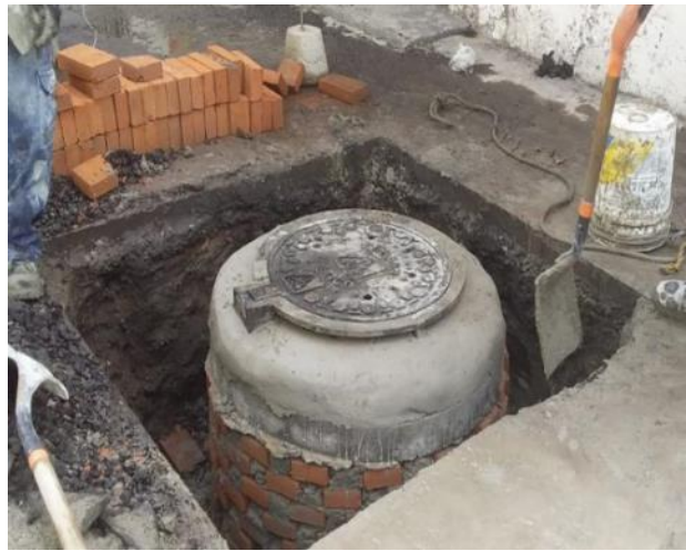
Imagen 27 Pozo de visita terminal
