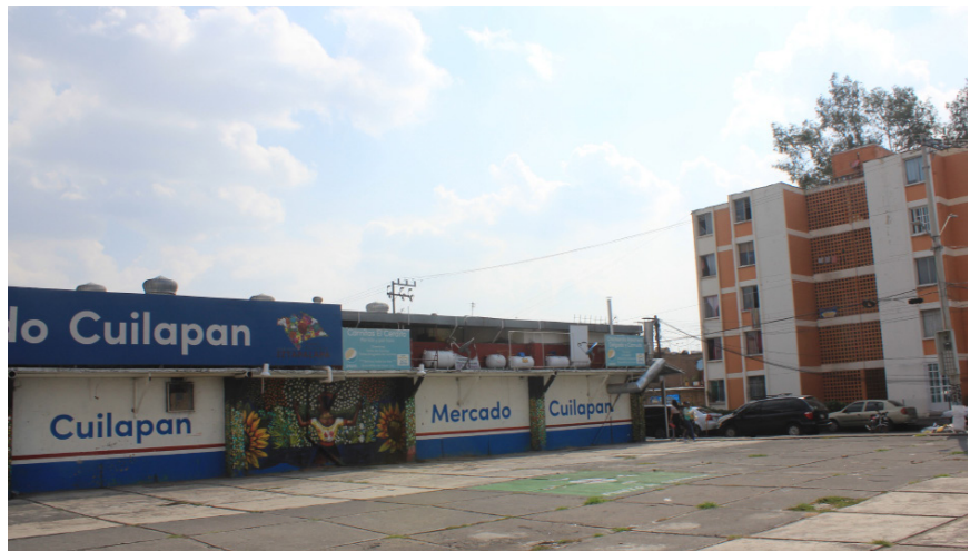
FIGURA 53: Mercado Cuilapan Descripción. Mercado en uso pero con falta de mantenimiento y nula activacion de espacios publico dispuesto al edificio.
