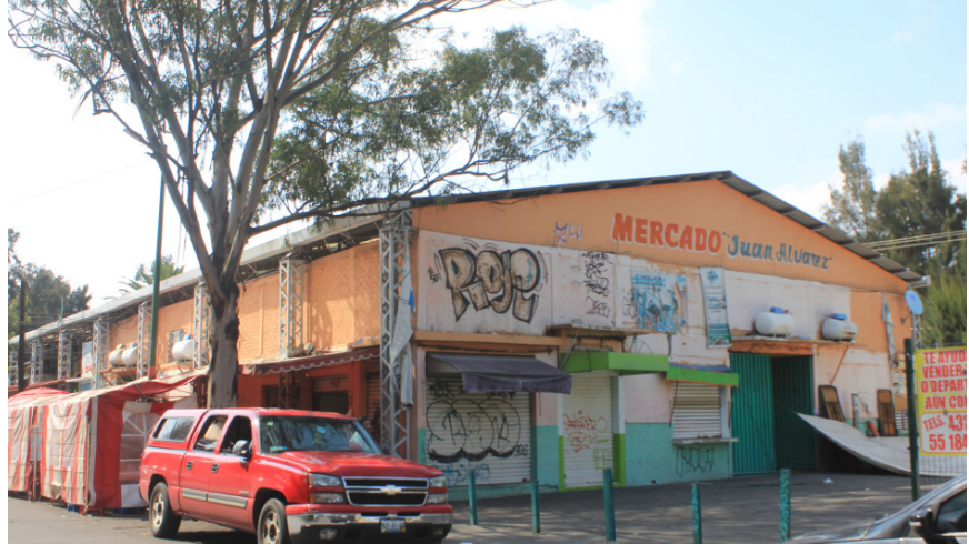
FIGURA 51: Mercado Juan Álvarez. Descripción. Mercado en uso pero con falta de mantenimiento y nula conexion con el exterior.
