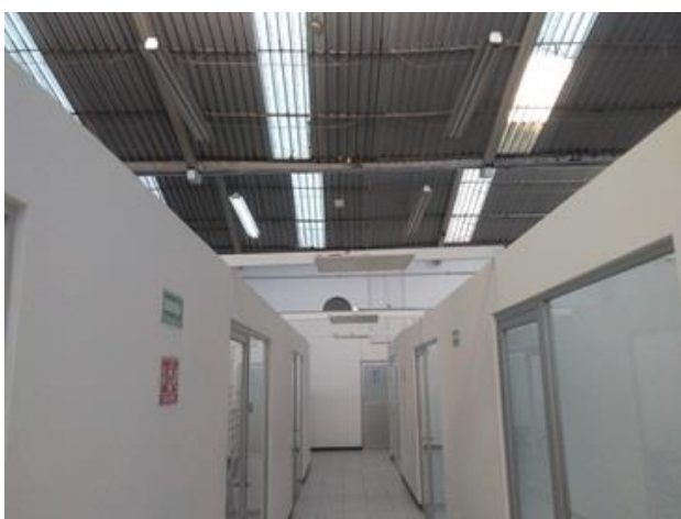
Figura 7. Bodega tras la remodelación.
