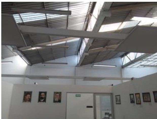
Figura 6. Bodega remodelada como aulas.
