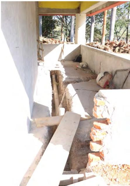
*Ensamble de conexiones PVC para tubería de instalación sanitaria.*
