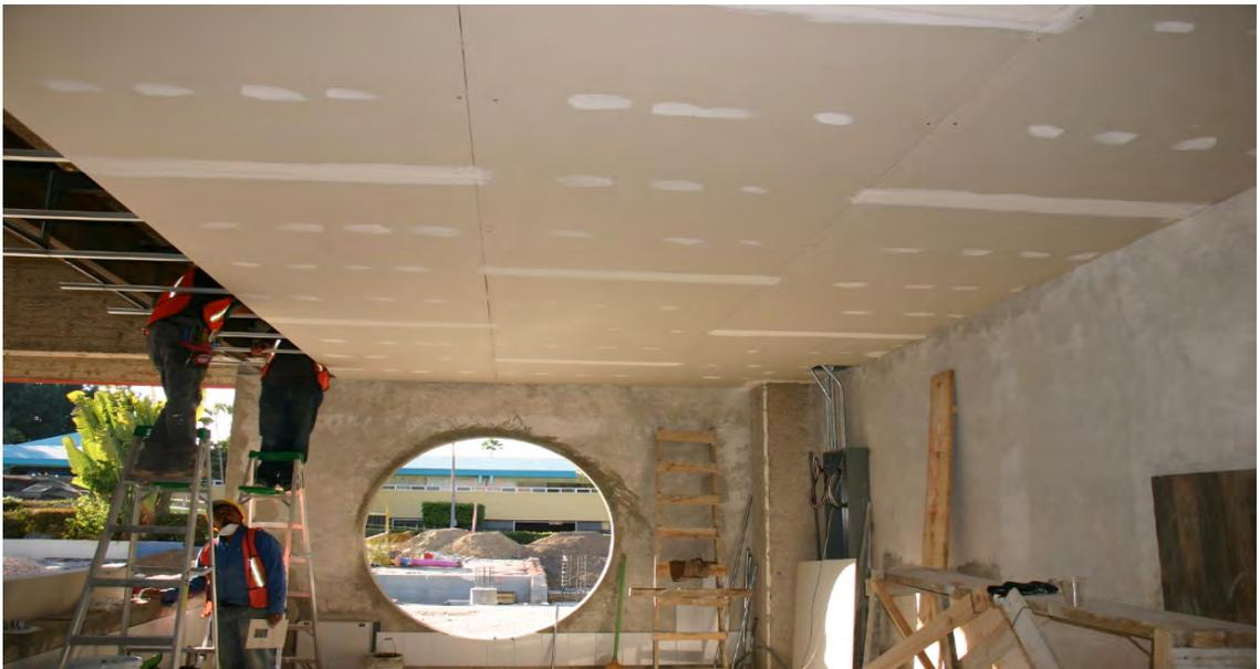
*Colocación de plafón ciego de tabla roca sobre estructura de PTR.*
