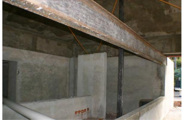
*Colocación de viga IPR en fachada frontal para refuerzo estructural y soporte de plafón y cortinas metálicas.*
