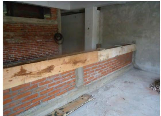
*Construcción de muro bajo para colocación de barra de acero inoxidable.*
