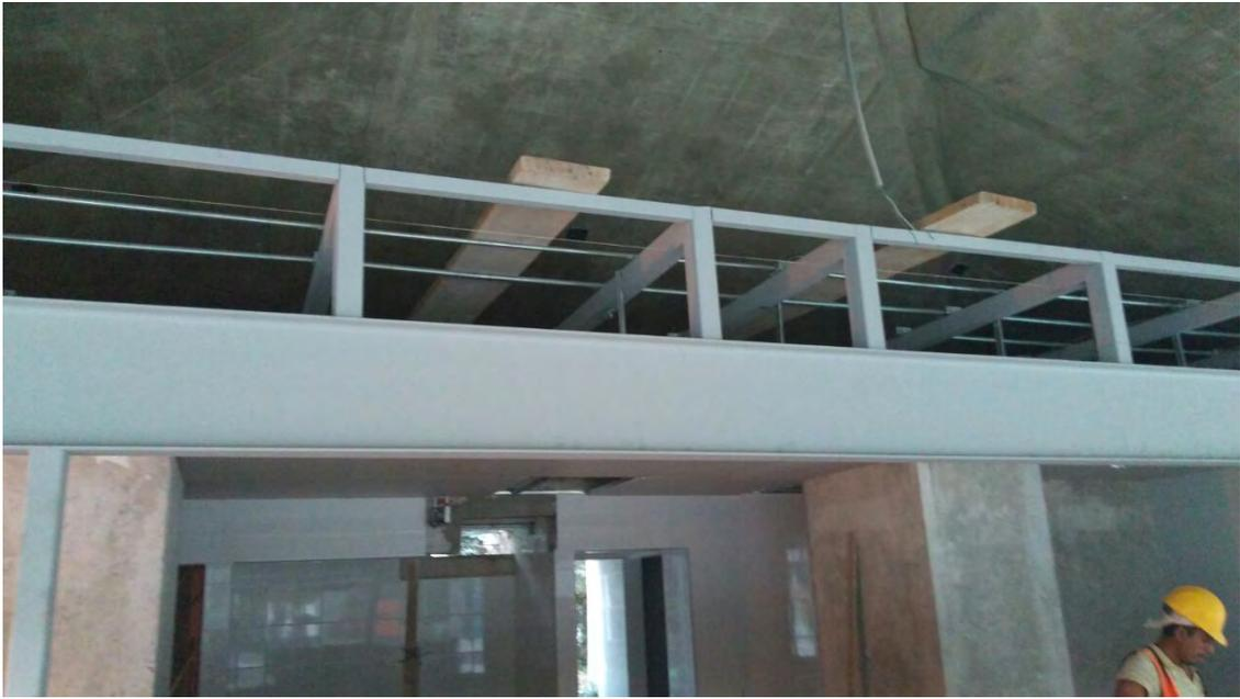
*Viga IPR colocada y pintada para soporte de estructura metálica para plafón de Tablaroca.*
