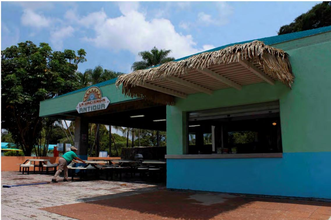
*Pérgola metálica cubierta con palma sintética.*
