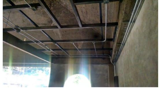
*Colocación de tubería para instalación eléctrica sobre estructura metálica.*
