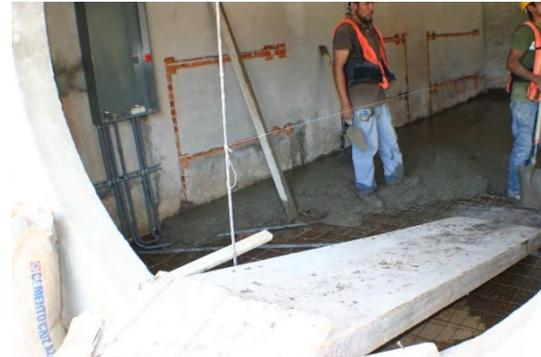
*Colocación de malla electro soldada previa al colado.*
