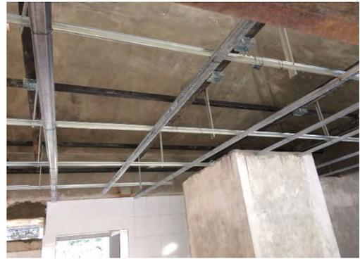
*Colocación de perfiles metálicos para soporte de plafón de Tablaroca.*
