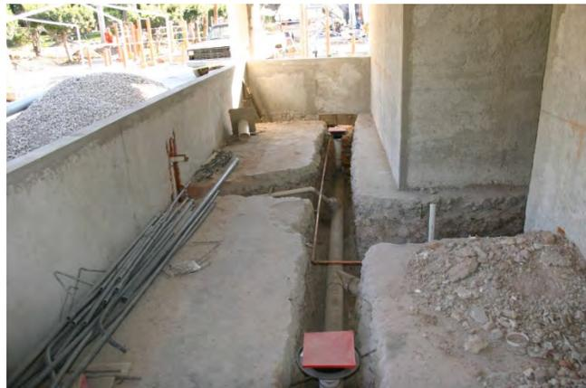
*Excavación para tubería sanitaria e hidráulica.*
