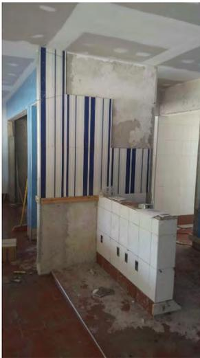
*Colocación de cerámico Kaleido Stripes Avío en muros laterales.*
