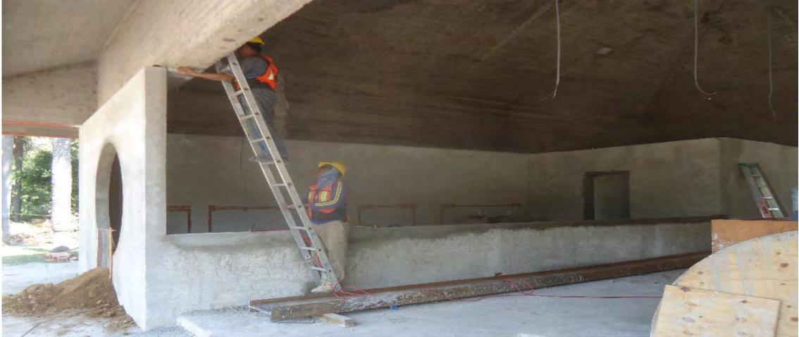
*Preparación de la superficie para montar la viga IPR.*
