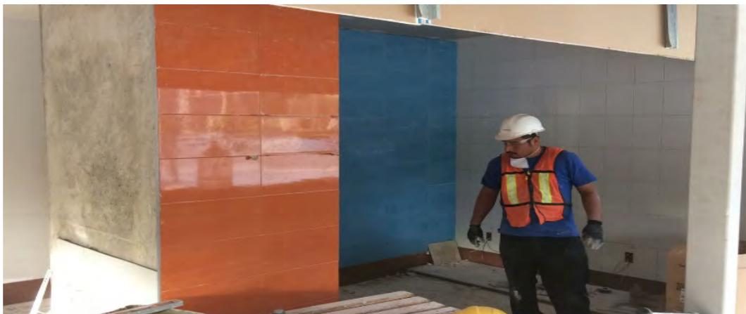
*Avance de trabajos de colocación de cerámico decorativo INTERCERAMIC Aquarelle Orange Earth en muros laterales.*
