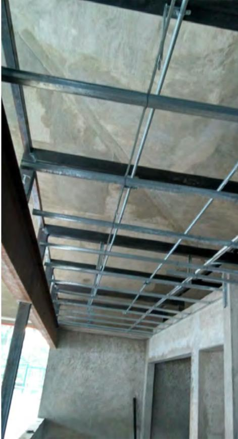
*Armado de estructura metálica para soporte de plafón de tabla roca.*
