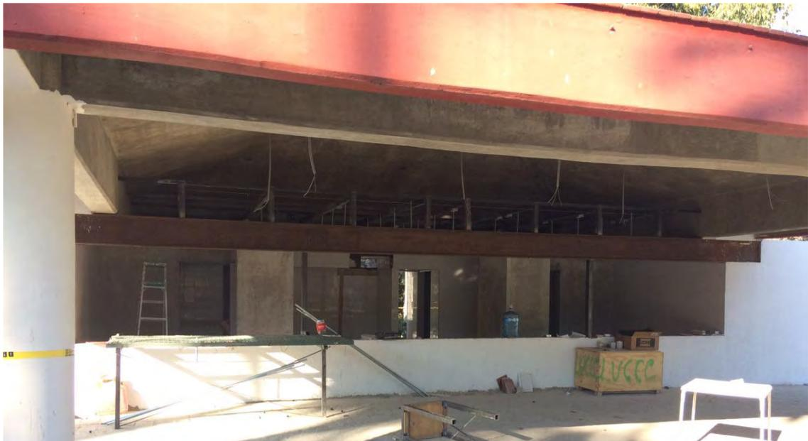
*Colocación de Viga IPR en fachada principal de Chicken Factory.*
