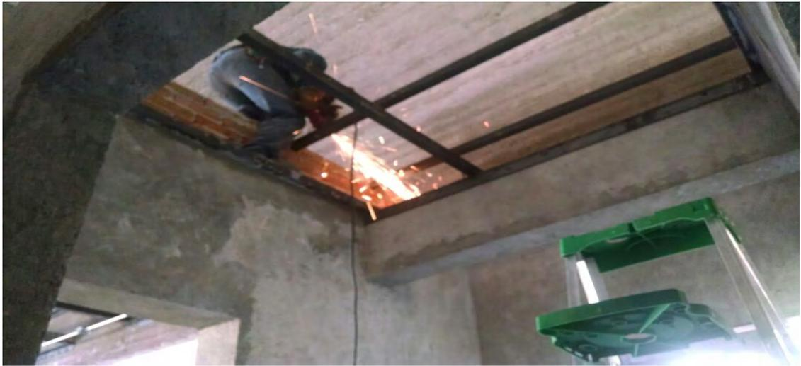
*Trabajos de soldadura en estructura metálica para fijarla al muro.*
