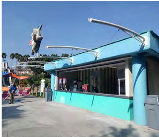
3 Perspectiva lateral de la fachada con la estructura lista para montar la malla sombra.
