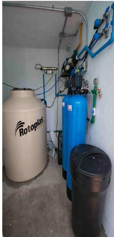
*A la derecha cuarto para filtros terminado con equipo instalado y a la izquierda área adecuada para máquina de hielos y calentador de agua para Chicken Factory.*
