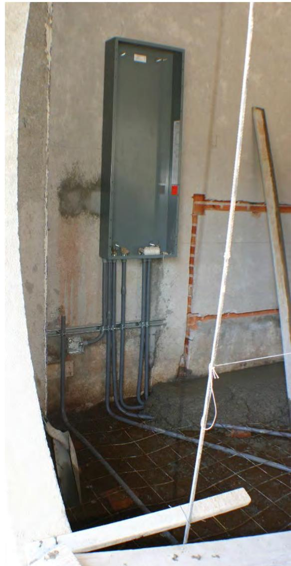
*Detalle de tubería para recibir cableado eléctrico.*
