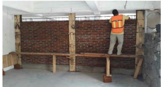
*Armado de castillos y traves para muro divisorio en el local H20.*
