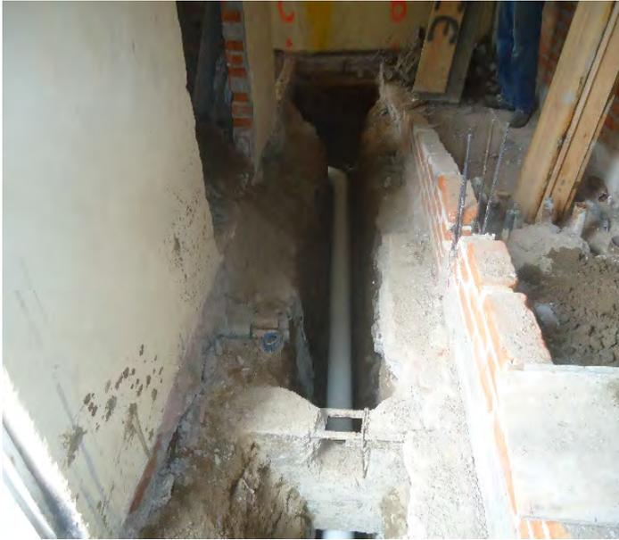
*Excavación para tubería sanitaria.*
