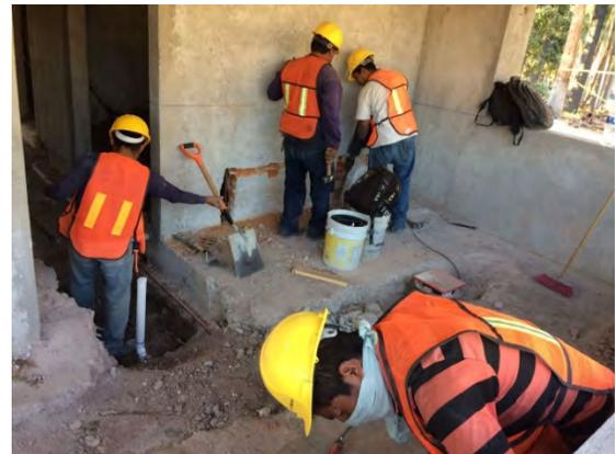
*Colocación de tubería de cobre para instalación hidráulica.*
