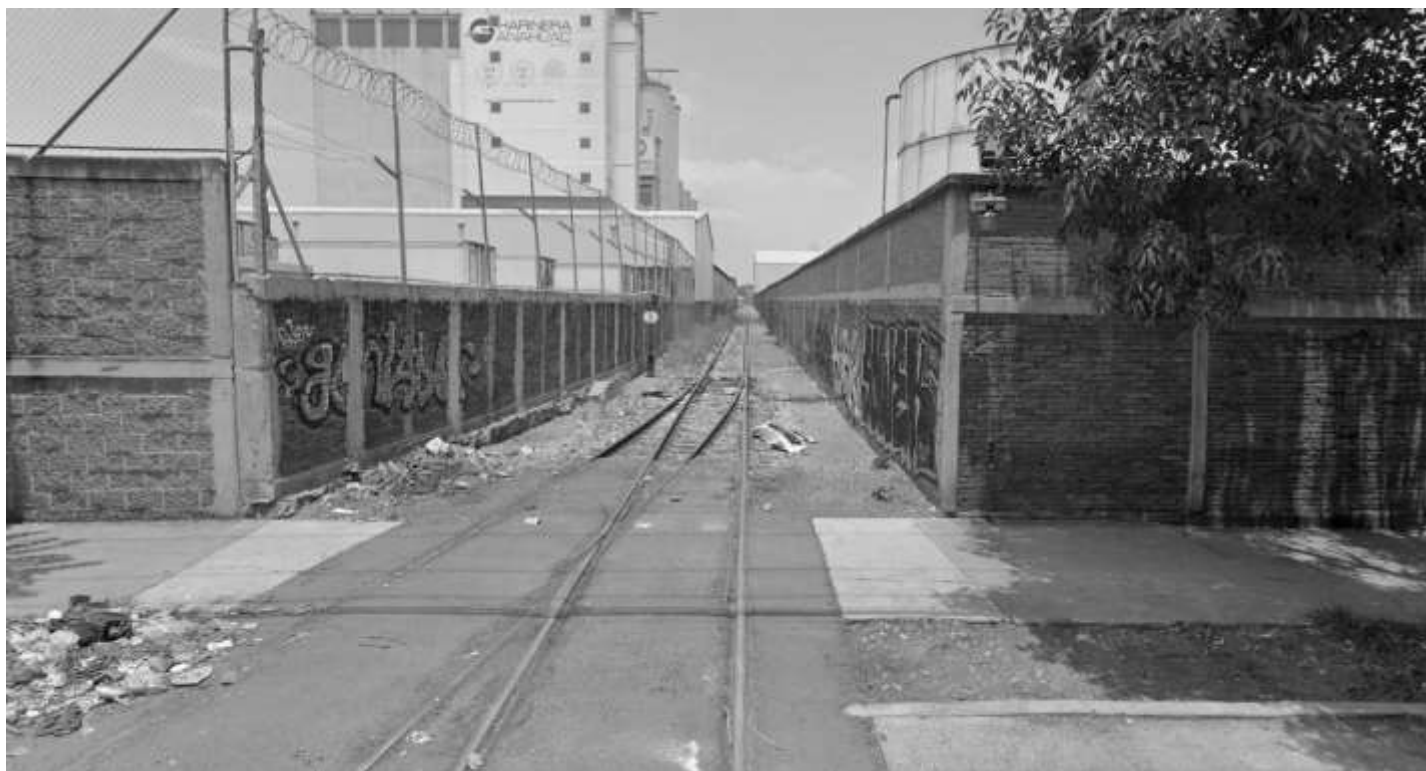
Imagen 48. Fotografía de vías férreas sobre Norte 59 Industrial Vallejo. Elaboración propia.
