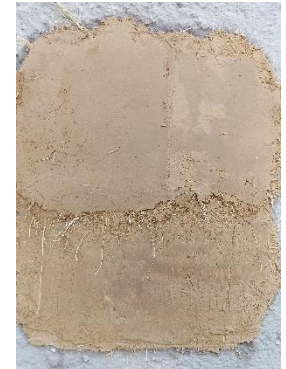
Aplanado de tierra. Fotografía: Velázquez, N.
