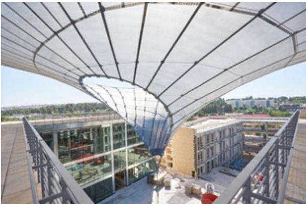
a. Cubierta captadora de agua pluvial.
