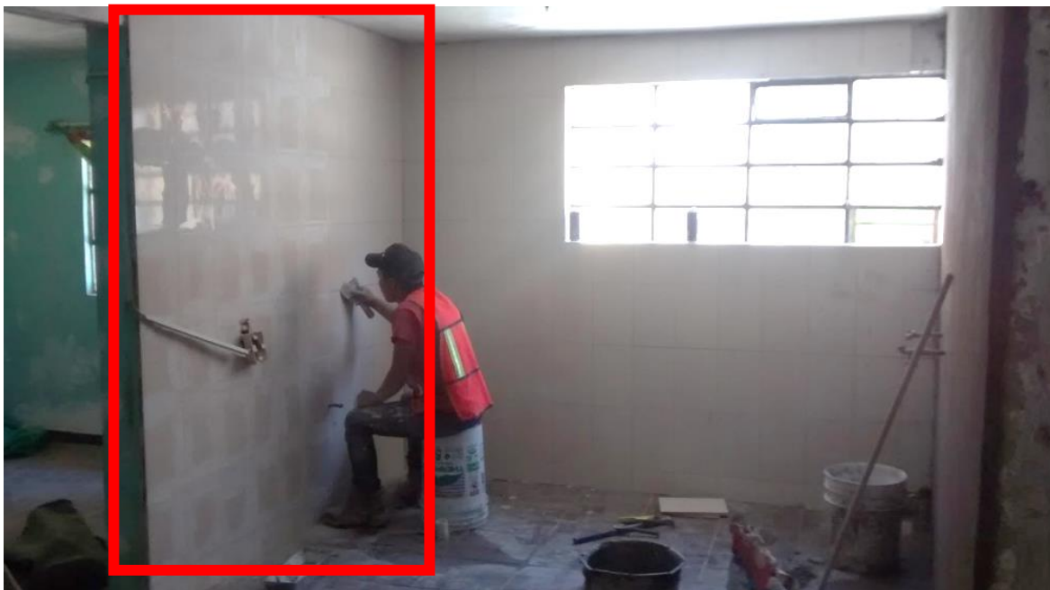
Imagen 26 Trabajador colocando tapajuntas en muro de la anécdota narrada, el muro que debería haber llevado malla se resalta en un recuadro rojo:
