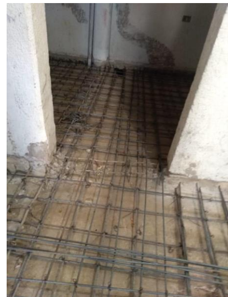
Imagen 23 Armado de losa de cimentación Fuente: Autoría propia
