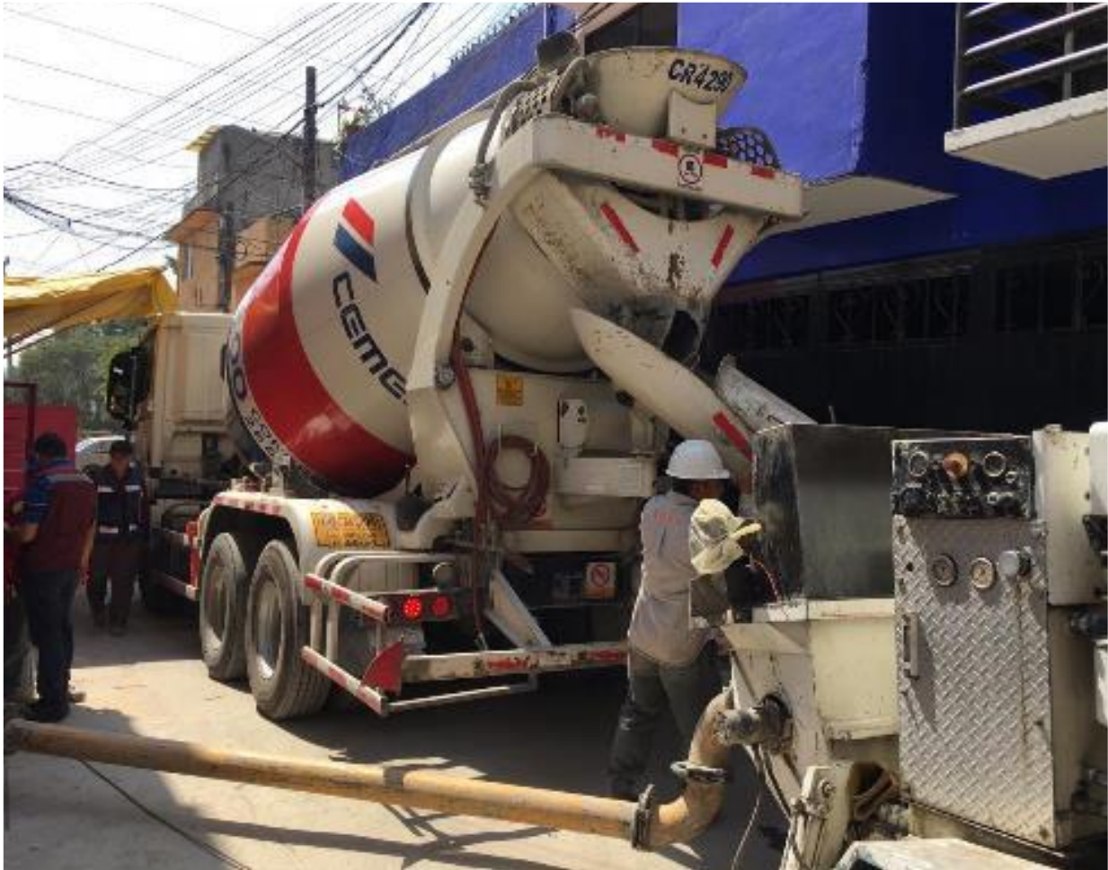
Imagen 25 Proceso de colado Fuente: Autoría propia
