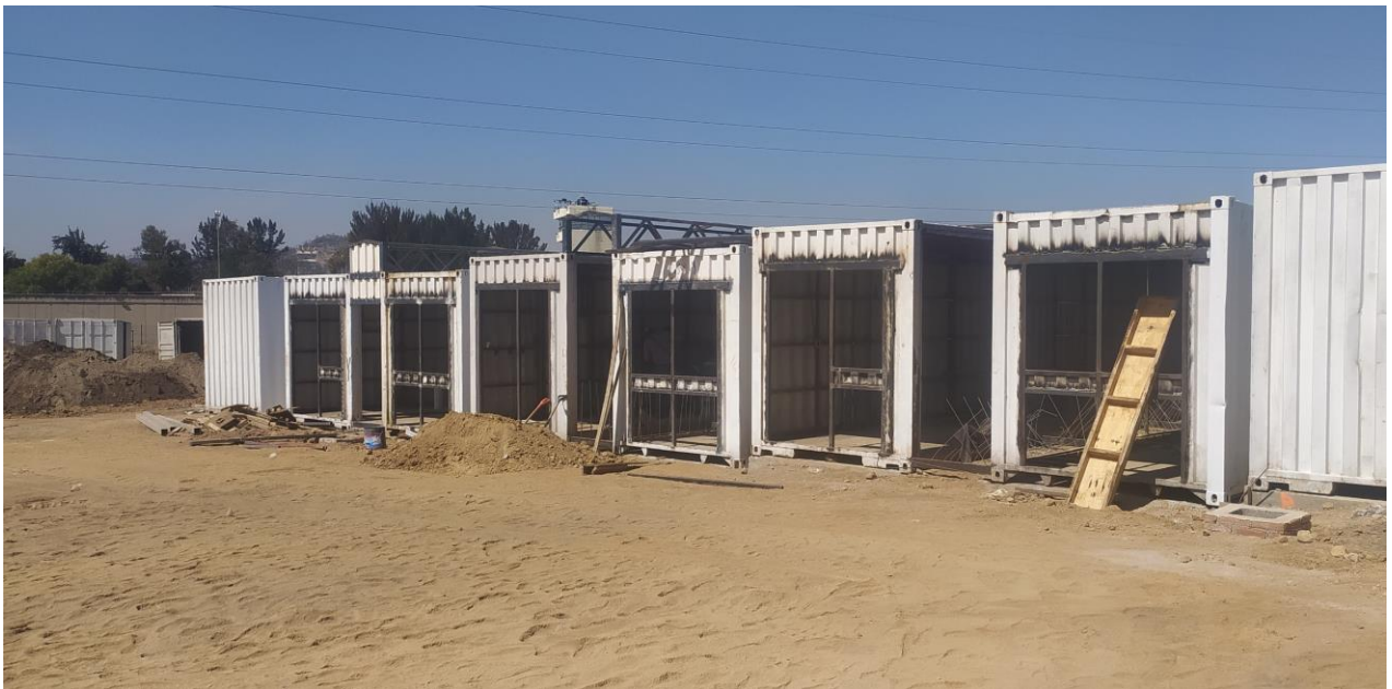
Imagen 65. Construcción de preparatoria transitoria tezonco en proceso Fuente: autoría propia
