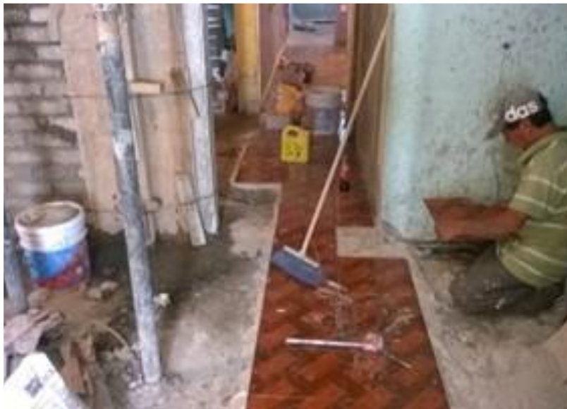
Imagen 22. Trabajador colocando loseta cerámica con pegazulejo y nivel Fuente: Autoría propia
