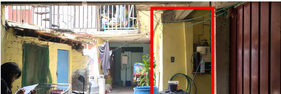
Imagen 17. Ejemplo de elementos estructurales que no desembocan en columnas y muros no colineales Fuente: Autoría propia
