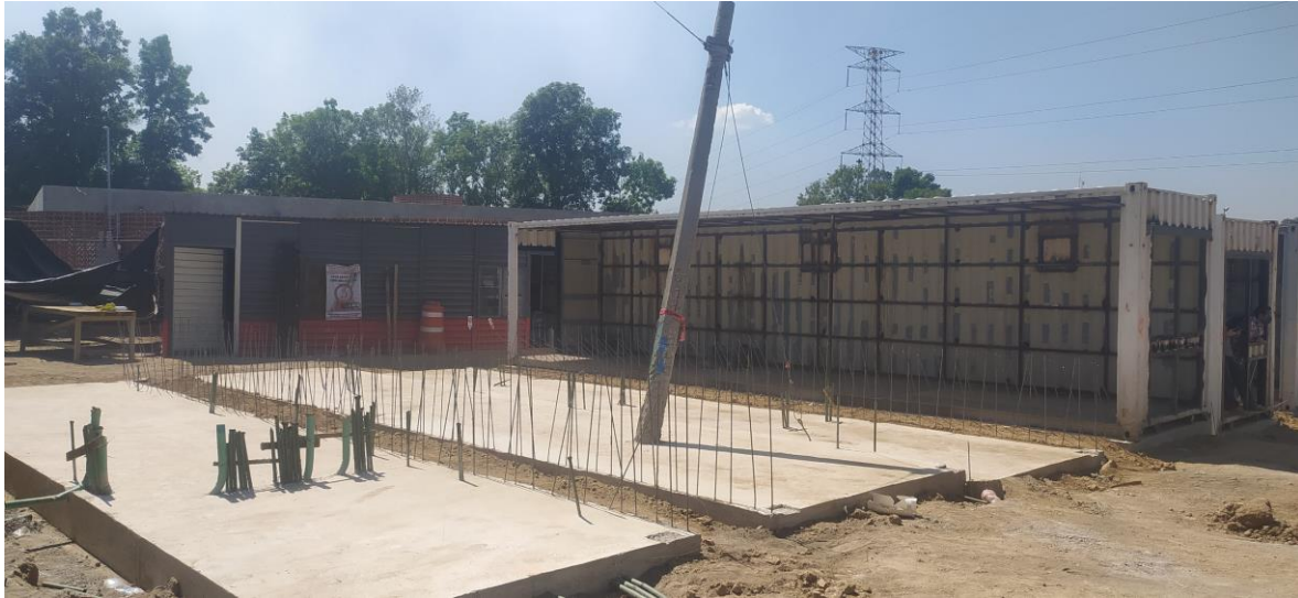
Imagen 62 Supervisión en obra Fuente: autoría propia
