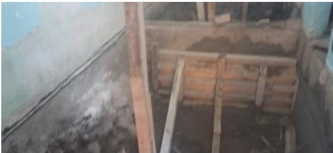
Imagen 24. Proceso de armado y colado de contratrabaje Fuente: Autoría propia
