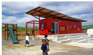
Vista de la fachada principal
