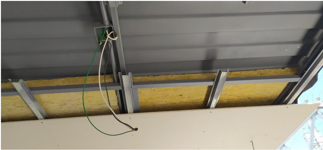
Imagen 06, detalle de relleno tomada en obra, Fuente: Autoría propia
